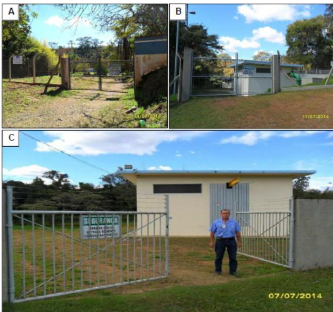
Figura 2: Pontos de Captação – Córregos Feio, Fundo e Areia Fonte: PMSB Araxá – DRZ Geotecnologia e Consultoria (2016)
