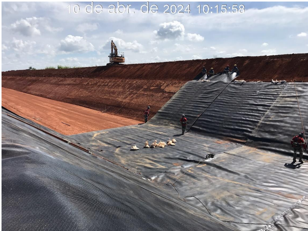
Figura 7.15 – Aplicação da geomembrana na região da estaca 150 do canal periférico (10/04/2024).
