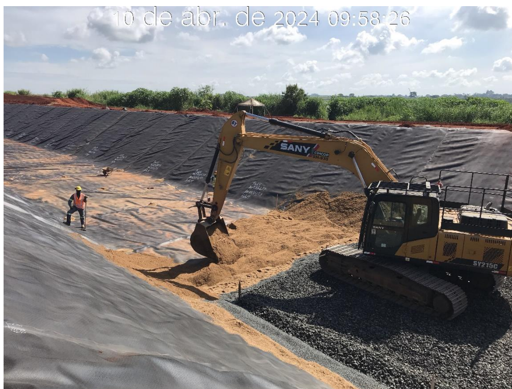
Figura 7.19 – Início da aplicação das transições 1 (areia), 2 (brita 0) e 3 (brita 3) sobre a geomembrana do canal periférico, na região da estaca 138 (10/04/2024).
