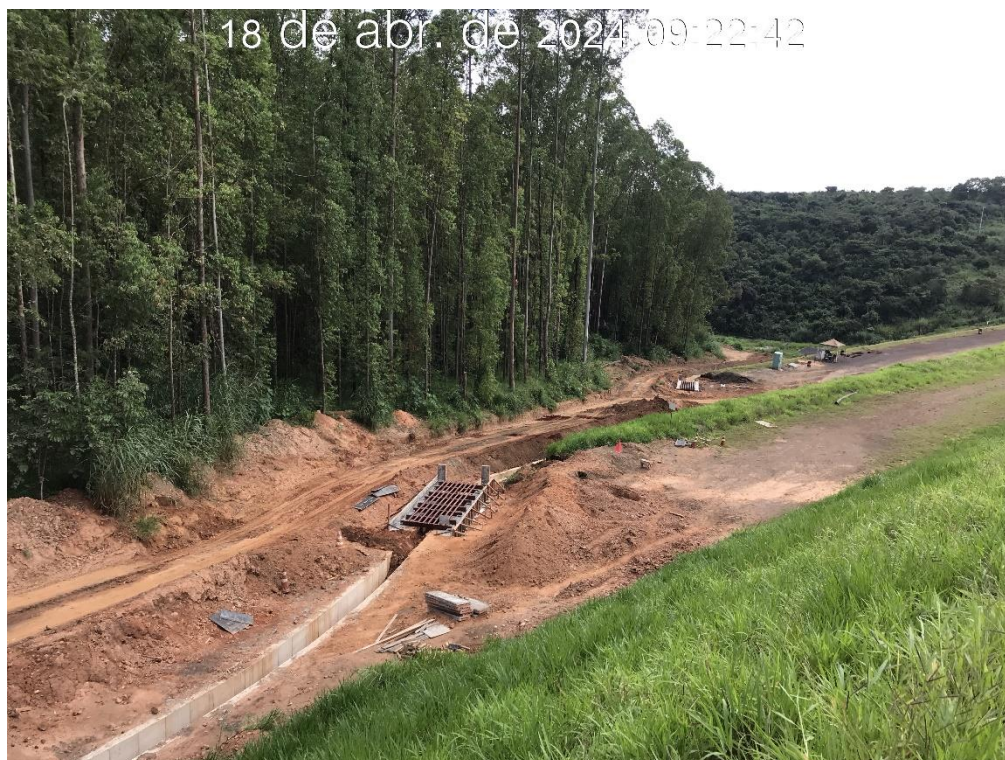
Figura 7.43 – Vista para jusante do canal de drenagem superficial da ombreira esquerda, com detalhe da Instalação das travessias “mata-burro”, nas elevações 920,00 m e 913,00 m (18/04/2024).
