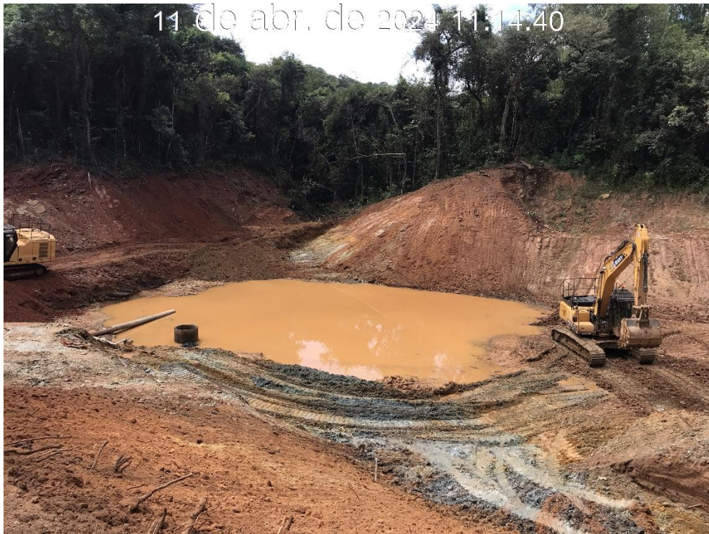
Figura 7.30 – Escavação da bacia de dissipação do canal rápido (11/04/2024).
