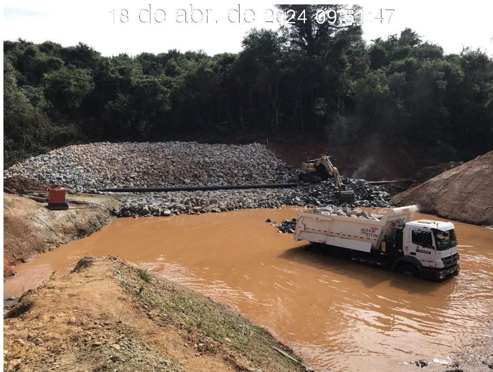
Figura 7.34 – Aplicação da camada de proteção (enrocamento) na bacia de dissipação do canal rápido, com vista para jusante (18/04/2024).
