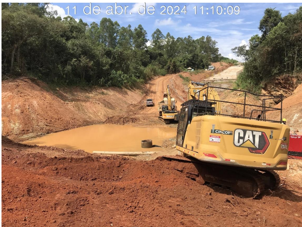
Figura 7.31 – Escavação da bacia de dissipação do canal rápido, com vista para montante (11/04/2024).
