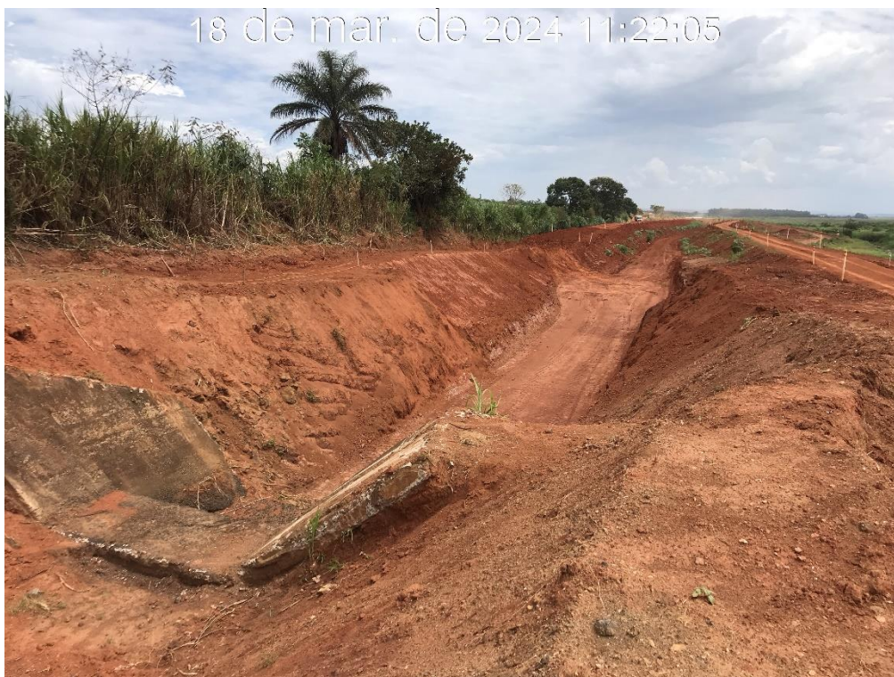
Figura 7.4 – Escavação na transição entre o canal existente e o canal periférico, na região da estaca 22 com vista para jusante (18/03/2024).
