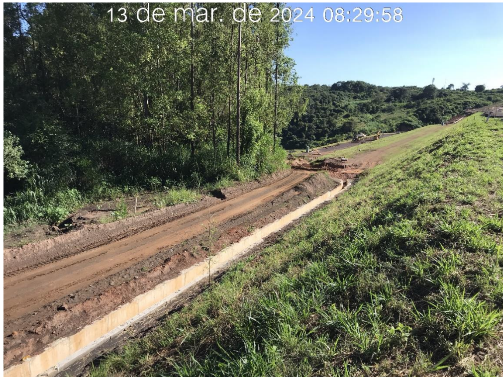
Figura 7.39 – Vista para jusante do canal de drenagem superficial da ombreira esquerda, entre os módulos 11 e 15 (13/03/2024).
