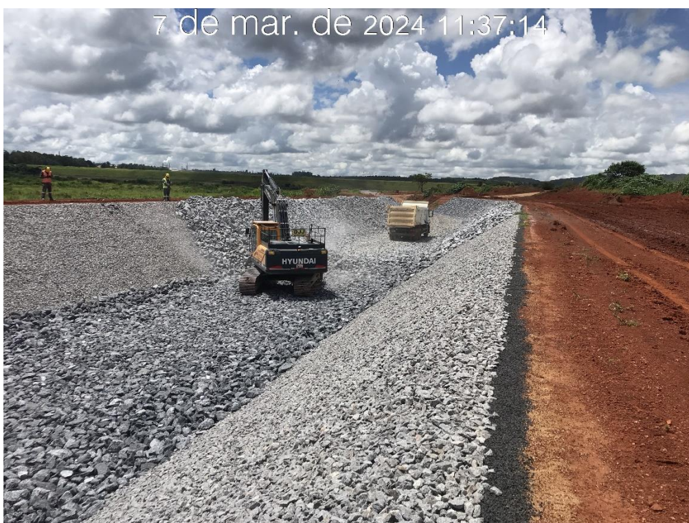
Figura 7.9 – Aplicação da camada de proteção (enrocamento), na região da estaca 65 do canal periférico, com vista para montante (07/03/2024).
