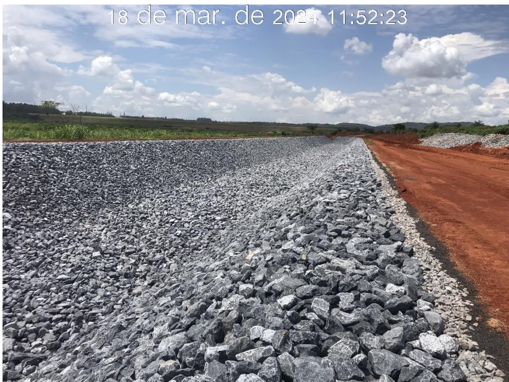
Figura 7.11 – Vista para montante do canal periférico, após o término da aplicação da camada de proteção (18/03/2024).
