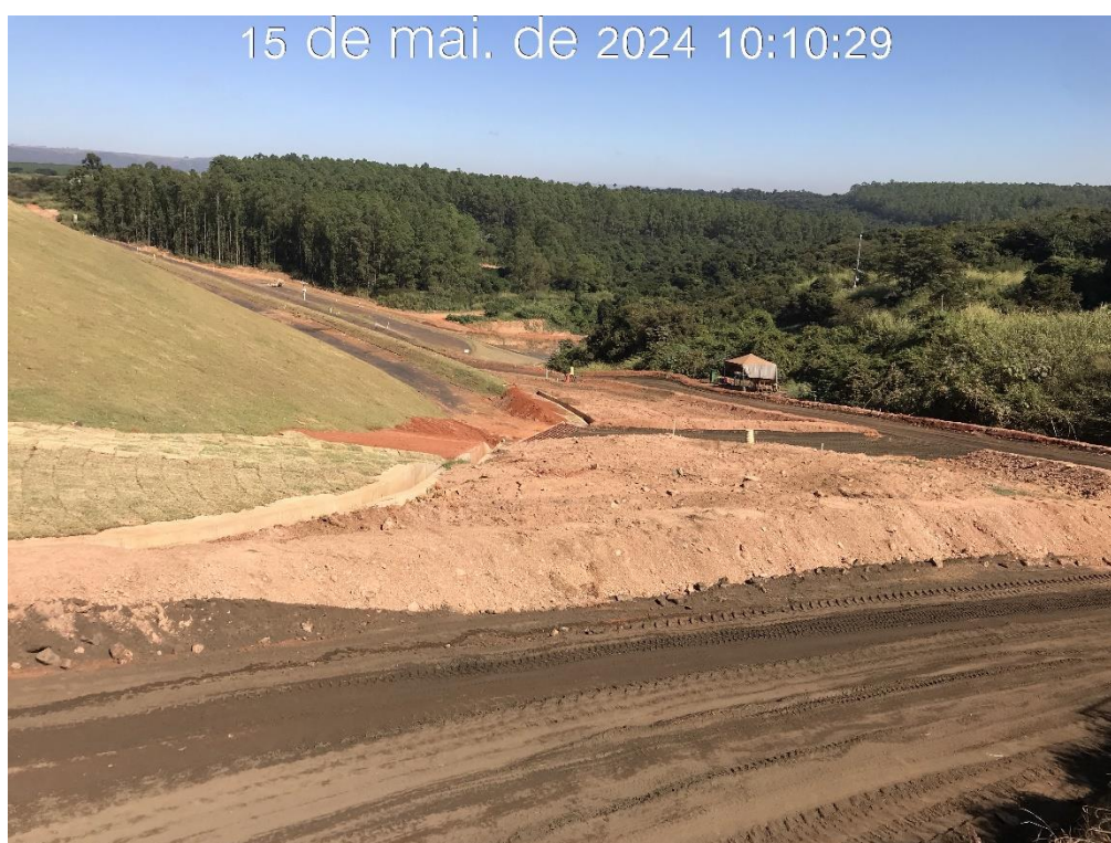
Figura 7.48 – Vista panorâmica, para jusante do canal de drenagem superficial da ombreira direita (15/05/2024).
