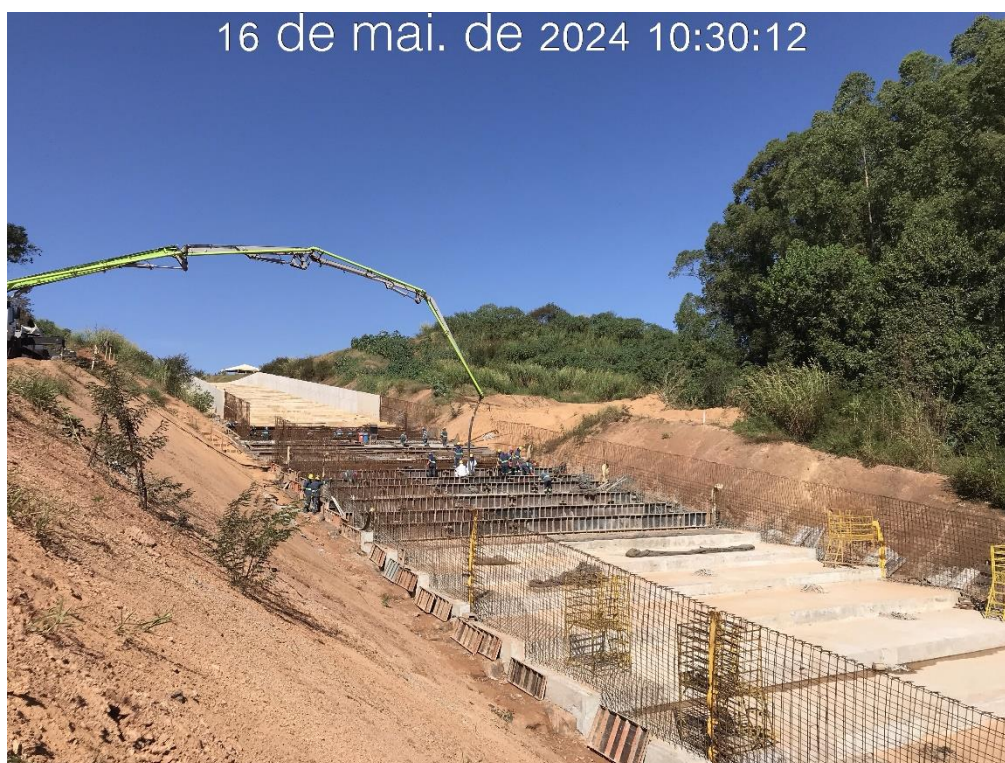
Figura 7.29 – Concretagem no piso do módulo 33 do canal rápido, com vista para montante (16/05/2024).
