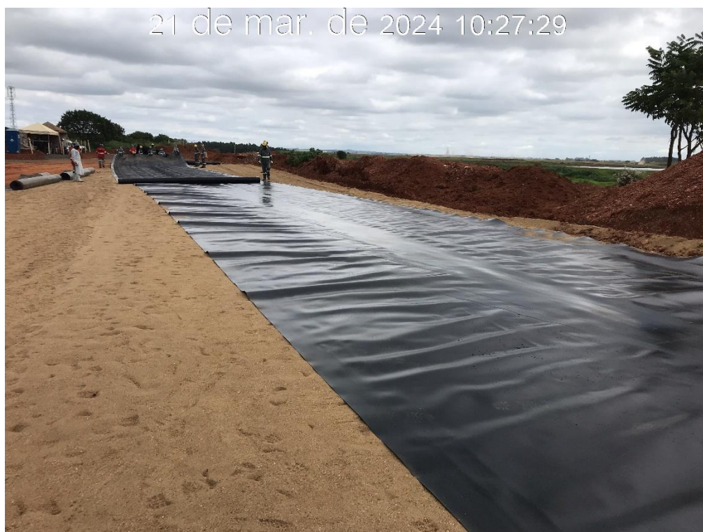
Figura 7.14 – Preparação e modulação da geomembrana, para aplicação entre as estacas 135 e 170 do canal periférico (21/03/2024).
