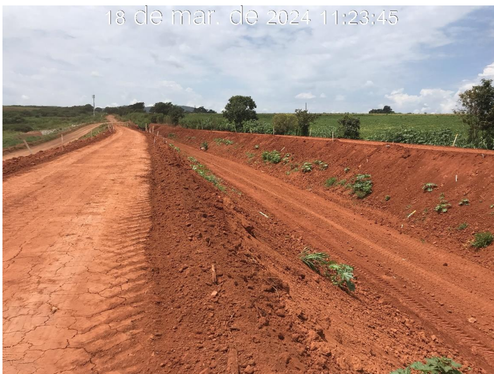
Figura 7.5 – Vista para montante do canal periférico, entre a estaca 22 e 43 após término do aterro (18/03/2024).
