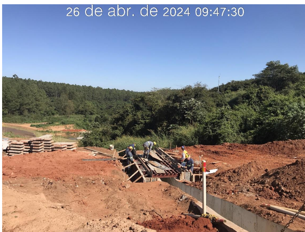
Figura 7.44 – Instalação da travessia “mata-burro” na elevação 930,00 m do canal de drenagem superficial da ombreira direita (15/04/2024).
