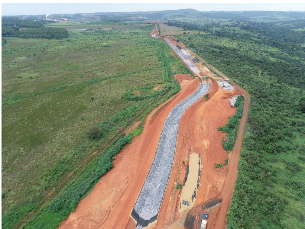
Figura 7.13 – Vista panorâmica do canal periférico, entre as estacas 22 e 130 (20/03/2024).
