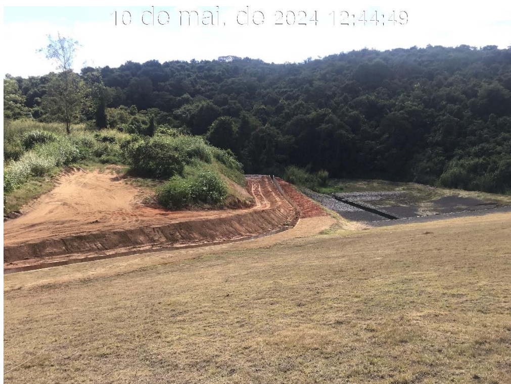
Figura 7.46 – Vista panorâmica, para jusante do canal de drenagem superficial da ombreira esquerda (10/05/2024).
