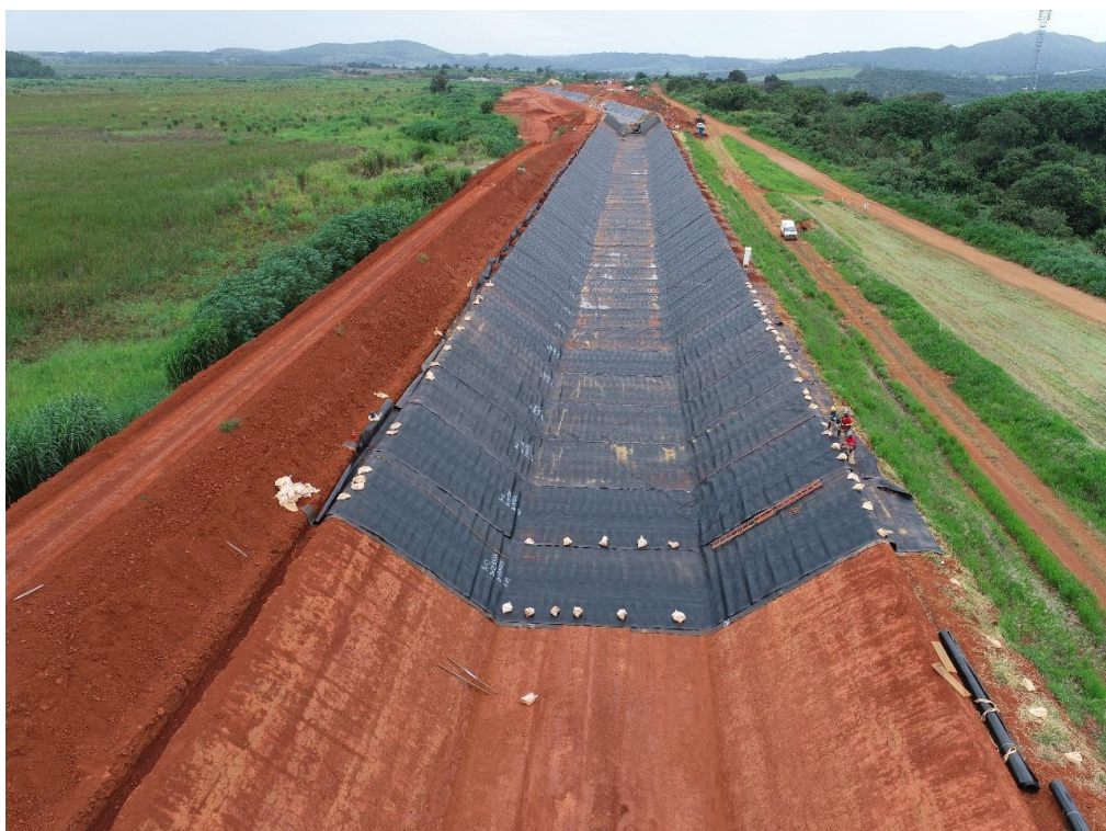
Figura 7.16 – Vista panorâmica para montante do canal periférico, com detalhe da aplicação da geomembrana entre as estacas 135 e 150 (10/04/2024).
