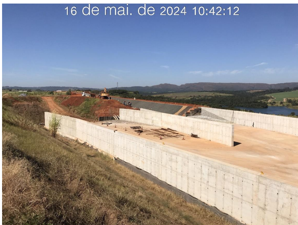
Figura 7.27 – Vista panorâmica para montante das transições 1 e 2 do canal rápido (16/05/2024).
