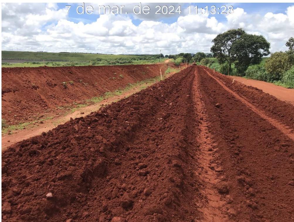
Figura 7.2 – Aplicação de material argiloso na camada de aterro do canal periférico, entre as estacas 22 e 43 (07/03/2024).
