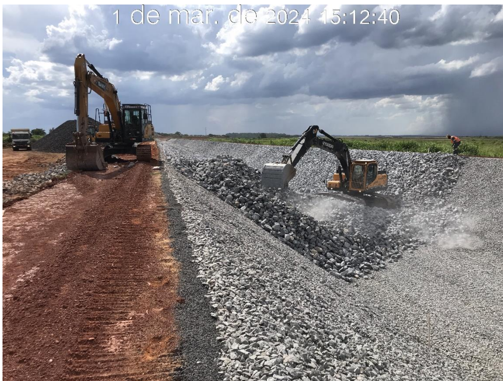
Figura 7.8 – Aplicação da camada de proteção (enrocamento), na região da estaca 70 do canal periférico, com vista para jusante (01/03/2024).
