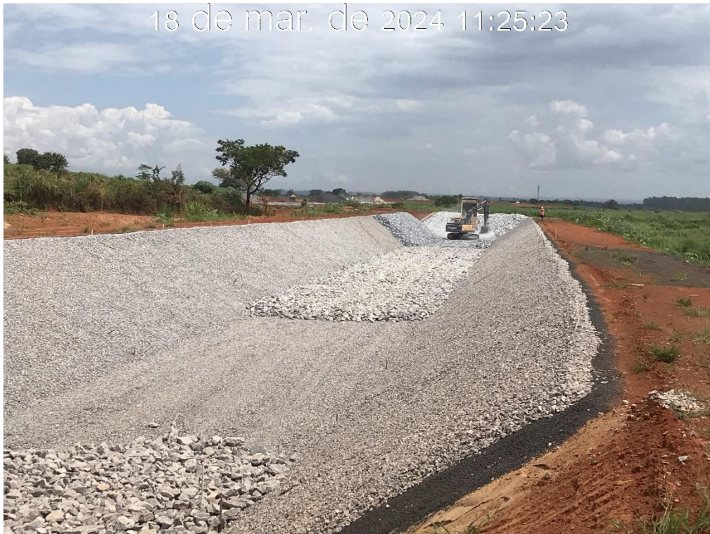
Figura 7.10 – Aplicação da camada de proteção (enrocamento), na região da estaca 49 do canal periférico, com vista para jusante (18/03/2024).
