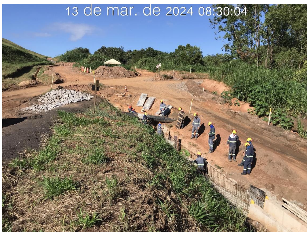
Figura 7.38 – Montagem de forma e ferragem nos módulos 09 e 10 do canal de drenagem superficial da ombreira esquerda, com vista para montante (13/03/2024).
