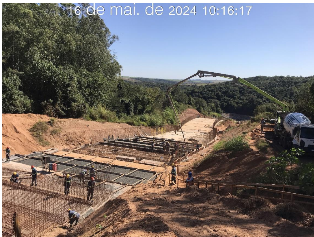
Figura 7.28 – Concretagem no piso do módulo 33 do canal rápido, com vista para jusante (16/05/2024).
