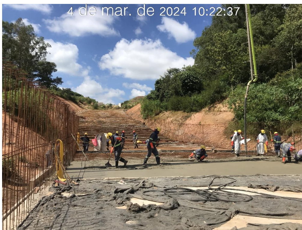
Figura 7.23 – Concretagem do piso do módulo 23 do canal rápido, com vista para montante (04/03/2024).
