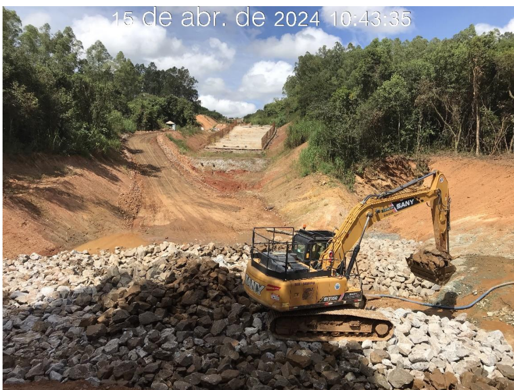
Figura 7.33 – Aplicação da camada de proteção (enrocamento) na bacia de dissipação do canal rápido, com vista para montante (15/04/2024).
