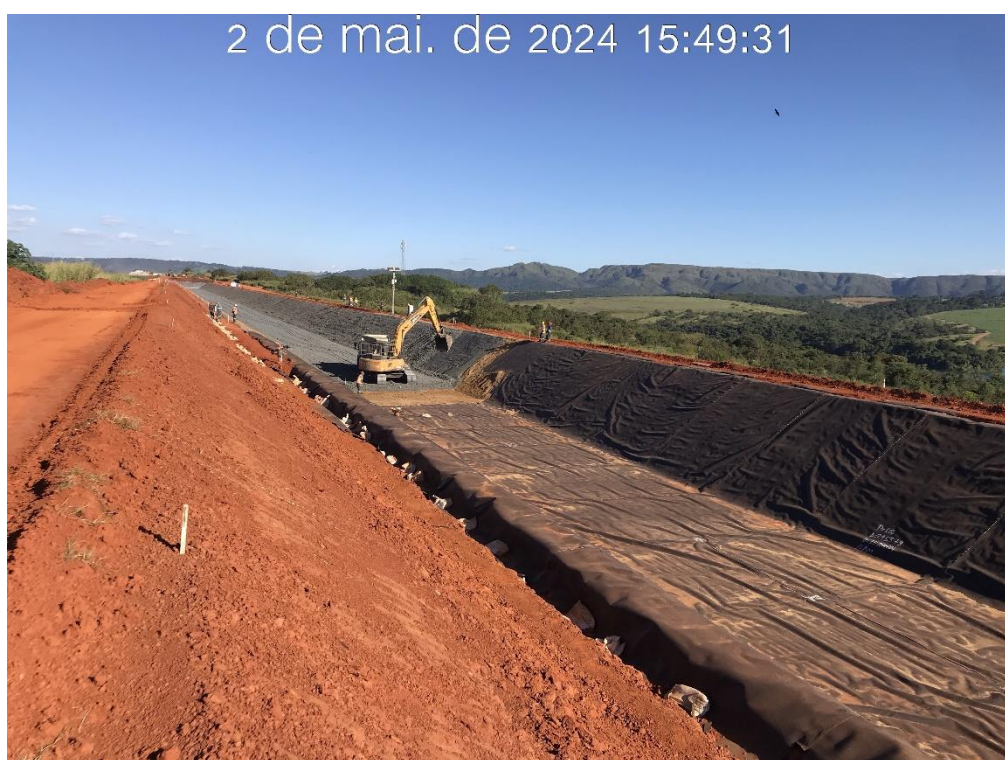
Figura 7.20 – Aplicação das transições 1 (areia), 2 (brita 0) e 3 (brita 3) sobre a geomembrana do canal periférico, com vista para montante (02/05/2024).
