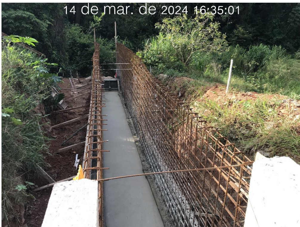
Figura 7.41 – Concretagem do piso da bacia de dissipação do canal de drenagem superficial da ombreira esquerda (14/03/2024).
