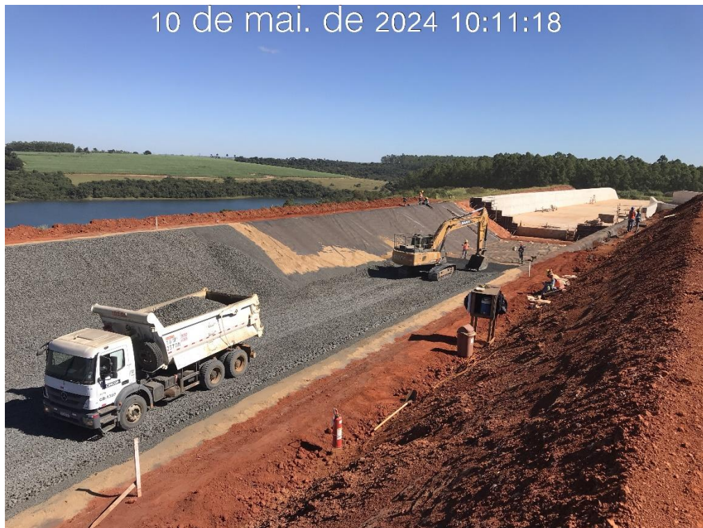
Figura 7.21 – Término da aplicação das transições 1 (areia), 2 (brita 0) e 3 (brita 3) sobre a geomembrana, com vista para jusante (10/05/2024).
