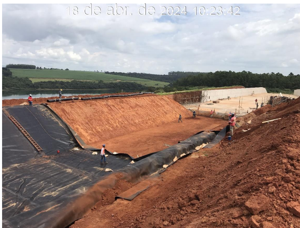
Figura 7.17 – Término da aplicação da geomembrana no canal periférico, na região da estaca 170 com vista para jusante (18/04/2024).
