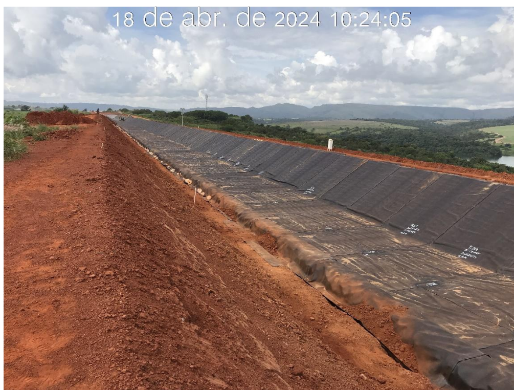
Figura 7.18 – Vista para montante do canal periférico, após término da aplicação da geomembrana (18/04/2024).
