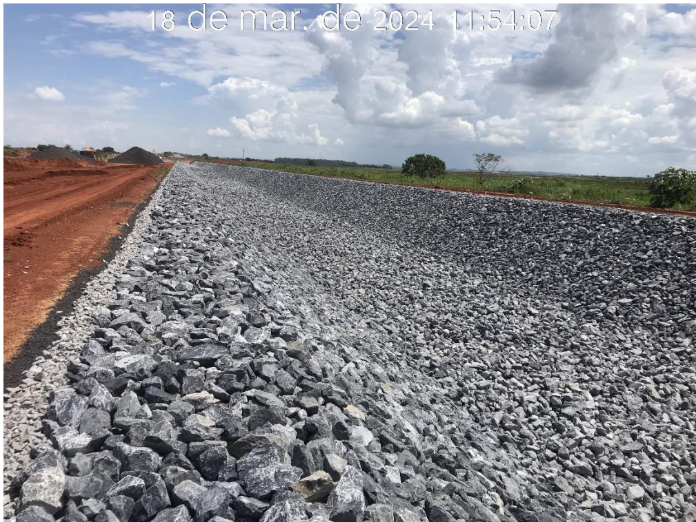
Figura 7.12 – Vista para jusante do canal periférico, após o término da aplicação da camada de proteção (18/03/2024).
