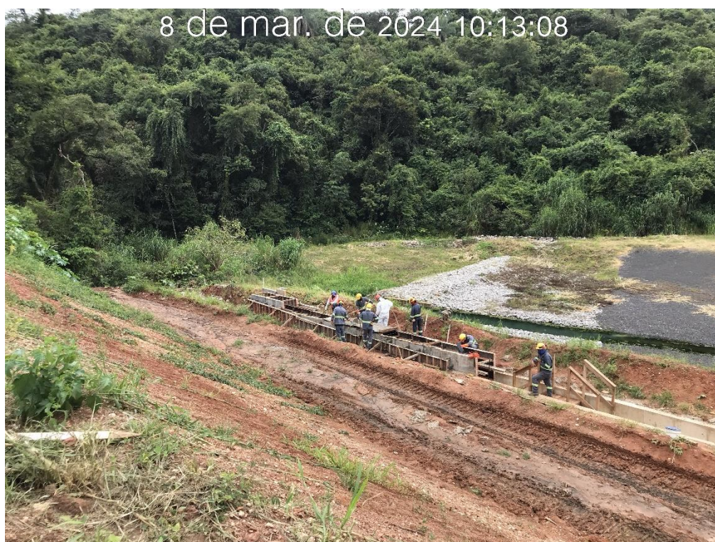
Figura 7.36 – Concretagem do módulo 31 do canal de drenagem superficial da ombreira esquerda, com vista para jusante (08/03/2024).
