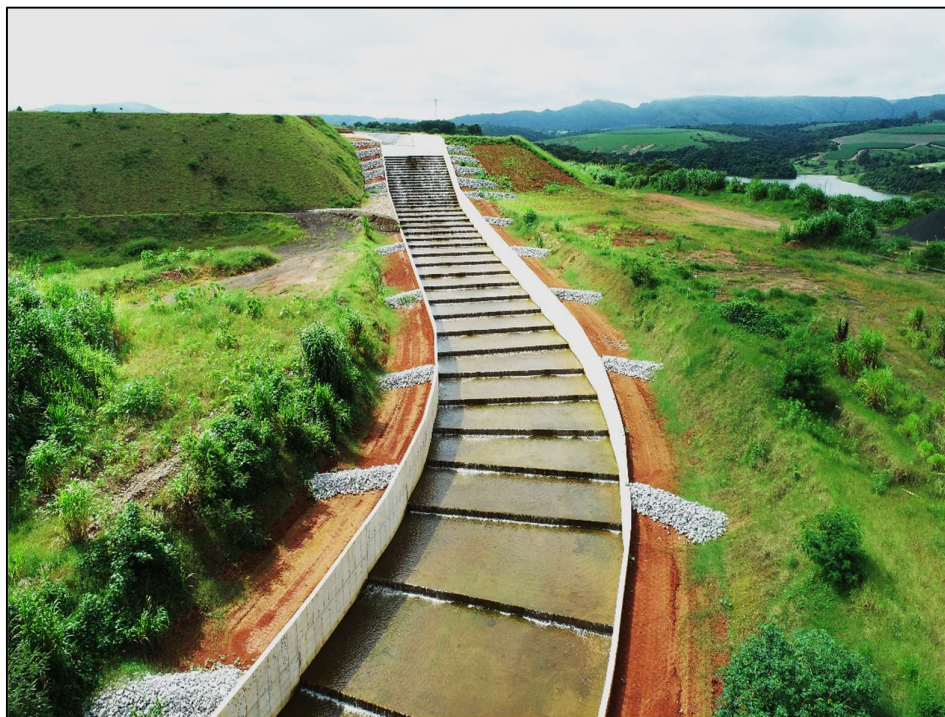
Figura 8.9 – Detalhe do canal rápido, na região do maciço da Barragem B5 (09/01/2025).
