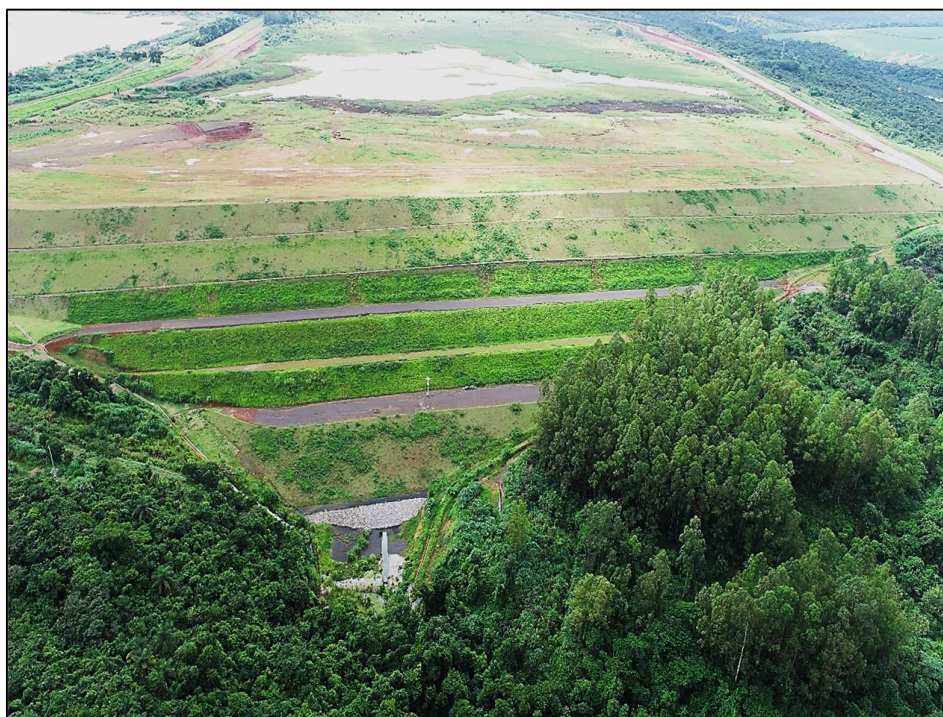
Figura 8.20 – Vista panorâmica da Barragem B5 (09/01/2025).
