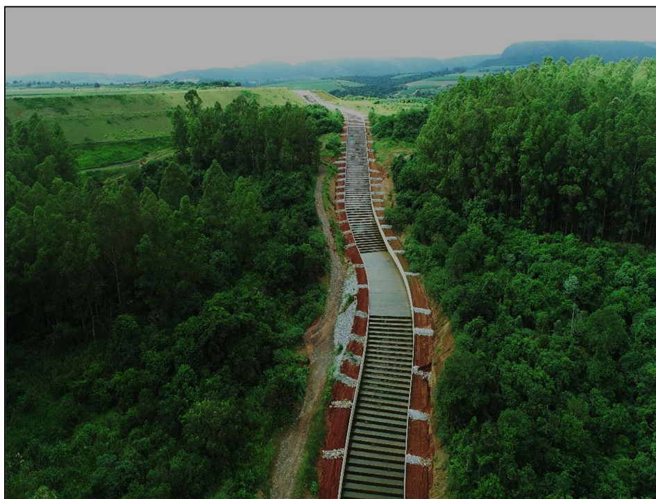
Figura 8.11 – Vista para montante do canal rápido (09/01/2025).
