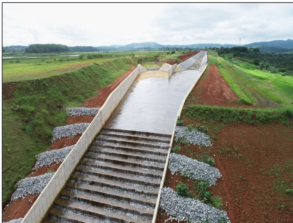
Figura 8.7 – Detalhe do canal do reservatório, na região de transição com o canal rápido (09/01/2025).
