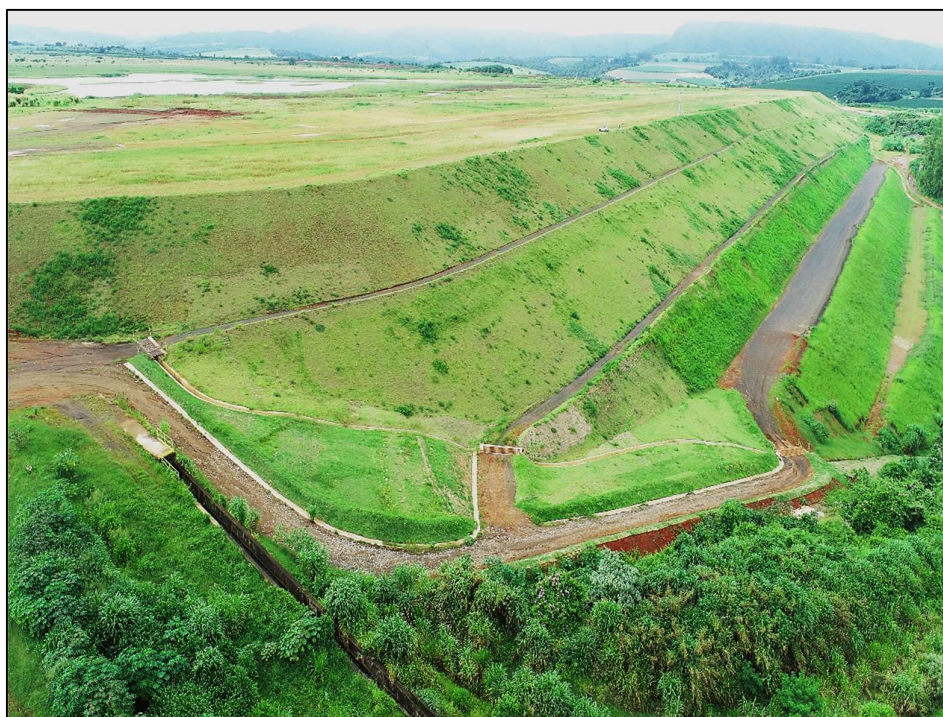
Figura 8.19 – Vista para jusante da Barragem B5, com detalhe do plantio de grama executado na ombreira direita (09/01/2025).
