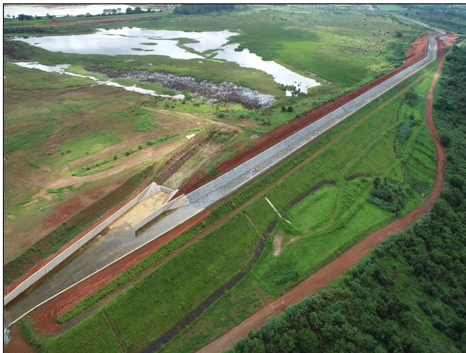
Figura 8.5 – Vista panorâmica do canal periférico (09/01/2025).
