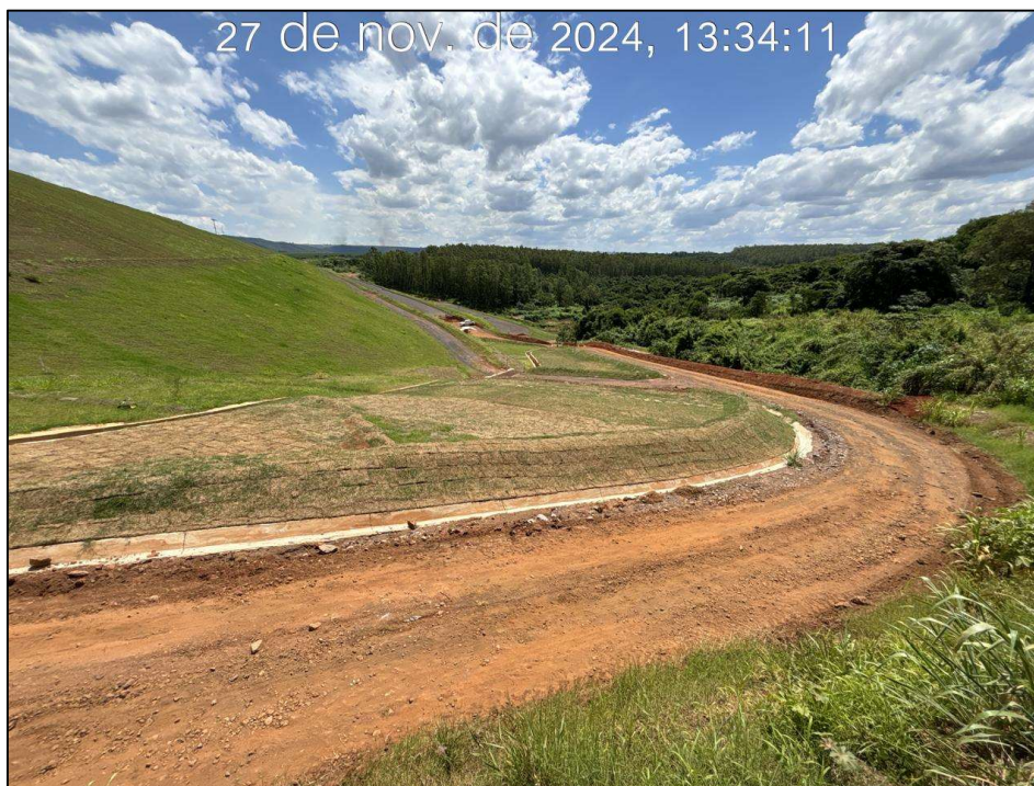
Figura 8.18 – Vista para jusante da barragem B5, com detalhe do plantio de grama em placa, aplicada na ombreira direita (27/11/2024).
