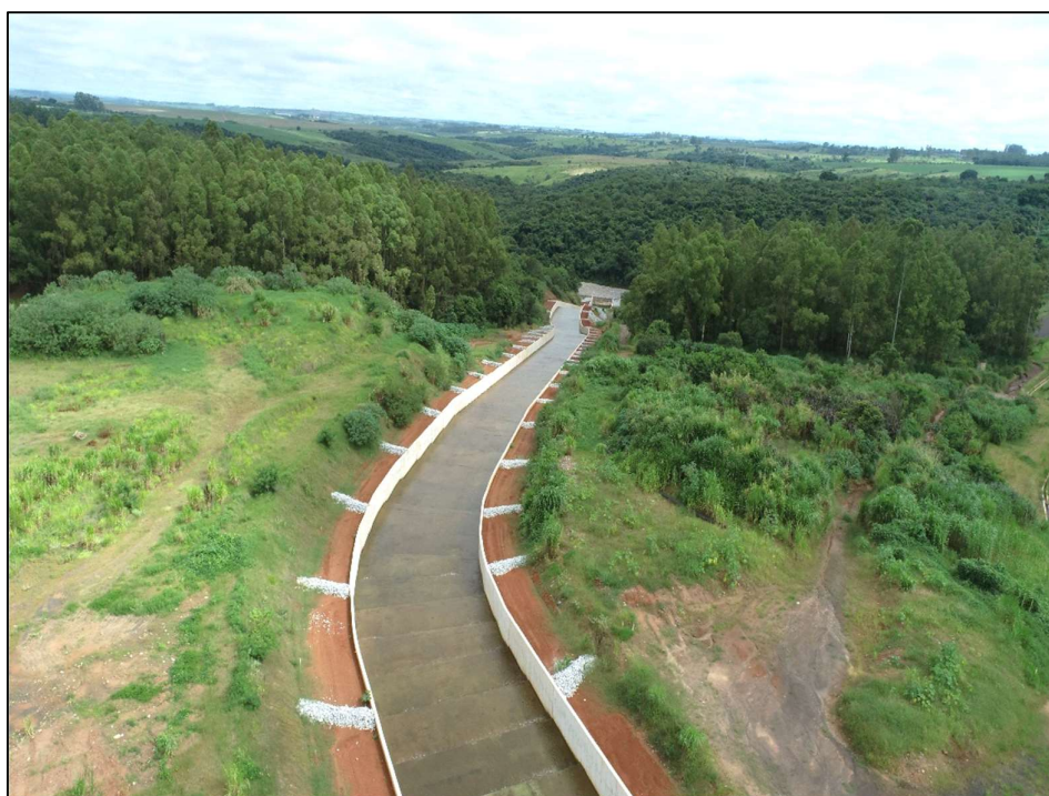
Figura 8.10 – Vista para jusante do canal rápido (09/01/2025).
