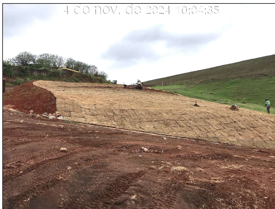
Figura 8.13 – Plantio de grama em placa nas áreas adjacentes ao canal de drenagem superficial da ombreira direita, com vista para montante (04/11/2024).
