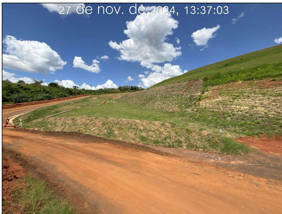
Figura 8.17 – Vista para montante da barragem B5, com detalhe do plantio de grama em placa, aplicada na ombreira direita (27/11/2024).
