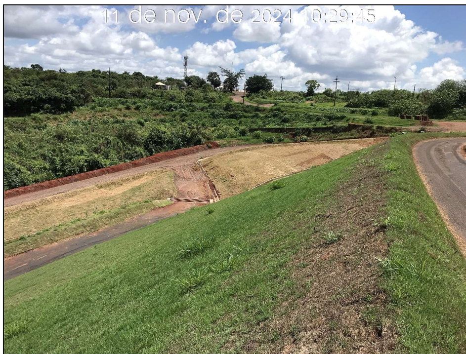
Figura 8.16 – Vista do plantio de grama em placa, entre as elevações 930,00m, 940,00m e 952,50m da ombreira direita (11/11/2024).
