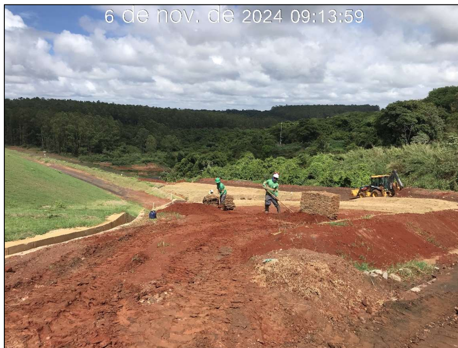
Figura 8.14 – Plantio de grama em placa nas áreas adjacentes ao canal de drenagem superficial da ombreira direita, com vista para jusante (06/11/2024).
