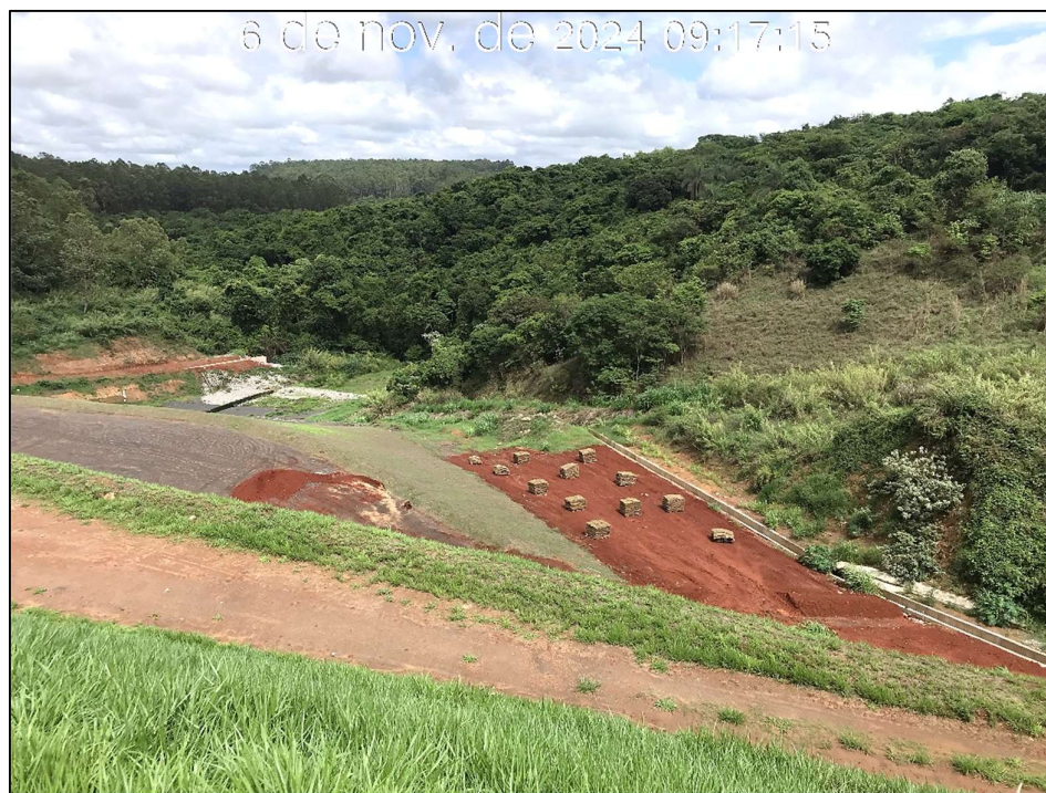
Figura 8.15 – Vista para jusante da barragem B5, com detalhe do início do plantio de grama em placa, na região do reforço de fundação, na elevação 913,00m (06/11/2024).
