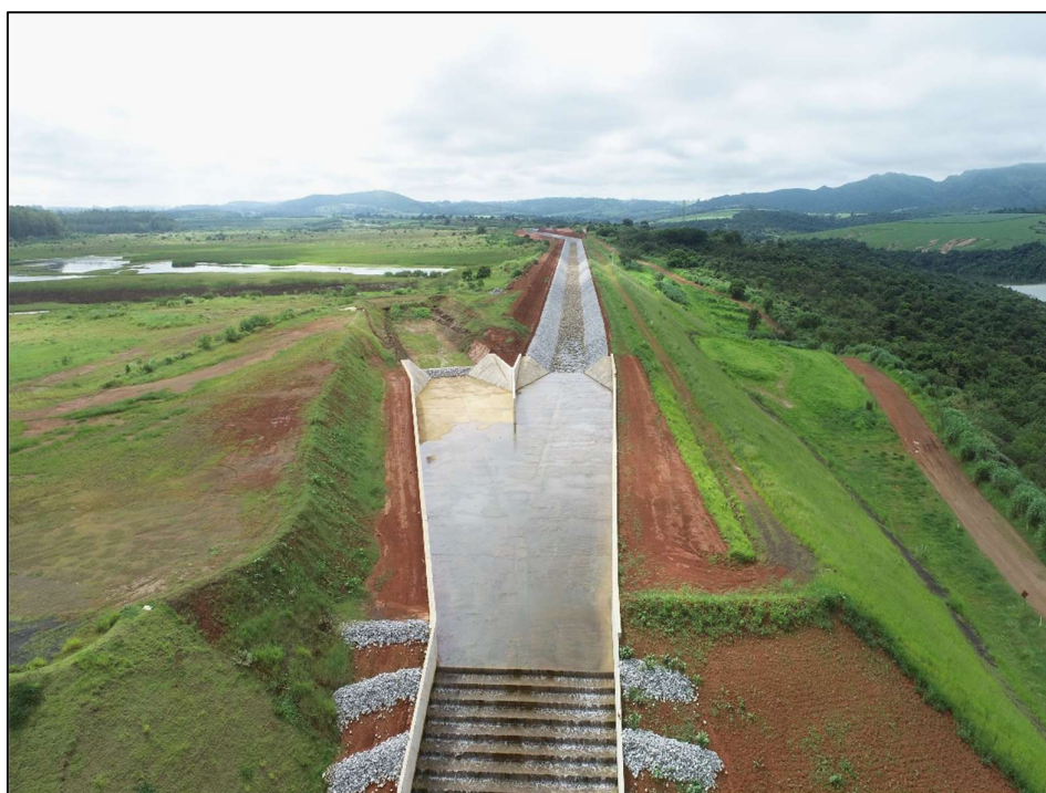
Figura 8.6 – Região de transição entre o canal periférico e o canal rápido (09/01/2025).
