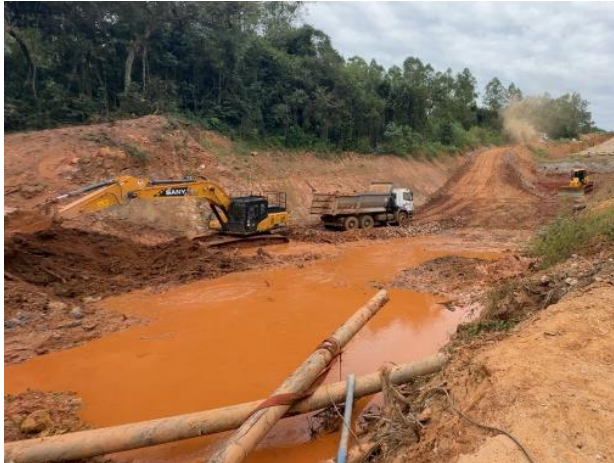
Figura 29 – Escavação, carga e transporte para construção da bacia de dissipação.
