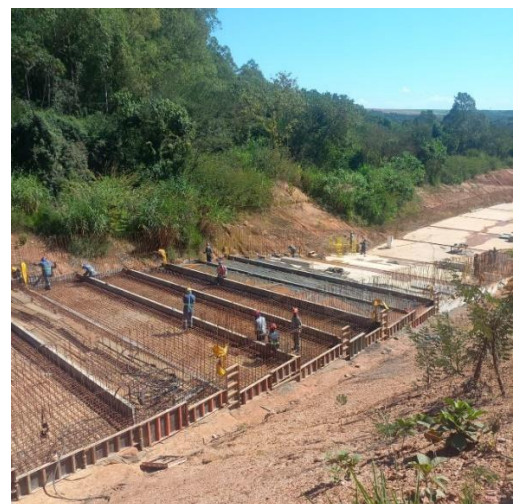
Figura 16 – Aplicação de concreto em piso – módulo 28 e cura úmida de concreto aplicado.
