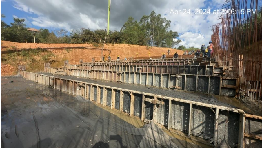
Figura 20 – Aplicação de concreto em piso – módulo 27.
