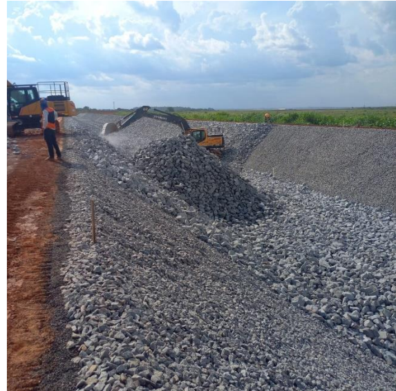
Figura 36 – Carregamento de enrocamento e lançamento nas paredes do canal periférico – estaca 75.
