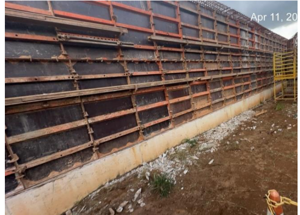
Figura 17 – Armação e formas nas paredes da transição do canal rápido.
