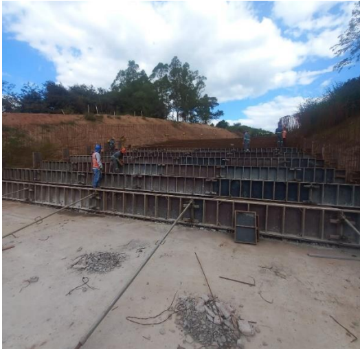
Figura 14 – Montagem de formas para concretagem – módulo 26.
