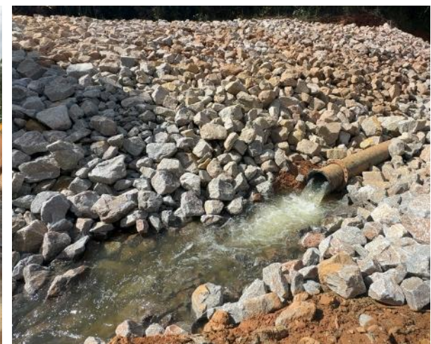
Figura 31 – Aplicação de enrocamento e desvio provisório do fluxo de água do córrego Capivara.
