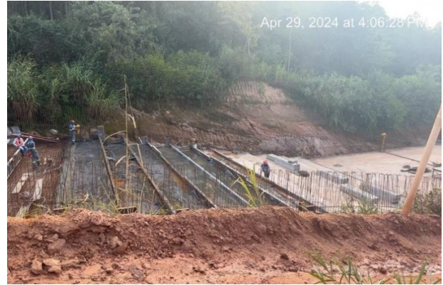
Figura 23 – Armação de paredes no canal rápido e cura úmida do concreto – módulos 25 a 30.
