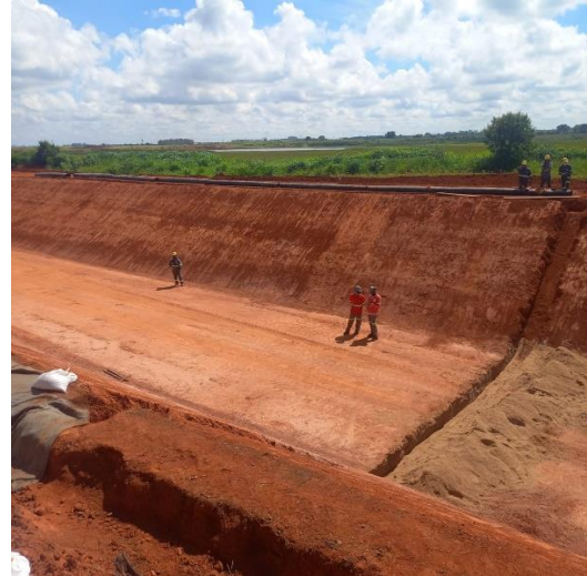
Figura 57 – Corte de geomembrana para aplicação e preparo para início do lançamento.
