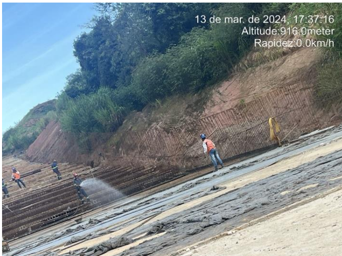
Figura 12 – Cura úmida de concreto aplicado – piso.
