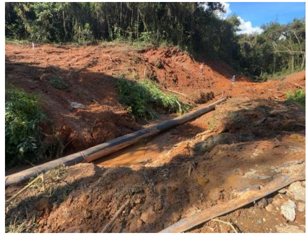
Figura 27 – Preparo para desvio provisório do fluxo de água do córrego Capivara.
