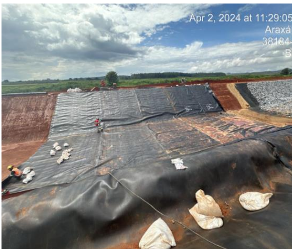
Figura 59 – Continuação da aplicação do revestimento em geomembrana – Estaca 136.
