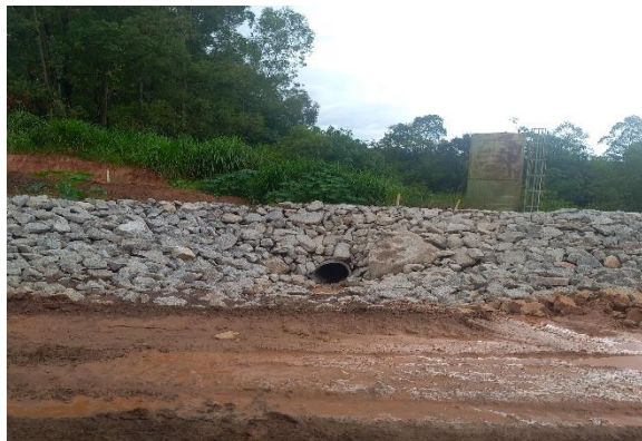
Figura 87 – Construção de passagens molhadas direcionando fluxo para talvegue antigo extravasor na ombreira esquerda e sump existente da ombreira direita.
