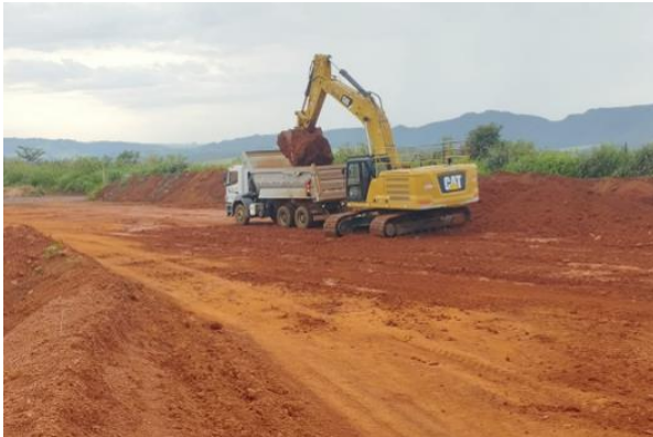
Figura 47 – Escavação, carga e transporte de material e compactação de aterro a 95% PN.
