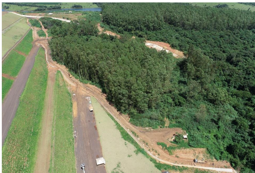
Figura 84 – Vista aérea canal de drenagem – ombreira esquerda.
