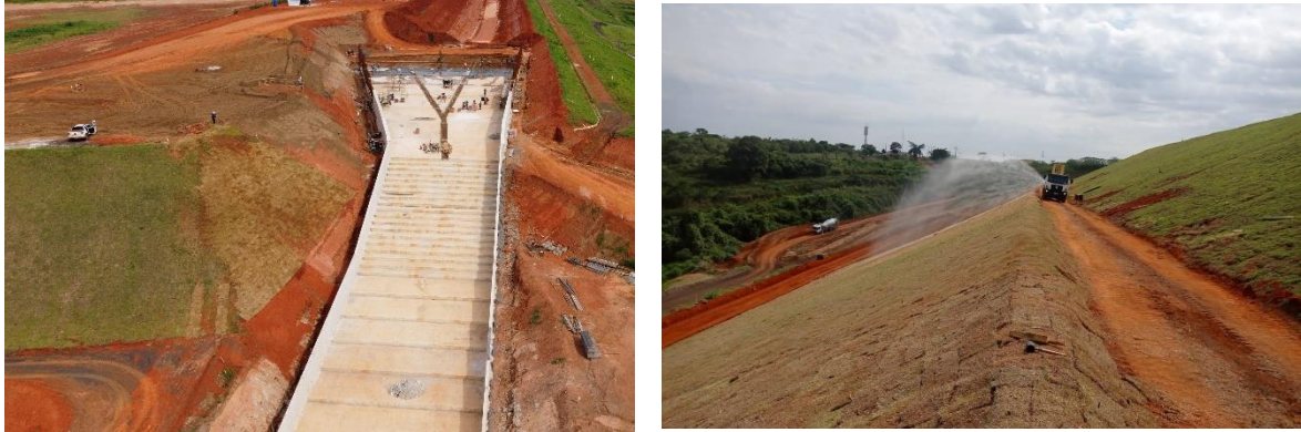
Figura 89 – Plantio de grama próximo ao modulo 65 e em taludes expostos.
