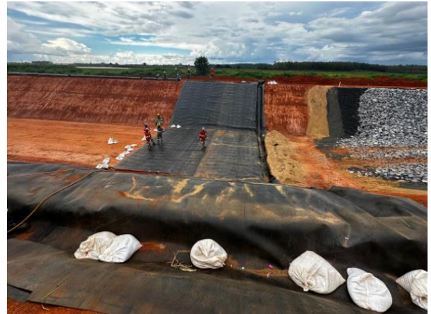
Figura 58 – Início da aplicação do revestimento em geomembrana – Estaca 135.
