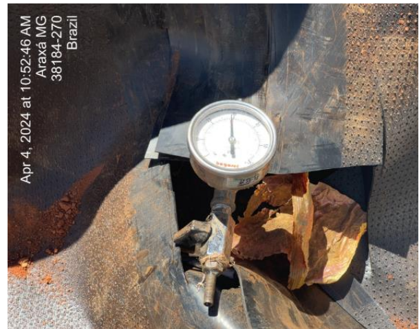
Figura 61 – Execução de reparo em solda por extrusão e execução de ensaio não destrutivo em solda por termofusão.
