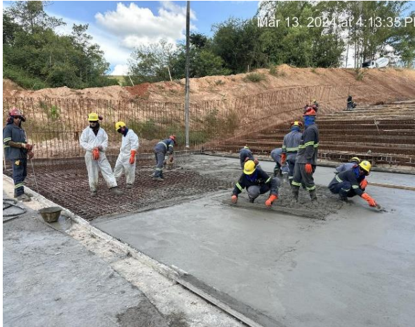
Figura 11 – Aplicação de concreto em piso – módulo 25.
