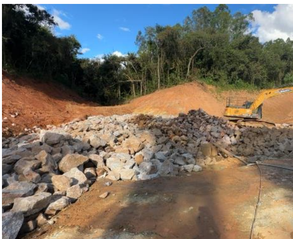
Figura 31 – Aplicação de enrocamento e desvio provisório do fluxo de água do córrego Capivara.
