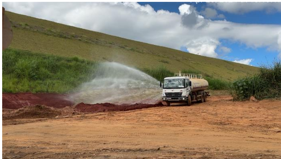
Figura 82 – Umidificação de grama após o plantio.
