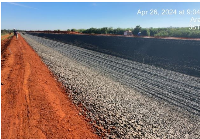
Figura 68 – Vista geral de trecho com transição (areia, brita 0 e brita 3) aplicada e execução de reaterro compactado de vala de ancoragem.
