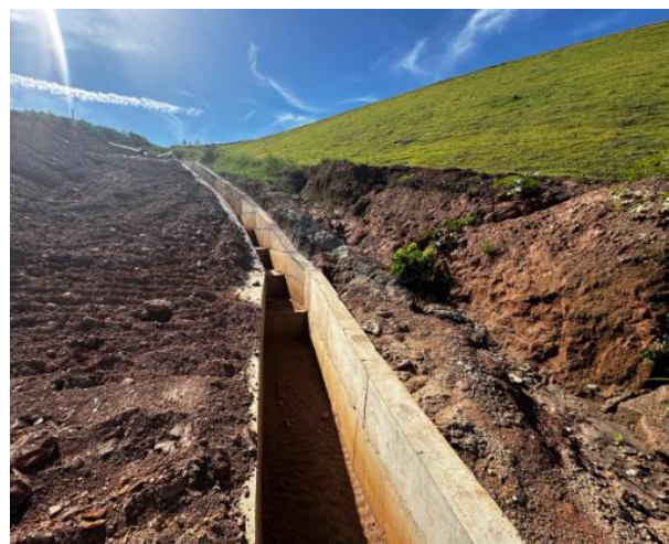
Figura 76 – Desforma – canal de drenagem ombreira direita.
