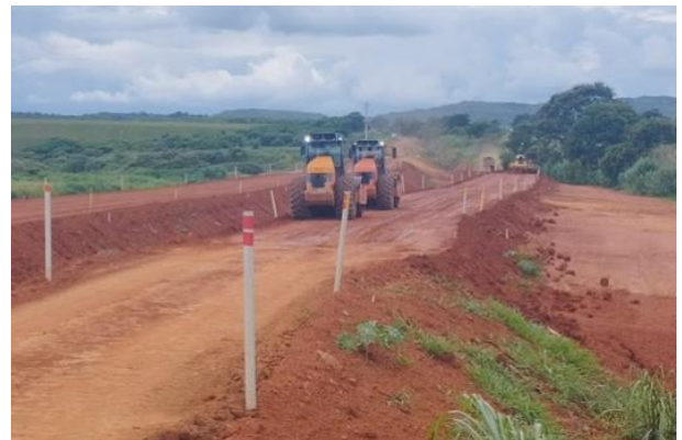
Figura 48 – Escavação, carga e transporte de material e compactação de aterro a 95% PN.
