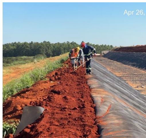
Figura 68 – Vista geral de trecho com transição (areia, brita 0 e brita 3) aplicada e execução de reaterro compactado de vala de ancoragem.
