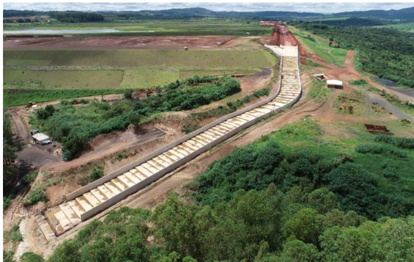
Figura 24 – Visão geral do canal rápido.
