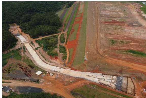
Figura 88 – Escavação, concretagem da laje de piso do canal rápido e proteção com enrocamento no deságue do canal provisório.
