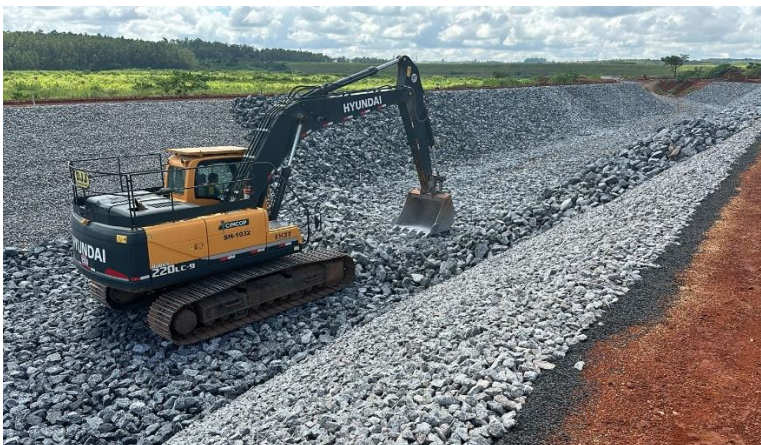
Figura 38 – Lançamento e conformação de enrocamento em piso e paredes do canal periférico – estacas 62 a 67.
