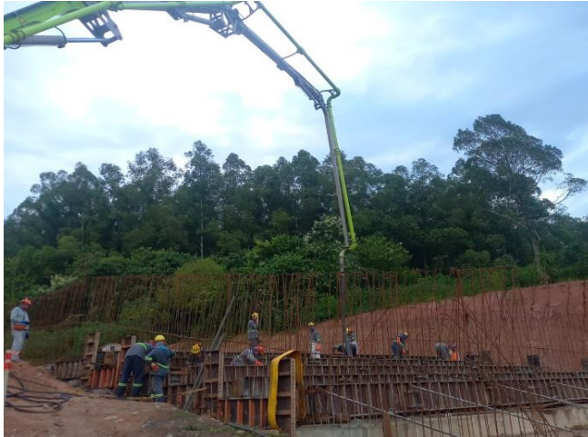
Figura 5 – Concretagem de piso – Módulo 19.
