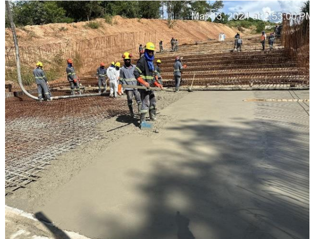
Figura 11 – Aplicação de concreto em piso – módulo 25.
