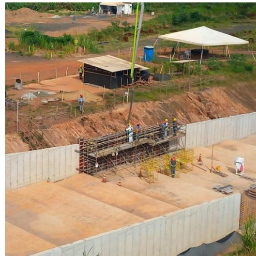
Figura 9 – Concretagem de paredes – Módulos 54, 56 e 60.
