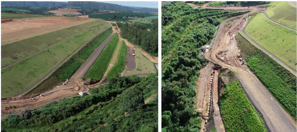
Figura 69 – Vista geral da readequação do maciço principal da B5 e vista geral da ombreira direita.
