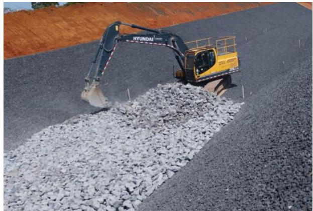
Figura 37 – Lançamento e conformação de enrocamento nas paredes e piso do canal periférico – estaca 75.
