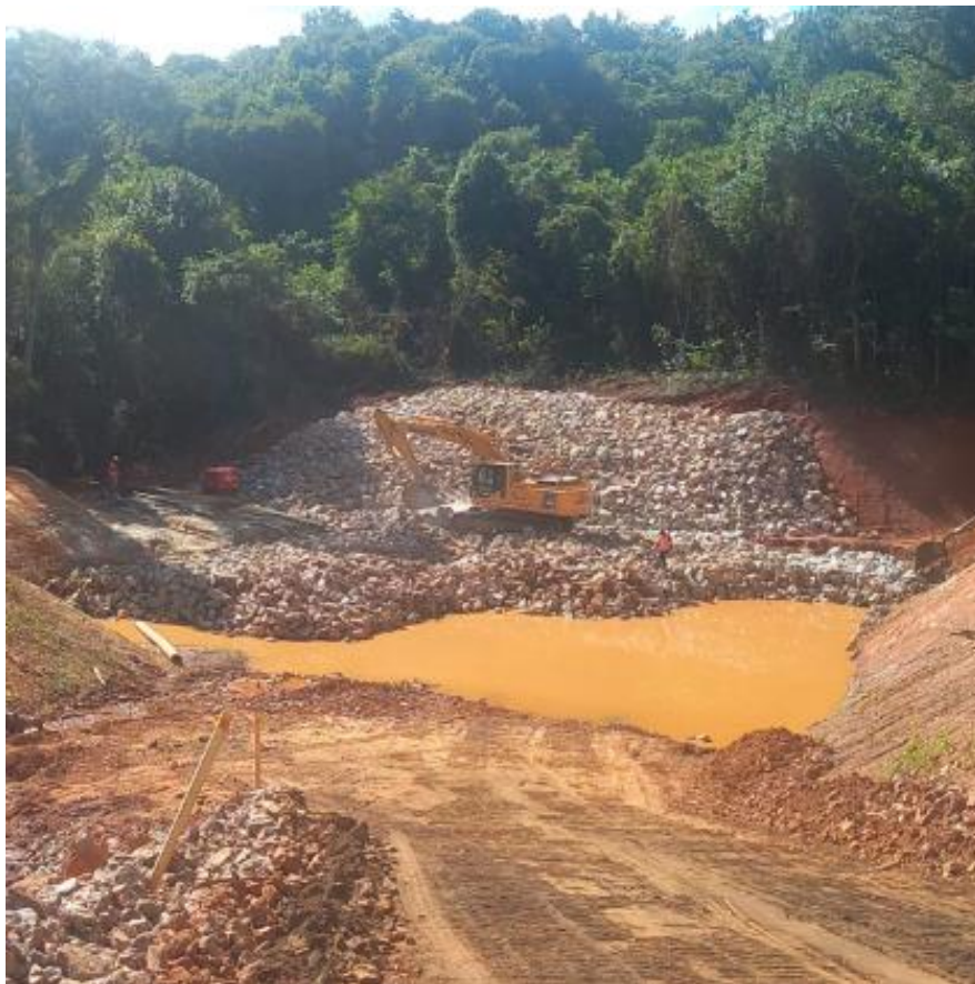
Figura 33 – Aplicação de enrocamento na bacia de dissipação.
