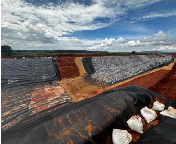
Figura 60 – Ancoragem da geomembrana e avanço da aplicação de geomembrana – Estaca 139.
