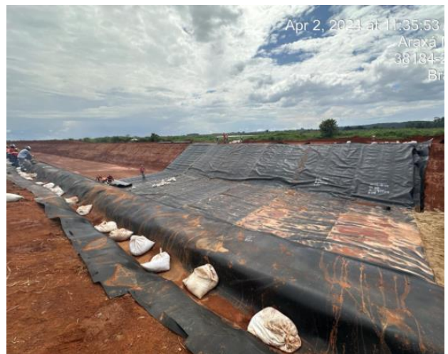
Figura 59 – Continuação da aplicação do revestimento em geomembrana – Estaca 136.
