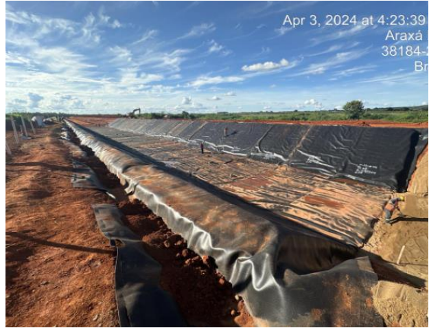
Figura 60 – Ancoragem da geomembrana e avanço da aplicação de geomembrana – Estaca 139.
