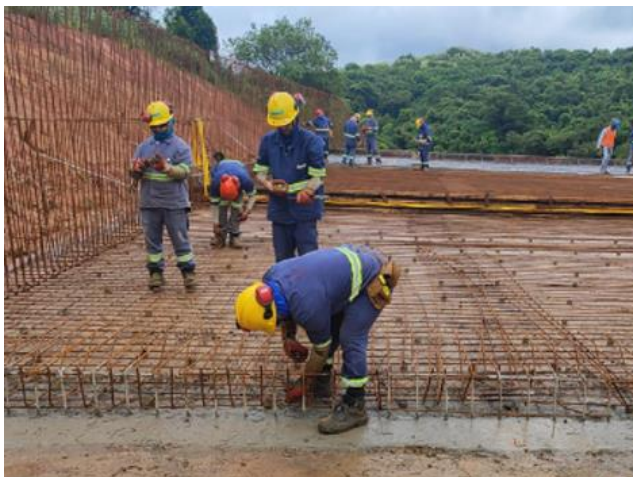
Figura 10 – Montagem de armação e aplicação de concreto em piso – módulo 22.
