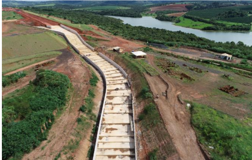
Figura 8 – Vista geral do avanço do canal rápido.
