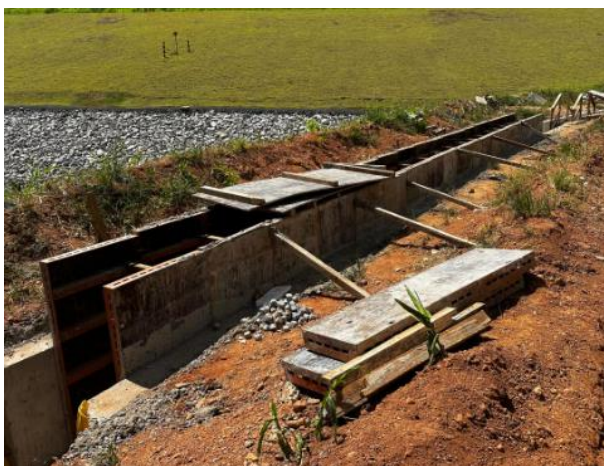
Figura 73 – Montagem de formas para concretagem – canais de drenagem ombreira esquerda e ombreira direita.
