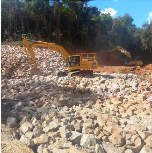
Figura 34 – Aplicação de enrocamento na bacia de dissipação.
