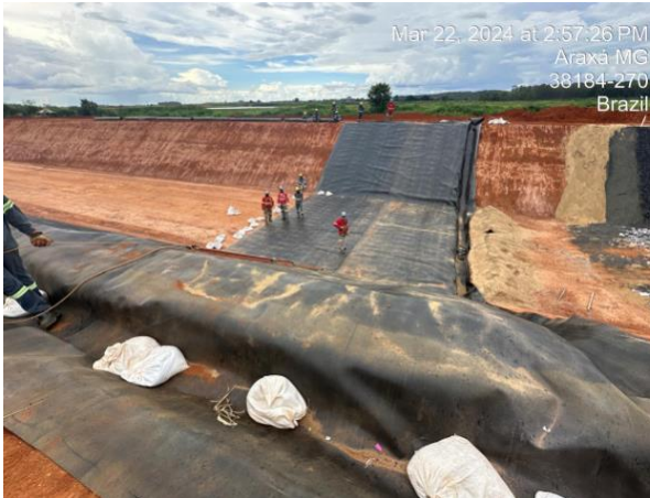
Figura 58 – Início da aplicação do revestimento em geomembrana – Estaca 135.
