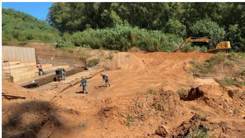
Figura 22 – Escavação e acerte manual de degrau – módulos 35 e 36.
