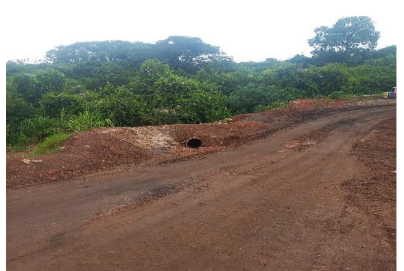
Figura 87 – Construção de passagens molhadas direcionando fluxo para talvegue antigo extravasor na ombreira esquerda e sump existente da ombreira direita.
