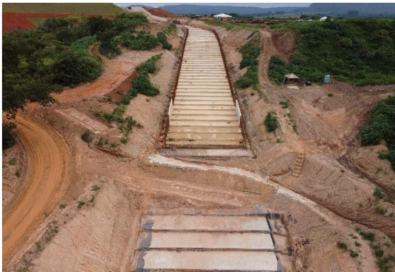
Figura 86 – Leira de proteção e abertura lateral para escoamento do fluxo.
