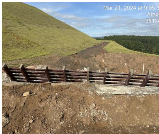
Figura 78 – Recebimento e concretagem de travessia e montagem de formas para instalação.
