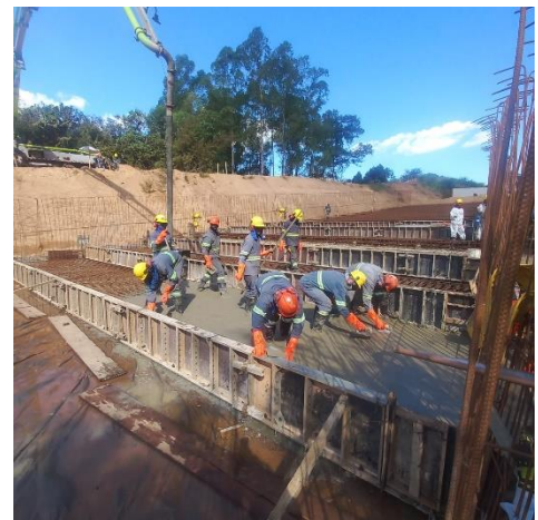
Figura 15 – Aplicação de concreto em piso – módulo 26.
