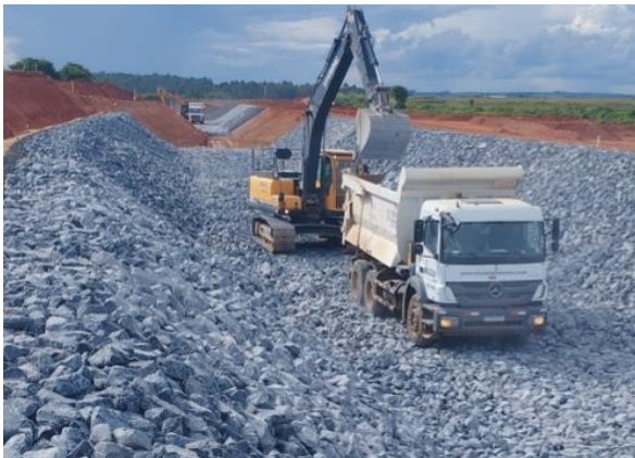
Figura 37 – Lançamento e conformação de enrocamento nas paredes e piso do canal periférico – estaca 75.
