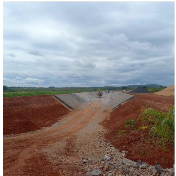
Figura 35 – Aplicação de enrocamento nas paredes do canal periférico – estacas 80 a 100.
