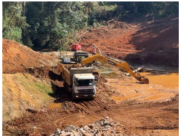
Figura 30 – Acerte de talude e escavação, carga e transporte para execução da bacia de dissipação.
