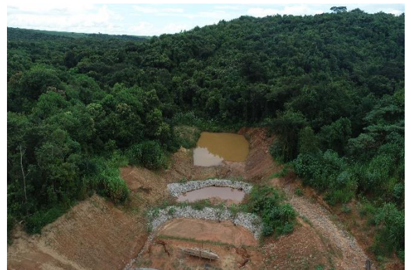
Figura 88 – Escavação, concretagem da laje de piso do canal rápido e proteção com enrocamento no deságue do canal provisório.
