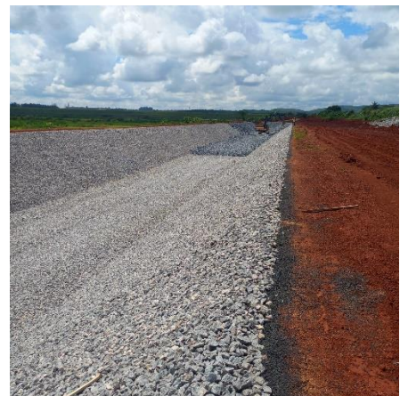
Figura 38 – Lançamento e conformação de enrocamento em piso e paredes do canal periférico – estacas 62 a 67.
