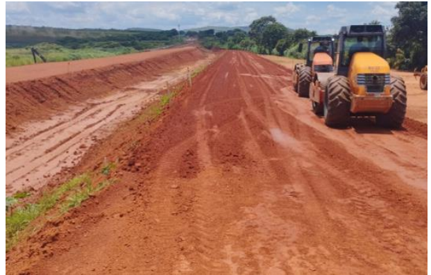
Figura 47 – Escavação, carga e transporte de material e compactação de aterro a 95% PN.
