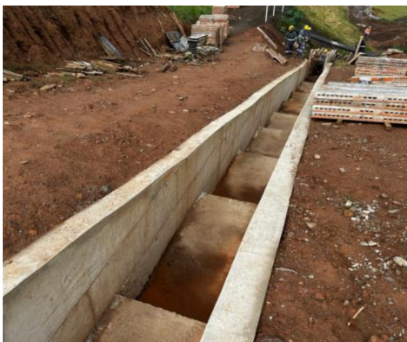
Figura 76 – Desforma – canal de drenagem ombreira direita.
