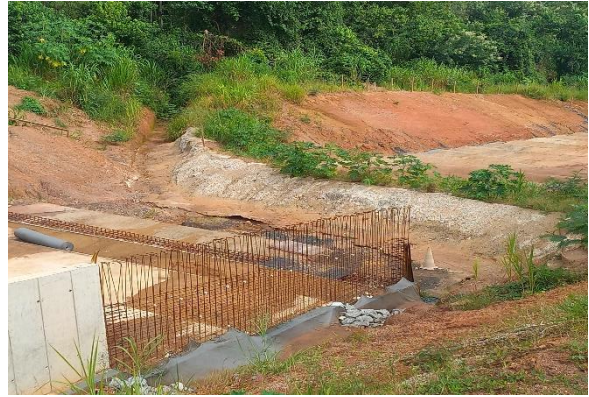
Figura 86 – Leira de proteção e abertura lateral para escoamento do fluxo.
