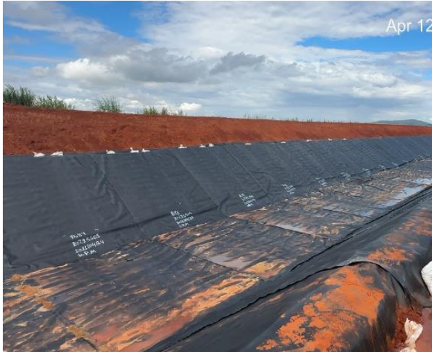
Figura 65 – Continuidade da aplicação do revestimento em geomembrana.
