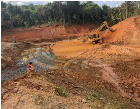
Figura 30 – Acerte de talude e escavação, carga e transporte para execução da bacia de dissipação.
