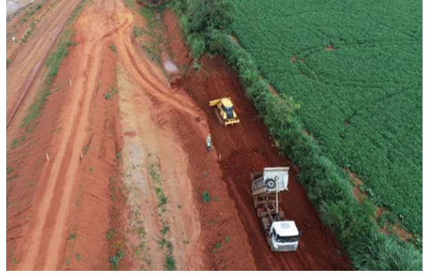
Figura 49 – Compactação de aterro a 95% PN e carga, transporte e espalhamento de material para aterro.
