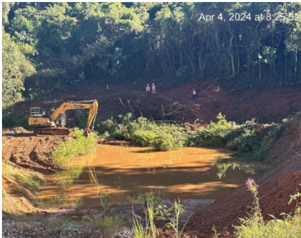
Figura 26 – Início da supressão vegetal e limpeza para implantação da bacia de dissipação.
