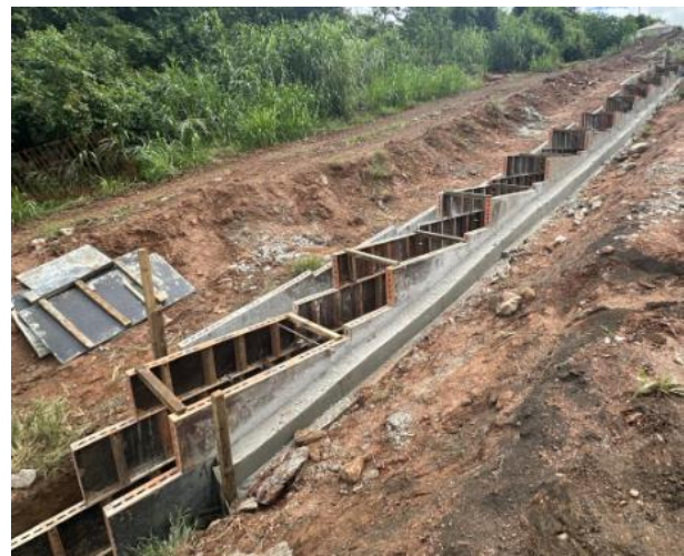
Figura 75 – Concretagem de paredes – canal de drenagem ombreira direita.
