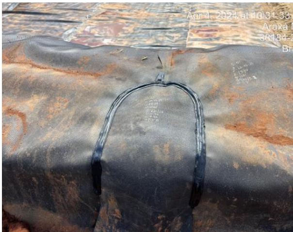
Figura 61 – Execução de reparo em solda por extrusão e execução de ensaio não destrutivo em solda por termofusão.
