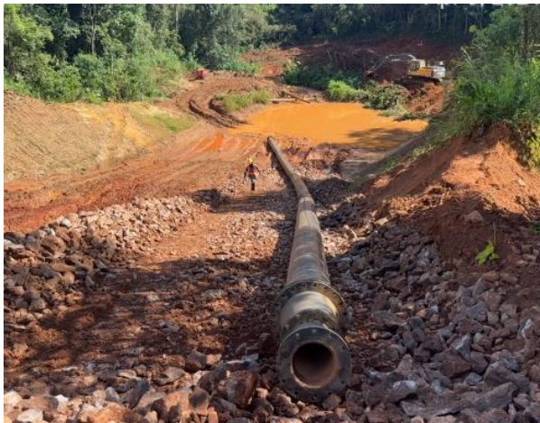
Figura 27 – Preparo para desvio provisório do fluxo de água do córrego Capivara.
