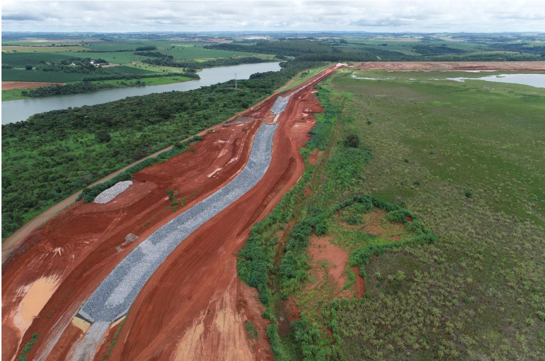
Figura 41 – Vista geral do canal periférico com avanço da transição (areia, brita 0 e brita 3) e enrocamento.
