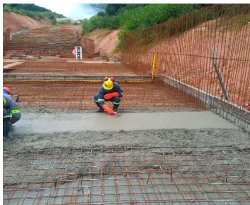
Figura 7 – Concretagem de piso – módulo 21.
