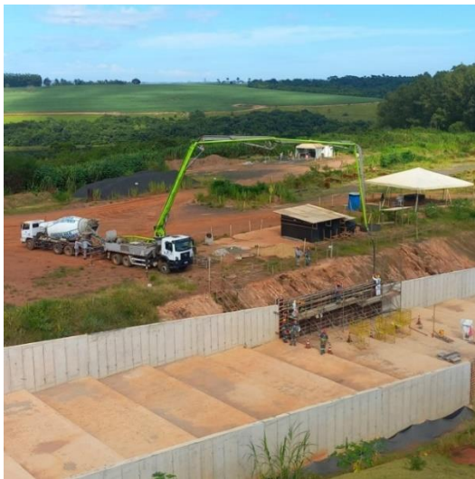
Figura 9 – Concretagem de paredes – Módulos 54, 56 e 60.
