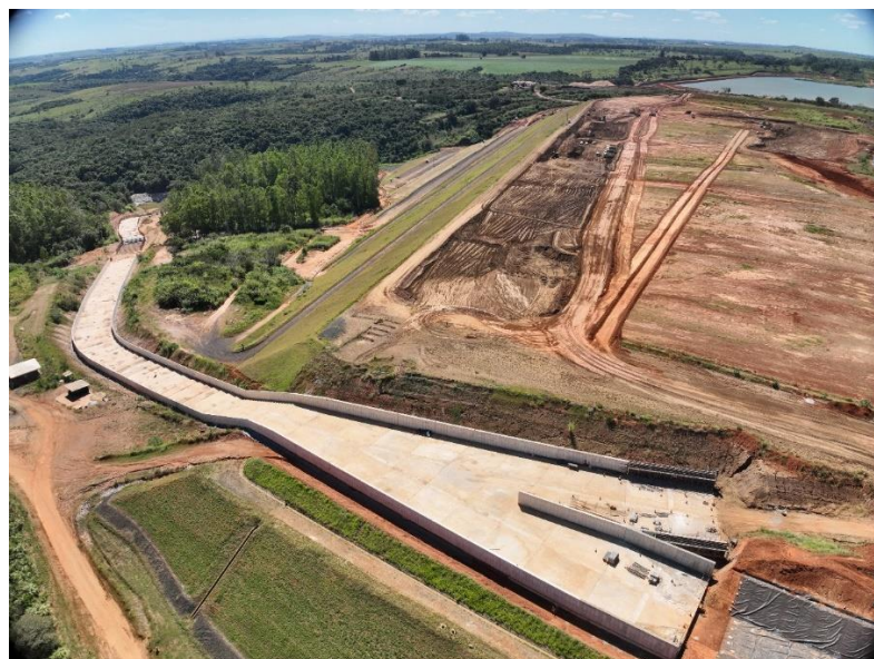
Figura 25 – Visão geral do canal rápido.
