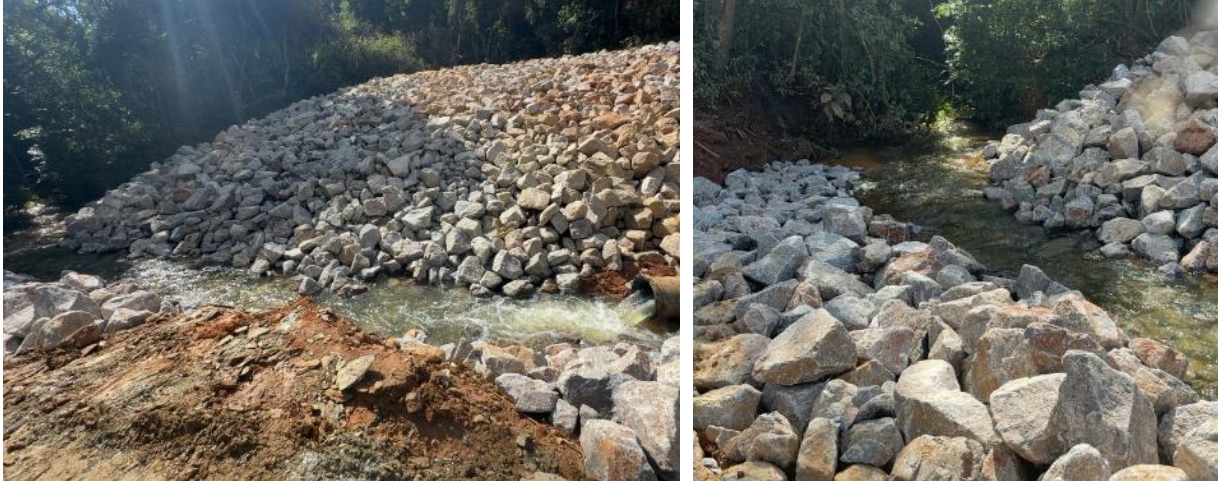
Figura 32 – Desvio provisório do fluxo de água do córrego Capivara.
