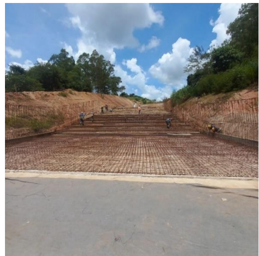
Figura 13 – Armação de piso e paredes – módulos 25 a 31.
