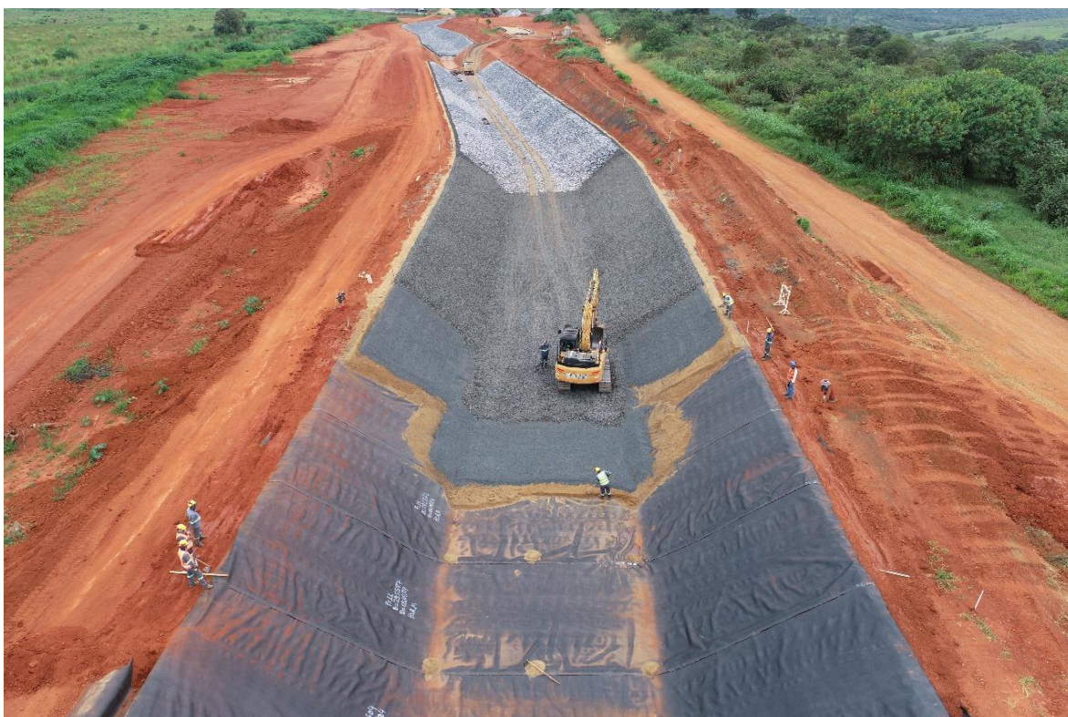
Figura 64 – Avanço da aplicação de transição (areia, brita 0 e brita 3) sobre o revestimento em geomembrana.
