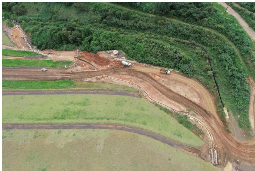
Figura 83 – Vista aérea canal de drenagem – ombreira direita.
