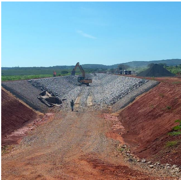
Figura 35 – Aplicação de enrocamento nas paredes do canal periférico – estacas 80 a 100.
