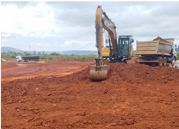
Figura 50 – Escavação, carga e transporte de material e aplicação, espalhamento e tratamento.
