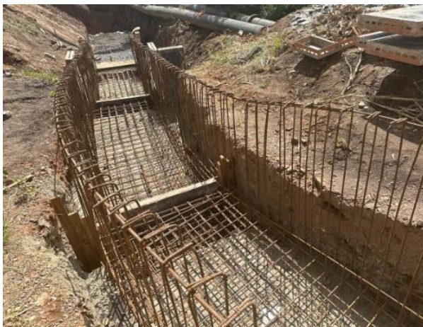
Figura 71 – Aplicação de armação – canais de drenagem ombreira direita e ombreira esquerda.
