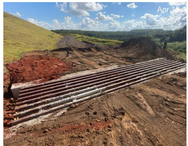
Figura 79 – Posicionamento da travessia para concretagem e instalação finalizada – ombreira direita.
