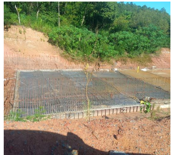
Figura 12 – Cura úmida de concreto aplicado – piso.
