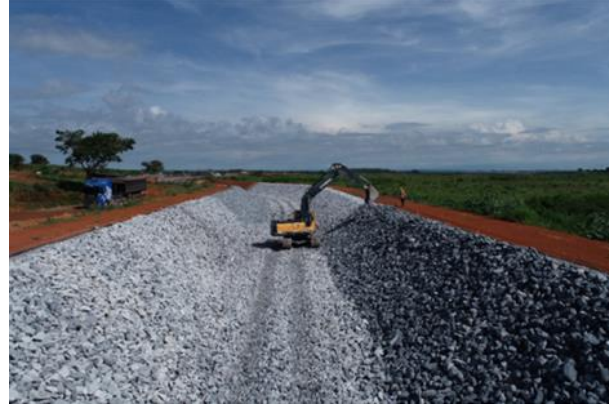
Figura 43 – Aplicação e conformação de enrocamento em paredes do canal periférico.
