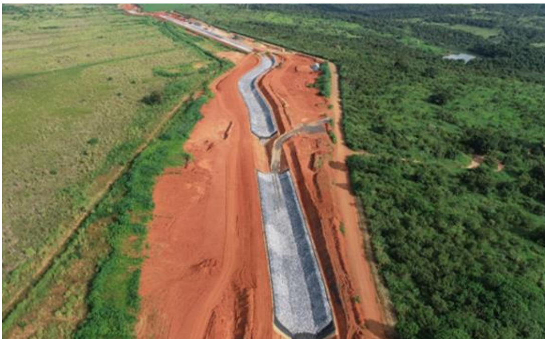
Figura 42 – Avanço da transição (areia, brita 0 e brita 3) e enrocamento no canal periférico.
