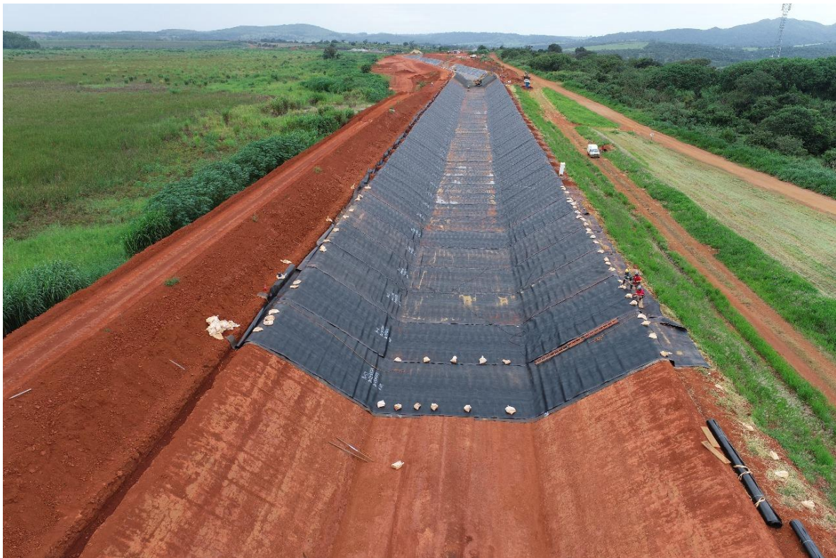
Figura 66 – Vista geral da aplicação de revestimento em geomembrana.
