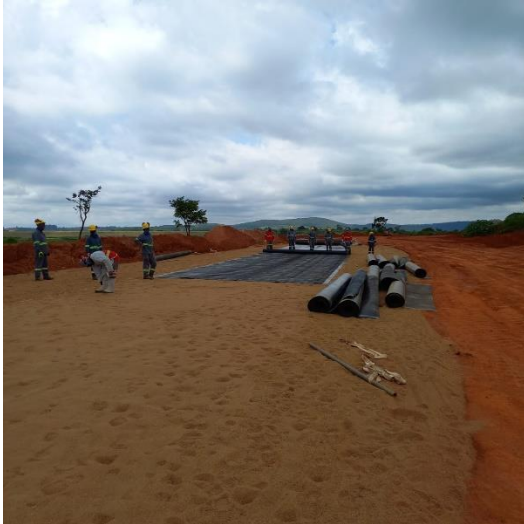
Figura 57 – Corte de geomembrana para aplicação e preparo para início do lançamento.
