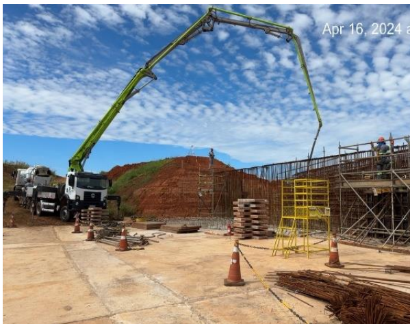
Figura 18 – Aplicação de concreto nas paredes da transição do canal rápido.
