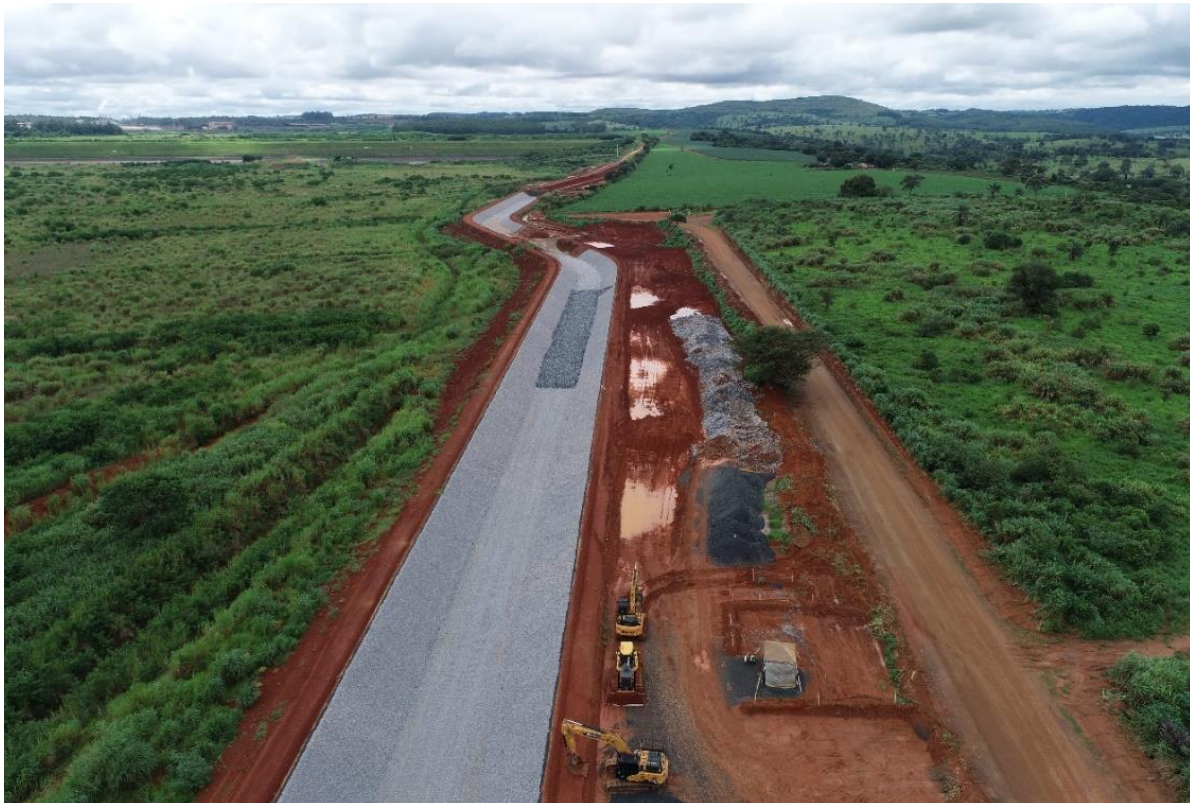
Figura 40 – Vista geral do canal periférico com avanço da transição (areia, brita 0 e brita 3) e enrocamento.
