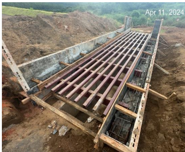
Figura 79 – Posicionamento da travessia para concretagem e instalação finalizada – ombreira direita.
