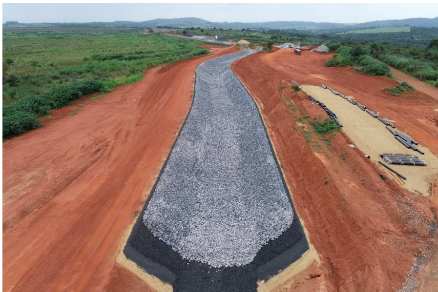
Figura 45 – Vista geral canal periférico com aplicação das transições (areia, brita 0 e brita 3) e enrocamento.
