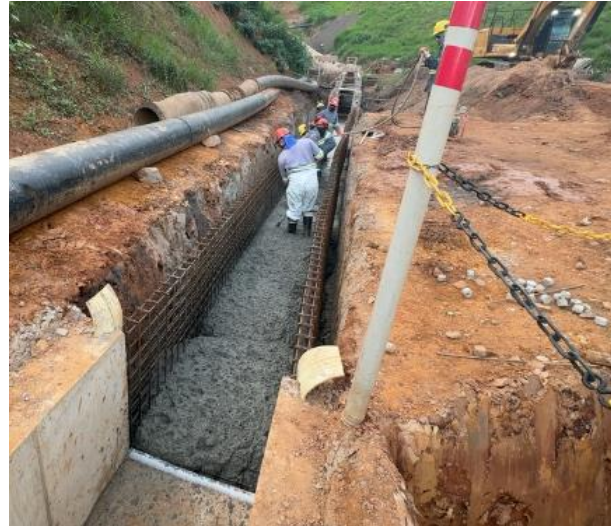
Figura 74 – Preparo para concretagem e concretagem de piso – canal de drenagem ombreira direita.
