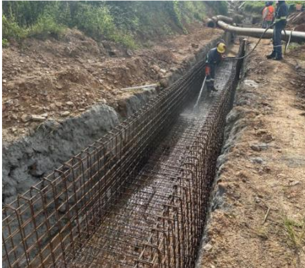
Figura 74 – Preparo para concretagem e concretagem de piso – canal de drenagem ombreira direita.
