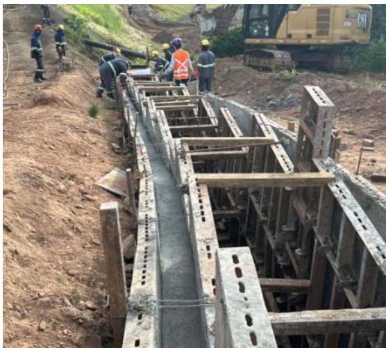
Figura 75 – Concretagem de paredes – canal de drenagem ombreira direita.
