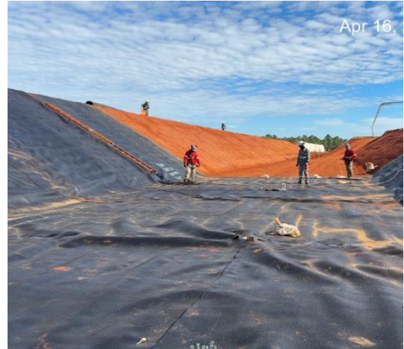
Figura 65 – Continuidade da aplicação do revestimento em geomembrana.
