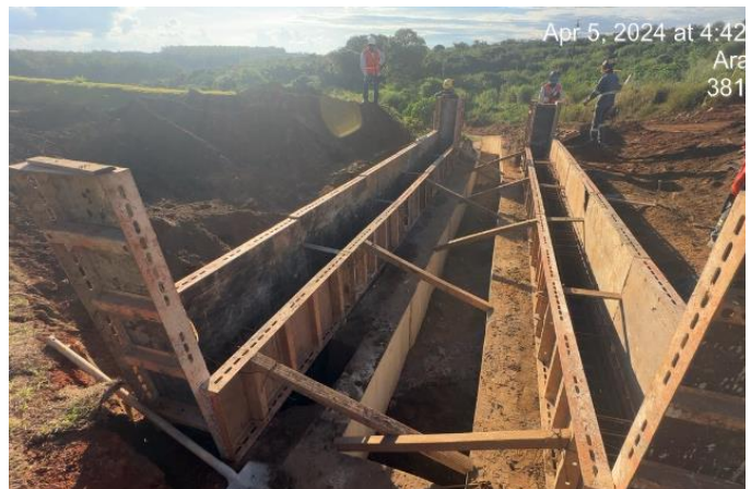
Figura 78 – Recebimento e concretagem de travessia e montagem de formas para instalação.
