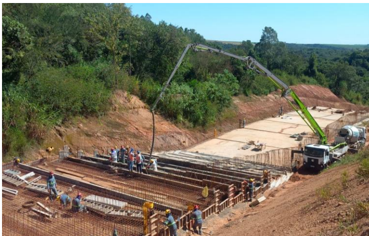
Figura 15 – Aplicação de concreto em piso – módulo 26.
