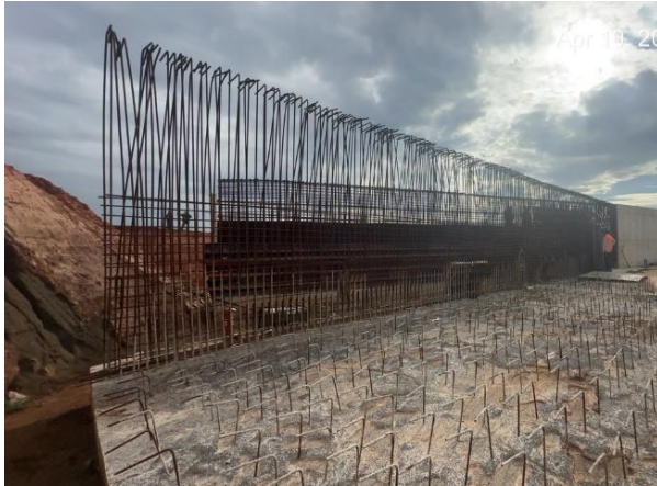
Figura 17 – Armação e formas nas paredes da transição do canal rápido.
