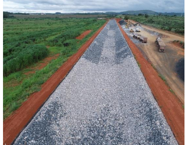
Figura 46 – Aplicação de enrocamento nas paredes do canal e vista geral de enrocamento aplicado.
