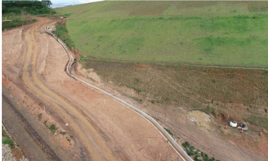
Figura 77 – Vista aérea canal de drenagem – ombreira direita.
