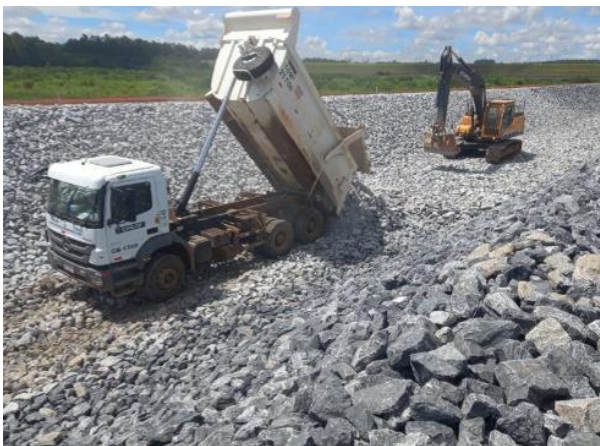
Figura 44 – Aplicação e conformação de enrocamento no piso e paredes do canal periférico e vista geral da aplicação das transições e enrocamento.
