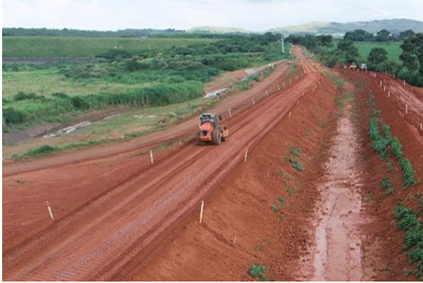
Figura 49 – Compactação de aterro a 95% PN e carga, transporte e espalhamento de material para aterro.
