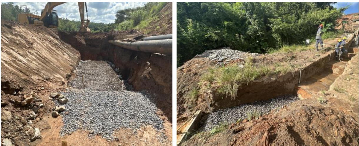
Figura 70 – Escavação e aplicação de lastro de brita nos canais de drenagem das ombreiras.
