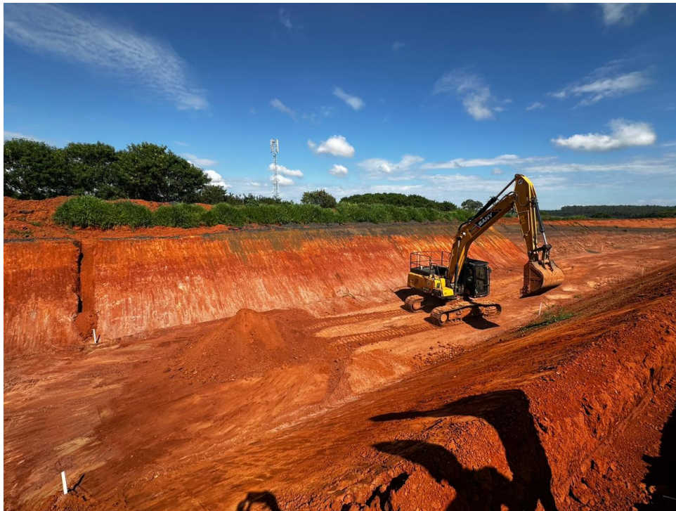
Figura 52 – Regularização de fundo e paredes para recebimento da geomembrana – estaca 135.
