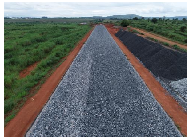
Figura 44 – Aplicação e conformação de enrocamento no piso e paredes do canal periférico e vista geral da aplicação das transições e enrocamento.
