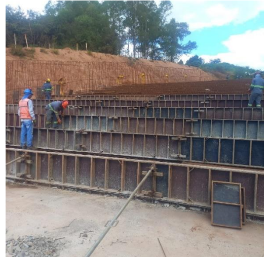
Figura 14 – Montagem de formas para concretagem – módulo 26.
