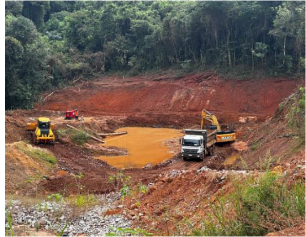
Figura 29 – Escavação, carga e transporte para construção da bacia de dissipação.
