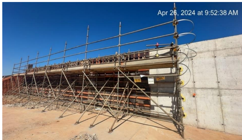
Figura 21 – Montagem de formas para concretagem de parede na transição do canal rápido.
