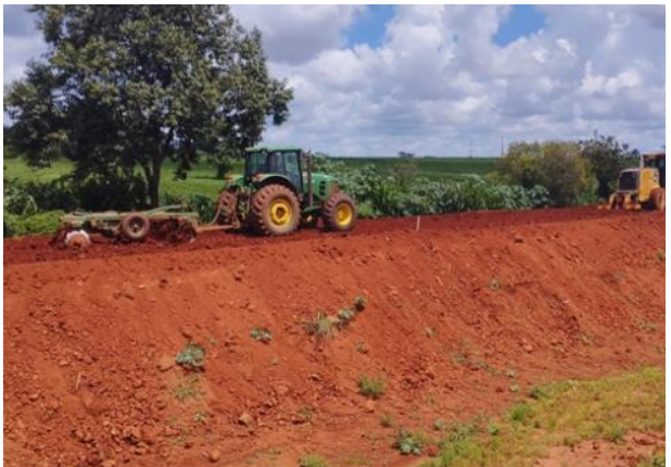
Figura 50 – Escavação, carga e transporte de material e aplicação, espalhamento e tratamento.
