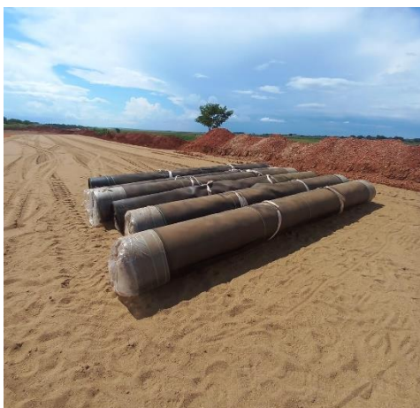
Figura 56 – Recebimento de geomembrana em campo, armazenamento e conferência de especificações.
