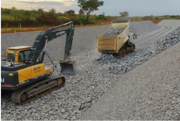
Figura 43 – Aplicação e conformação de enrocamento em paredes do canal periférico.
