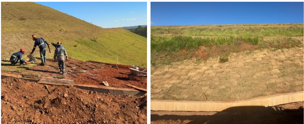
Figura 81 – Plantio de grama em taludes.
