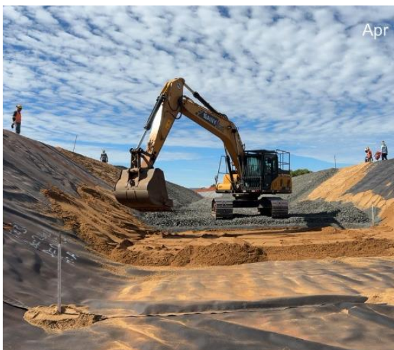
Figura 67 – Continuidade da aplicação da transição (areia, brita 0 e brita 3) sobre o revestimento em geomembrana.
