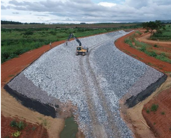
Figura 46 – Aplicação de enrocamento nas paredes do canal e vista geral de enrocamento aplicado.
