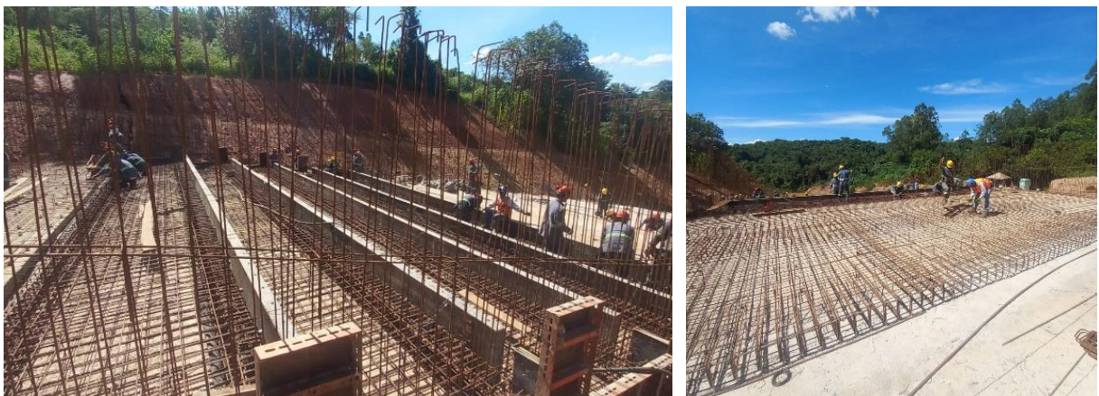
Figura 4 – Montagem de armadura e formas – módulos 19 e 20.
