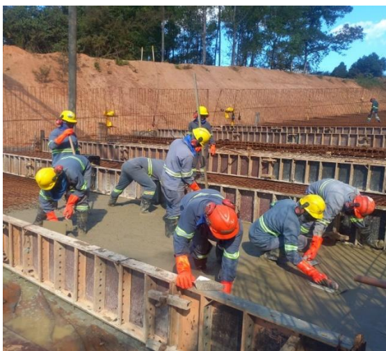
Figura 16 – Aplicação de concreto em piso – módulo 28 e cura úmida de concreto aplicado.
