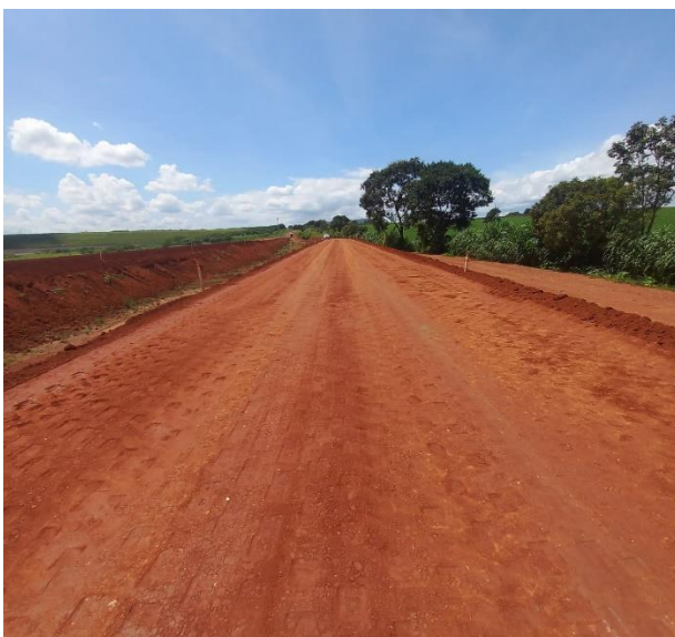
Figura 51 – Liberação de camada de aterro compactado a 95% PN.
