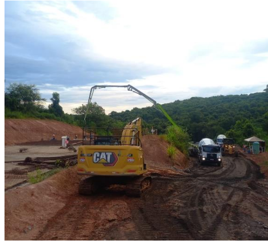
Figura 5 – Concretagem de piso – Módulo 19.
