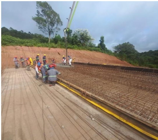
Figura 6 – Concretagem de piso – módulo 20.
