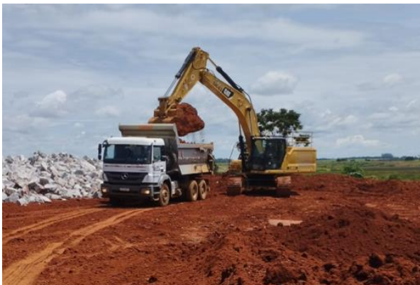
Figura 48 – Escavação, carga e transporte de material e compactação de aterro a 95% PN.
