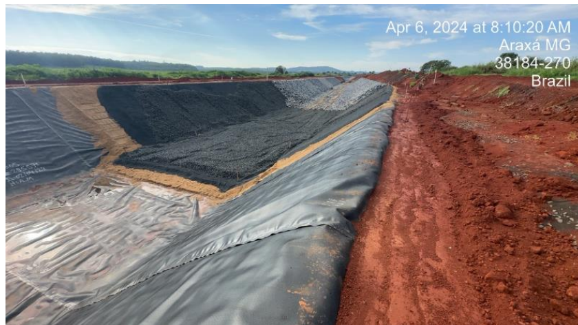
Figura 62 – Início da aplicação da transição (areia, brita 0 e brita 3) sobre o revestimento em geomembrana – Estaca 135.
