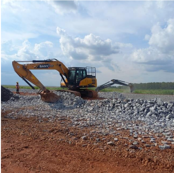
Figura 36 – Carregamento de enrocamento e lançamento nas paredes do canal periférico – estaca 75.
