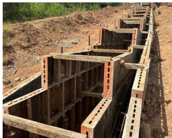
Figura 73 – Montagem de formas para concretagem – canais de drenagem ombreira esquerda e ombreira direita.
