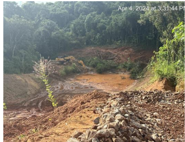
Figura 26 – Início da supressão vegetal e limpeza para implantação da bacia de dissipação.
