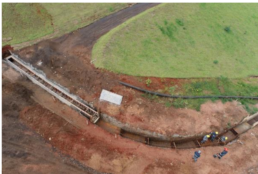
Figura 72 – Aplicação de armação – canal de drenagem ombreira direita.
