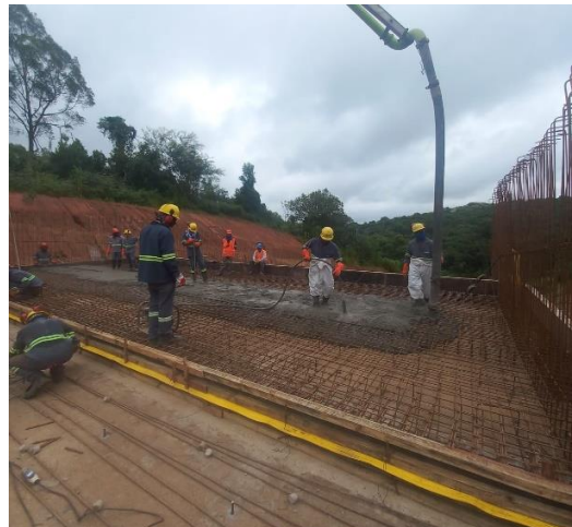
Figura 6 – Concretagem de piso – módulo 20.
