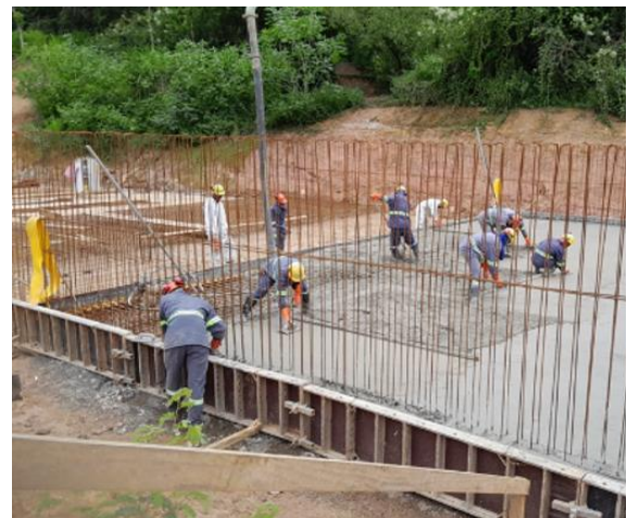
Figura 10 – Montagem de armação e aplicação de concreto em piso – módulo 22.
