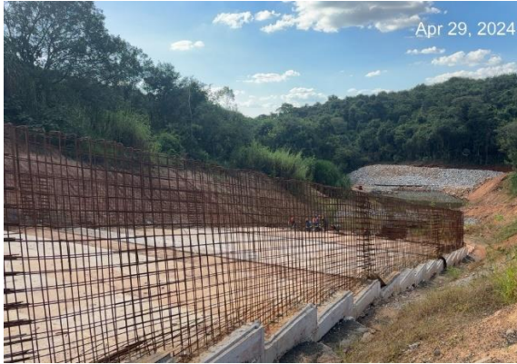
Figura 23 – Armação de paredes no canal rápido e cura úmida do concreto – módulos 25 a 30.
