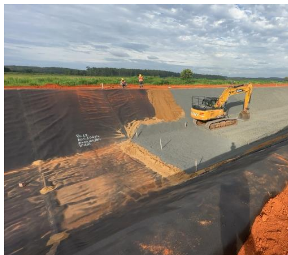
Figura 63 – Continuidade da aplicação da transição (areia, brita 0 e brita 3) sobre o revestimento em geomembrana – Estaca 136.
