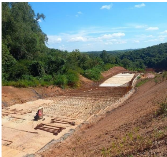
Figura 13 – Armação de piso e paredes – módulos 25 a 31.
