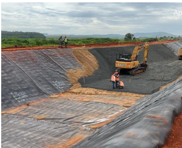
Figura 63 – Continuidade da aplicação da transição (areia, brita 0 e brita 3) sobre o revestimento em geomembrana – Estaca 136.
