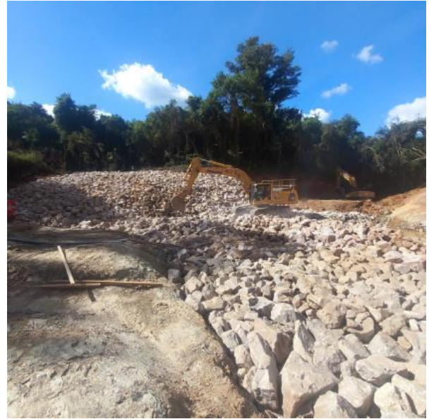
Figura 34 – Aplicação de enrocamento na bacia de dissipação.
