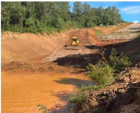
Figura 28 – Melhoria no acesso à bacia de dissipação e execução de supressão vegetal.
