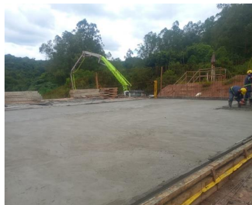
Figura 7 – Concretagem de piso – módulo 21.
