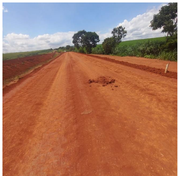
Figura 51 – Liberação de camada de aterro compactado a 95% PN.
