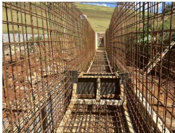
Figura 71 – Aplicação de armação – canais de drenagem ombreira direita e ombreira esquerda.
