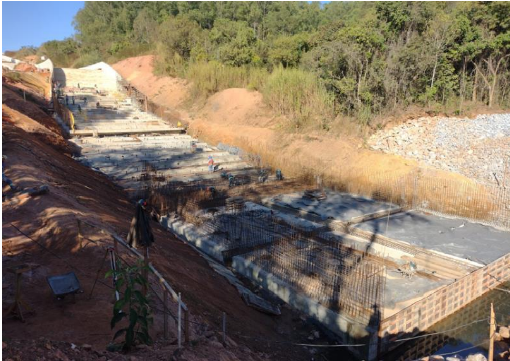
Figura 38 – Avanço geral canal rápido e bacia de dissipação
