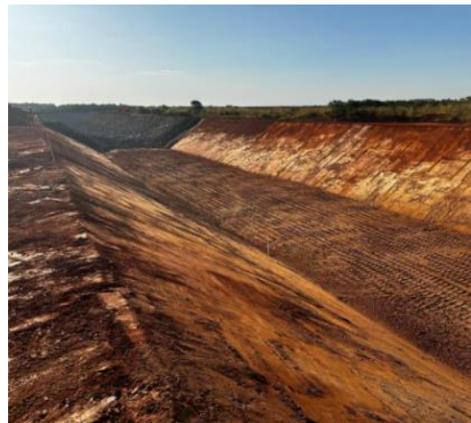
Figura 80 – Escavação e conformação de paredes do canal periférico – estaca 62
