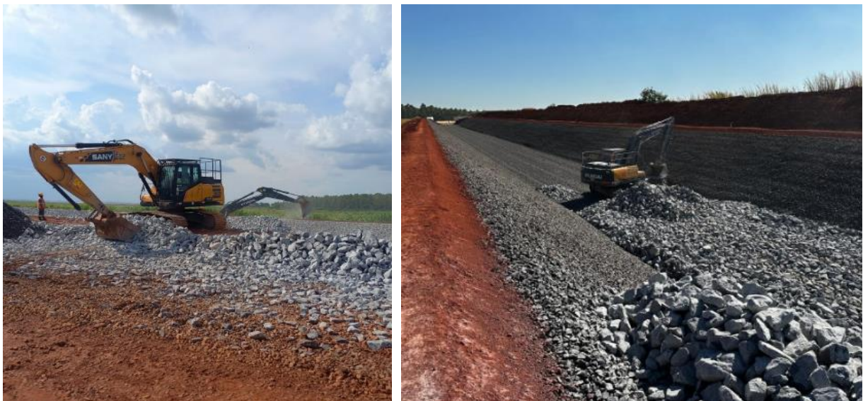
Figura 70 – Carregamento de enrocamento e lançamento nas paredes do canal periférico – estaca 145.
