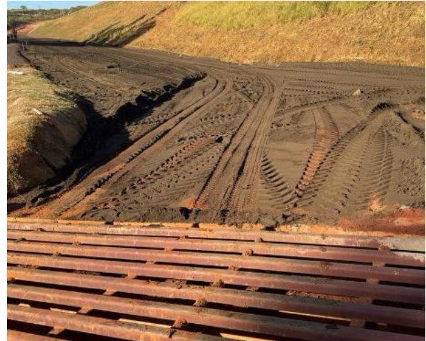
Figura 111 – Regularização de berma para direcionamento das águas superficiais.
