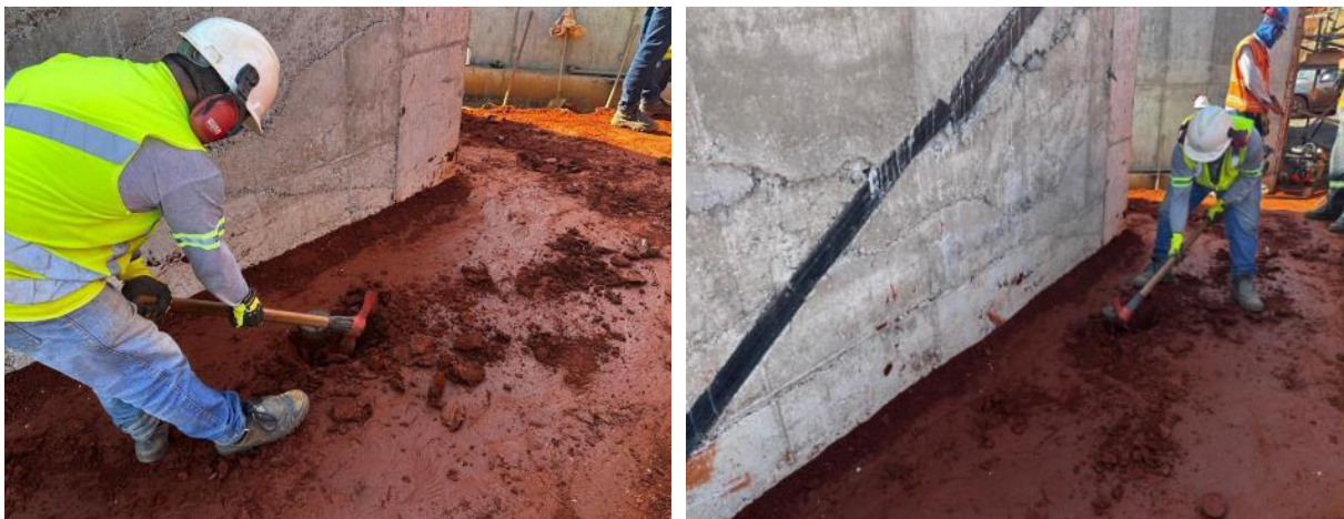
Figura 128 – Controle de qualidade realizado pela fiscalização – Retirada de corpo de prova para ensaio de compactação.
