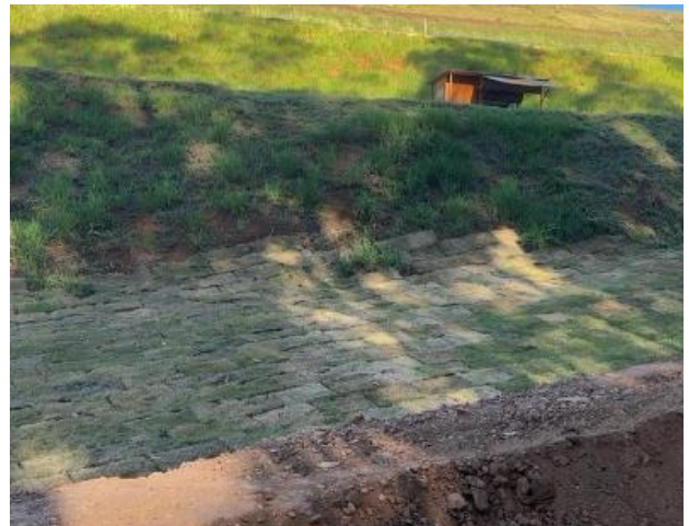
Figura 103 – Plantio de grama em placas nos taludes
