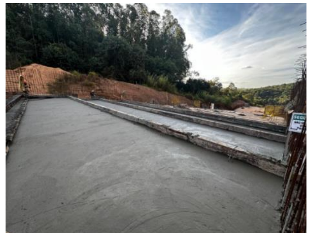
Figura 19 – Aplicação de concreto em piso e piso finalizado – módulo 18
