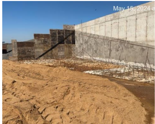
Figura 9 – Posicionamento de engelock e preparo para execução da ala de transição em pedra argamassada
