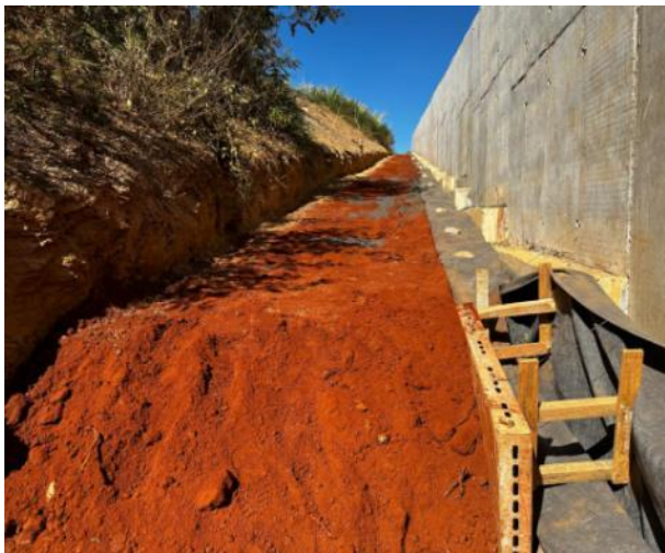
Figura 64 – Formas para execução do dreno e reaterro lateral
