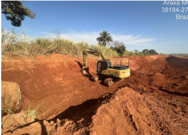
Figura 88 – Espalhamento de material para aterro e vista geral – estaca 22
