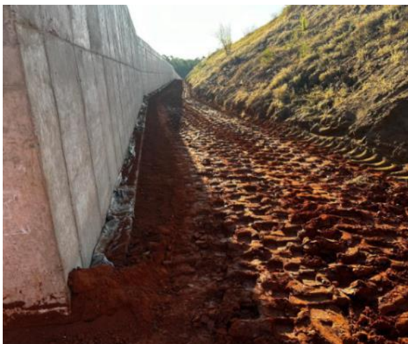
Figura 65 – Reaterro nas laterais do canal sobre dreno lateral.
