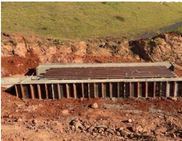
Figura 100 – Execução de forma e concretagem das travessias tipo “mata-burro”
