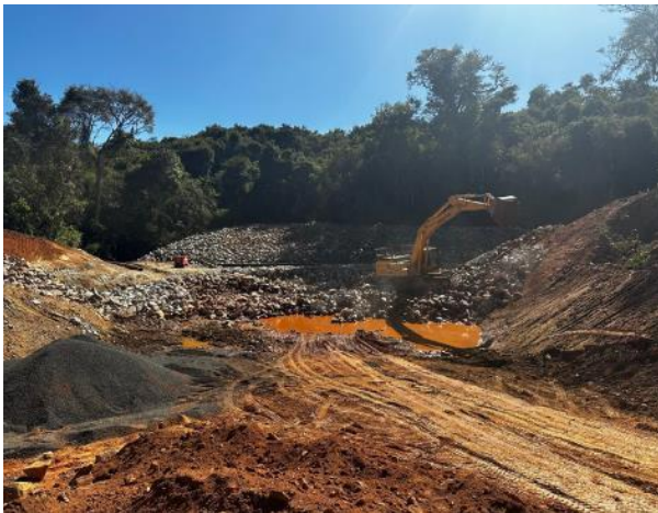
Figura 46 – Aplicação de enrocamento na bacia de dissipação.
