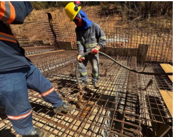
Figura 30 – Execução de armação e teste de drenagem nos barbacãs – módulo 12
