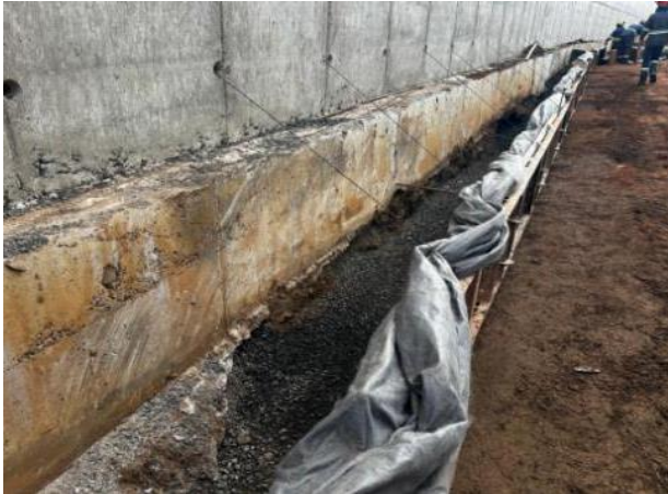
Figura 57 – Execução de dreno lateral – aplicação de geotêxtil e brita 0
