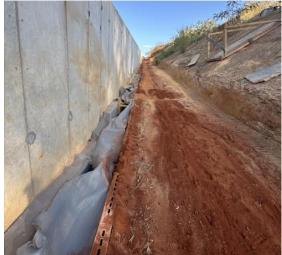
Figura 63 – Aplicação de tudo tipo “kananet” e reaterro lateral do dreno
