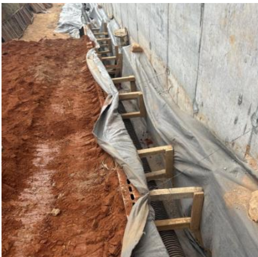
Figura 59 – Execução de formas para execução do dreno e dreno finalizado com reaterro lateral
