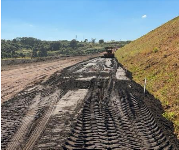
Figura 111 – Regularização de berma para direcionamento das águas superficiais.
