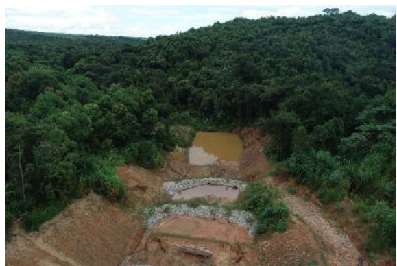
Figura 122 – Escavação, concretagem da laje de piso do canal rápido e proteção com enrocamento no deságue do canal provisório.
