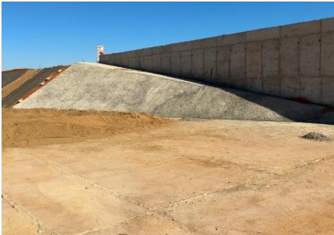
Figura 12 – Pedra argamassada finalizada e detalhe – englock
