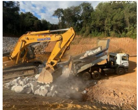
Figura 43 – Aplicação de enrocamento na bacia de dissipação
