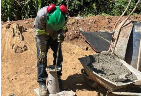
Figura 125 – Controle de qualidade realizado pela fiscalização – Ensaio de “slump test” realizado em concreto.
