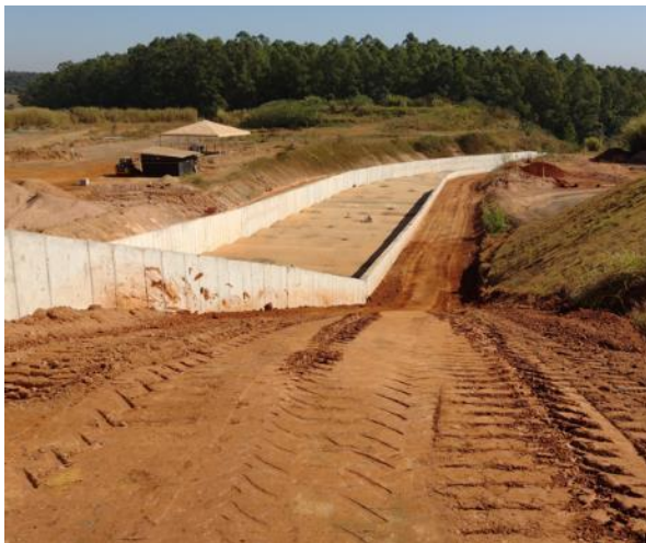
Figura 67 – Reaterro nas laterais do canal sobre dreno lateral
