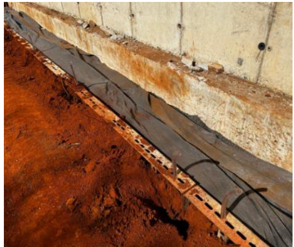
Figura 58 – Execução de dreno lateral – aplicação de geotêxtil, brita 0, tubo tipo “kananet” e reaterro lateral
