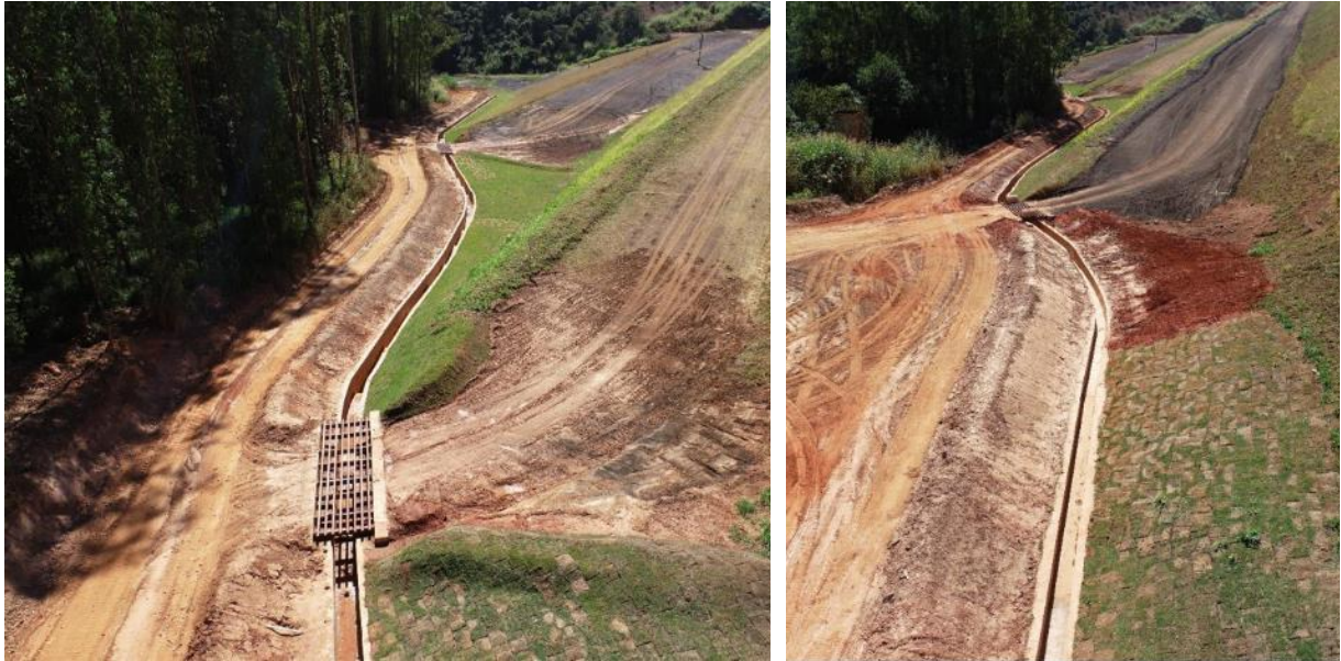
Figura 118 – Vistas da finalização da implantação do canal de drenagem – ombreira esquerda.
