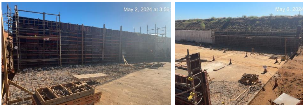
Figura 4 – Montagem de formas para concretagem – Transições 1 e 2
