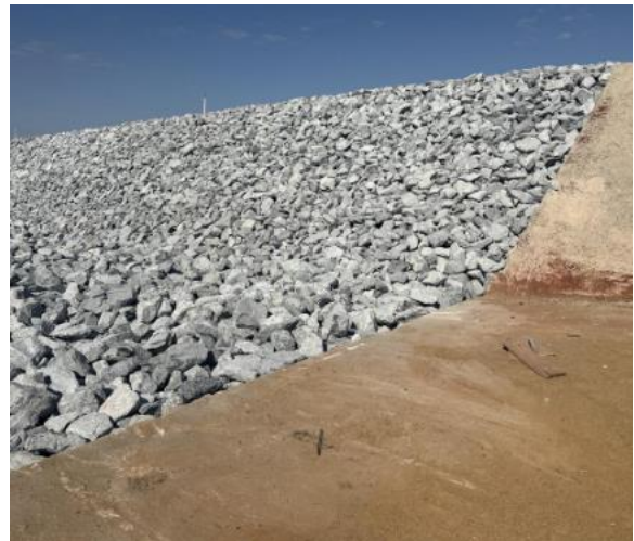
Figura 75 – Aplicação de transições finalizada no trecho de encontro do canal periférico e canal rápido
