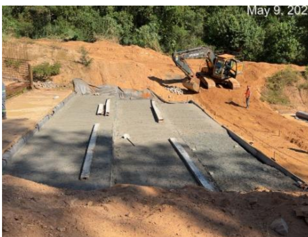
Figura 7 – Execução de concreto magro módulo 12 – início e avanço
