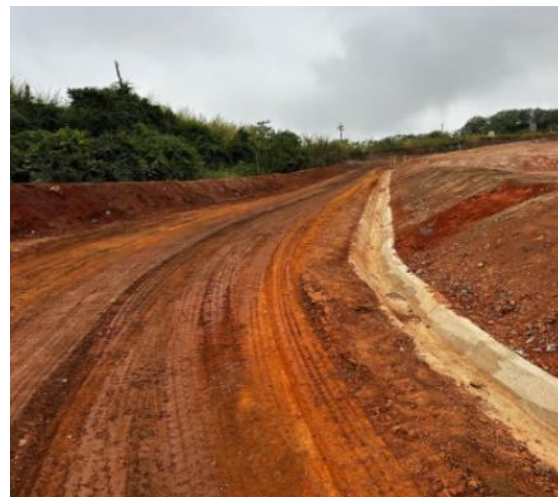
Figura 113 – Regularização de acesso – ombreira direita.
