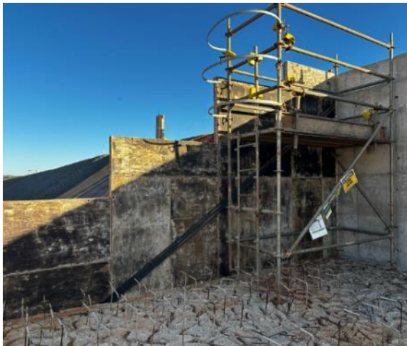
Figura 9 – Posicionamento de engelock e preparo para execução da ala de transição em pedra argamassada
