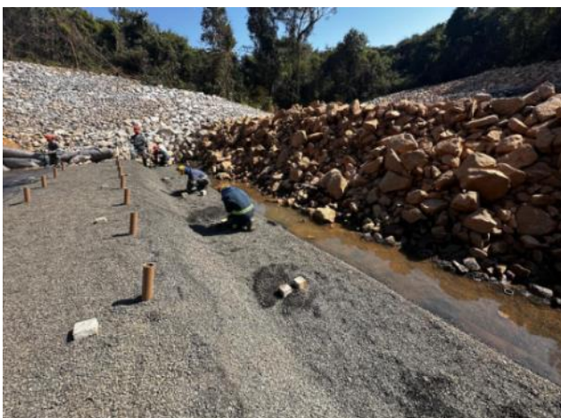
Figura 31 – Preparo para recebimento do concreto magro e aplicação de concreto magro – módulo 07
