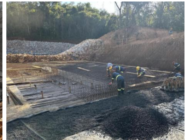
Figura 33 – Montagem de armação em piso – módulo 07
