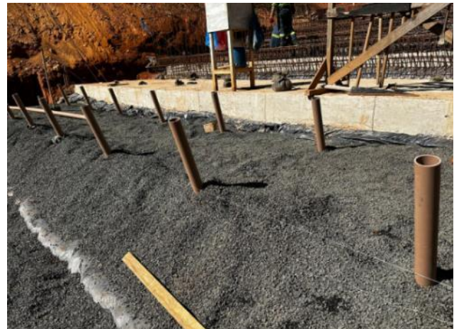
Figura 25 – Execução dos drenos tipo barbacãs e aplicação em piso
