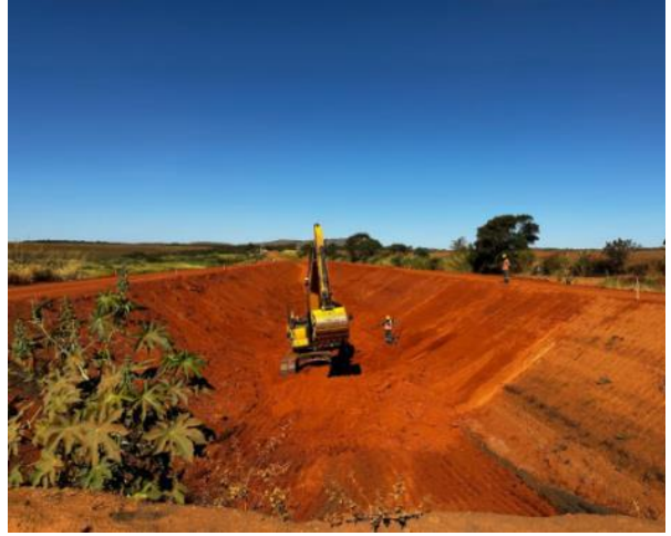
Figura 82 – Conformação de piso e paredes do canal periférico – estaca 43
