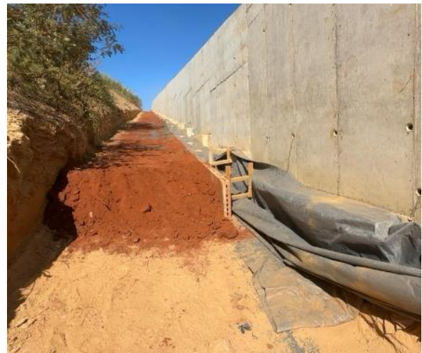
Figura 64 – Formas para execução do dreno e reaterro lateral
