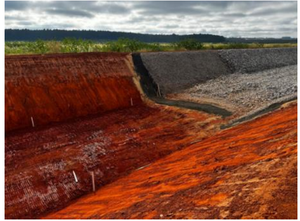
Figura 79 – Escavação e conformação de paredes do canal periférico – estaca 59
