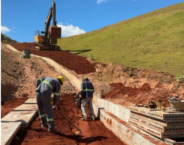
Figura 99 – Execução de reaterro compactado nas laterais do canal da ombreira direita
