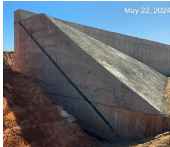
Figura 12 – Pedra argamassada finalizada e detalhe – englock
