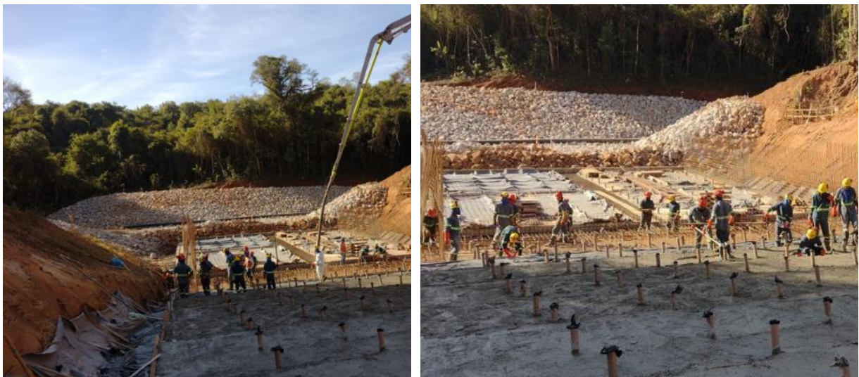
Figura 37 – Aplicação de concreto em piso parte II – módulo 07
