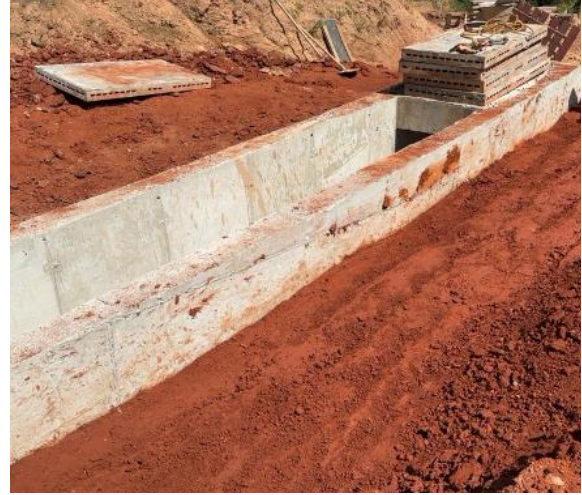
Figura 99 – Execução de reaterro compactado nas laterais do canal da ombreira direita
