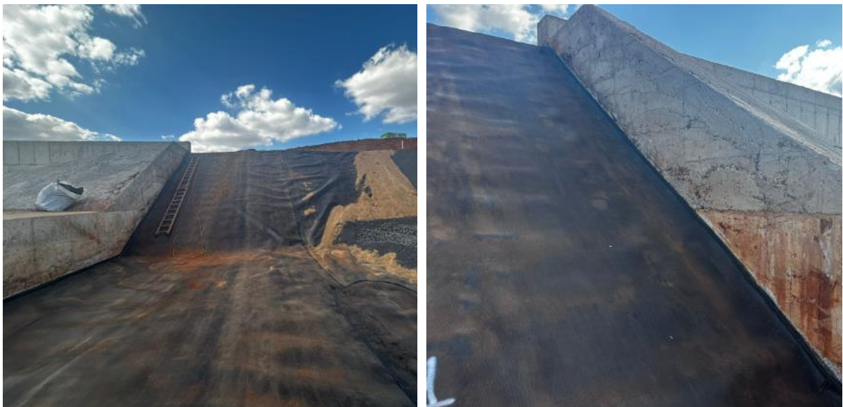
Figura 92 – Aplicação de geomembrana em paredes e detalhe de solda de ligação – painel – englock
