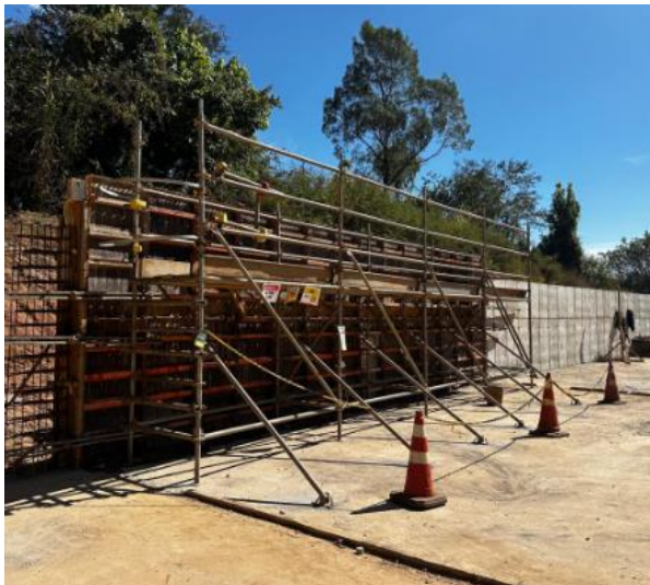
Figura 15 – Montagem de forma em parede e concretagem de paredes – módulo 24
