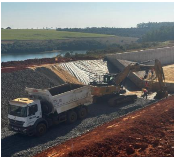
Figura 72 – Aplicação de transição em piso e paredes do canal periférico – estaca 170.
