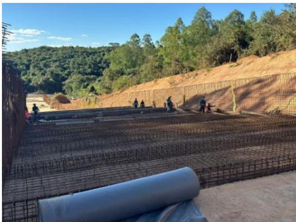
Figura 6 – Armação e piso concretado – módulo 26
