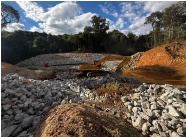
Figura 43 – Aplicação de enrocamento na bacia de dissipação
