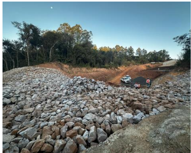
Figura 49 – Aplicação de enrocamento na bacia de dissipação.
