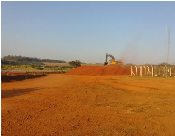
Figura 89 – Carregamento e área de empréstimo de material para aterro
