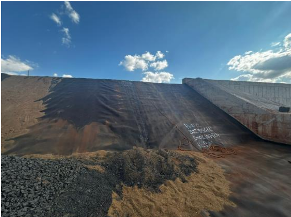
Figura 91 – Aplicação de geomembrana em paredes com execução de solda
