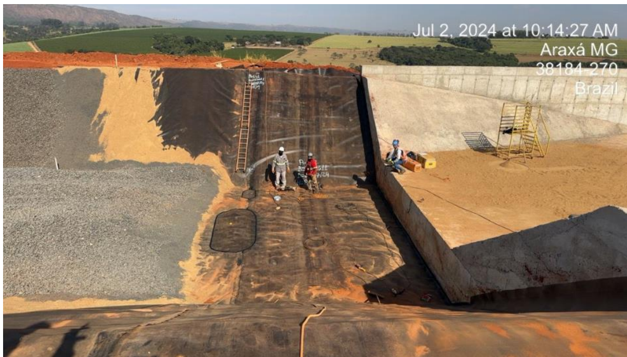
Figura 97 – Vista geral da aplicação do trecho final – encontro canal periférico e canal rápido – estaca 170
