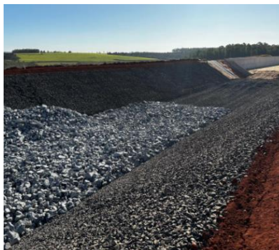
Figura 73 – Lançamento e conformação de enrocamento em piso e paredes do canal periférico – estacas 160 a 170.
