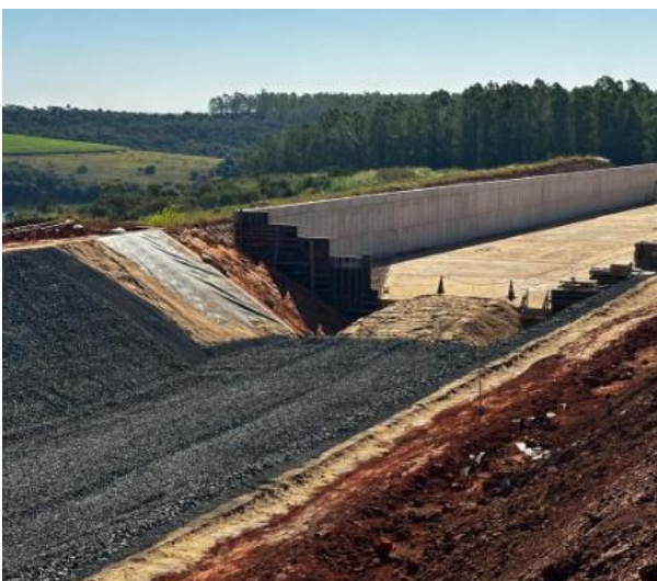
Figura 72 – Aplicação de transição em piso e paredes do canal periférico – estaca 170.
