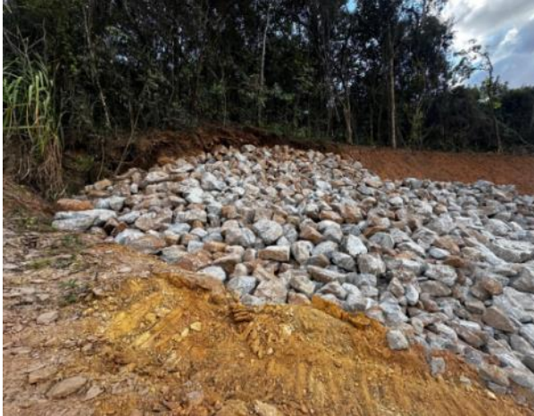
Figura 42 – Enrocamento finalizado (aplicado em erosão) – bacia de dissipação.
