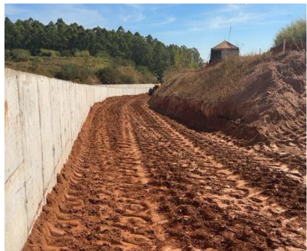
Figura 65 – Reaterro nas laterais do canal sobre dreno lateral.
