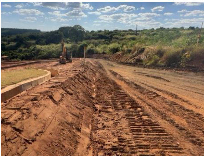
Figura 113 – Regularização de acesso – ombreira direita.
