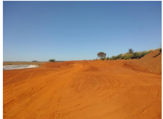
Figura 89 – Carregamento e área de empréstimo de material para aterro
