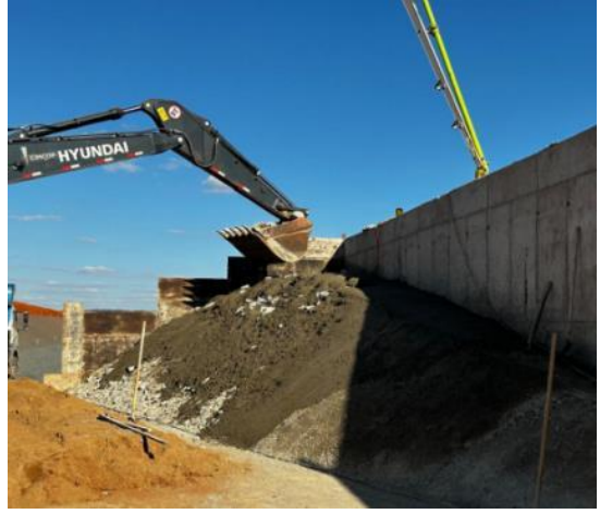
Figura 11 – Aplicação de pedra argamassada na execução da ala de transição
