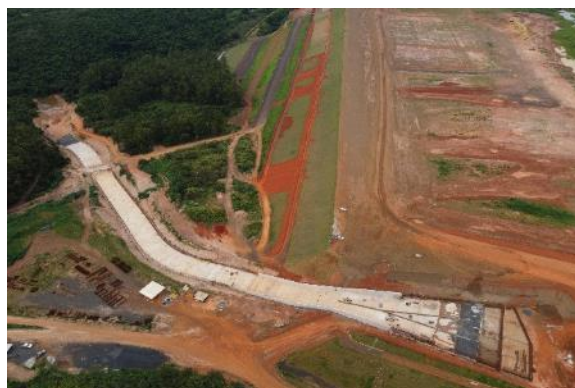
Figura 122 – Escavação, concretagem da laje de piso do canal rápido e proteção com enrocamento no deságue do canal provisório.
