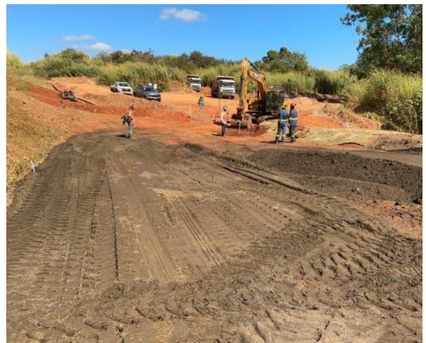
Figura 110 – Regularização de berma para direcionamento das águas superficiais.
