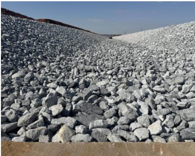
Figura 75 – Aplicação de transições finalizada no trecho de encontro do canal periférico e canal rápido
