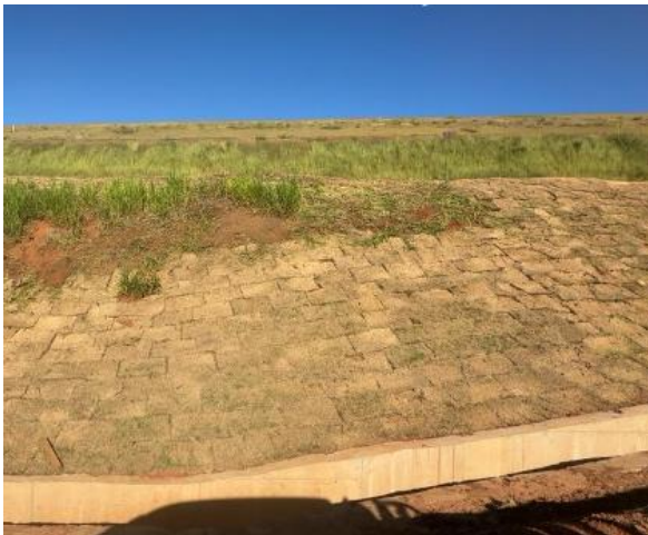
Figura 103 – Plantio de grama em placas nos taludes
