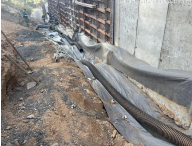
Figura 63 – Aplicação de tudo tipo “kananet” e reaterro lateral do dreno
