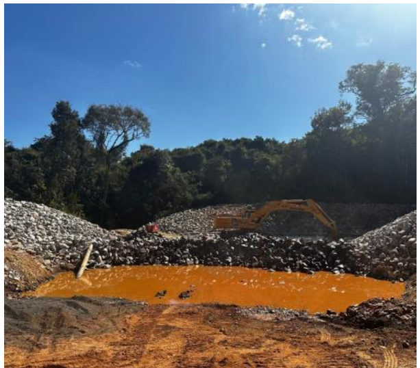
Figura 47 – Aplicação de enrocamento na bacia de dissipação e drenagem de surgências de água
