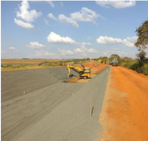
Figura 83 – Aplicação de transições (areia e brita 0) nas paredes e piso canal – estaca 33
