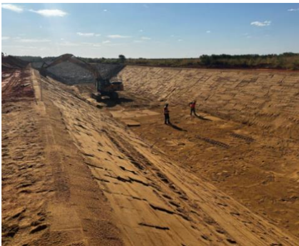
Figura 81 – Aplicação de transição – areia – em piso e paredes do canal periférico – estaca 60
