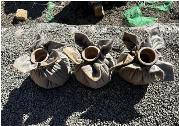
Figura 22 – Execução dos drenos tipo barbancãs e aplicação em piso
