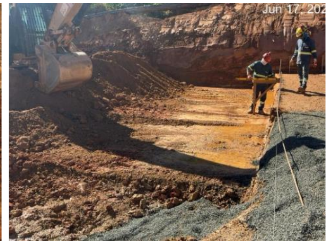
Figura 27 – Escavação de piso – módulo 09
