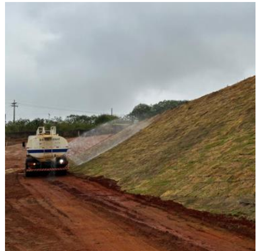
Figura 104 – Umidificação de grama após o plantio
