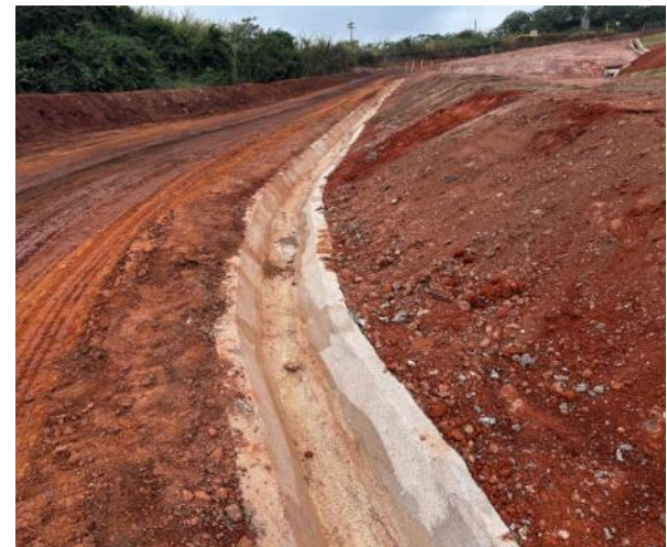
Figura 112 – Execução de canaleta de drenagem do acesso – armação e concretagem
