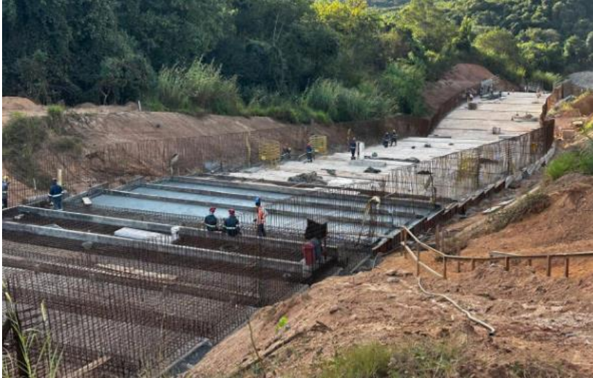
Figura 20 – Avanço – armação, formas e concretagem
