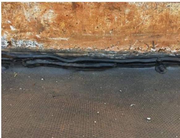
Figura 95 – Detalhe de solda por extrusão.
