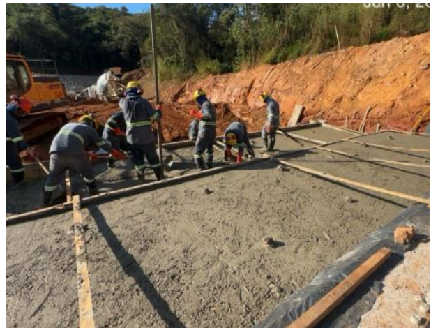
Figura 24 – Preparo de piso para execução do magro e aplicação de concreto magro – módulo 10
