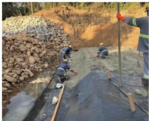
Figura 31 – Preparo para recebimento do concreto magro e aplicação de concreto magro – módulo 07
