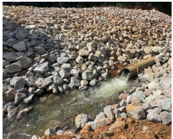
Figura 51 – Aplicação de enrocamento e monitoramento de qualidade da água no desvio provisório do fluxo
