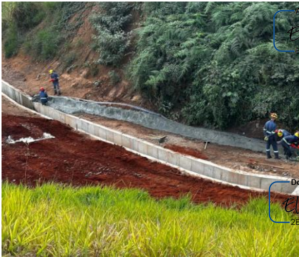
Figura 109 – Execução de pedra argamassada para direcionamento do fluxo de águas do MV.
