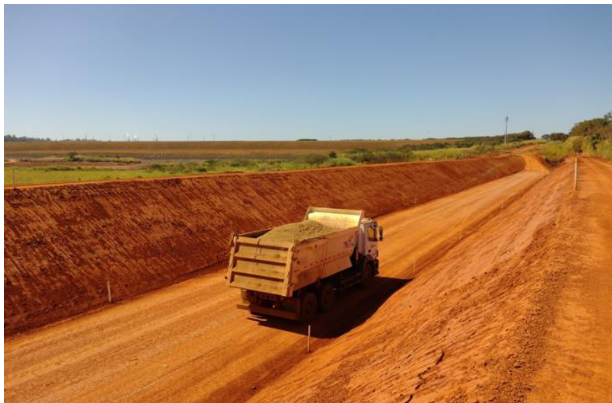
Figura 90 – Finalização do aterro e conformação do trecho para início do lançamento das transições
