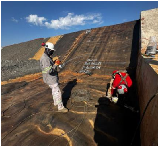
Figura 94 – Execução de solda de ligação painel – englock e execução de ensaio não destrutivo em solda
