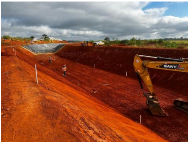
Figura 80 – Escavação e conformação de paredes do canal periférico – estaca 62
