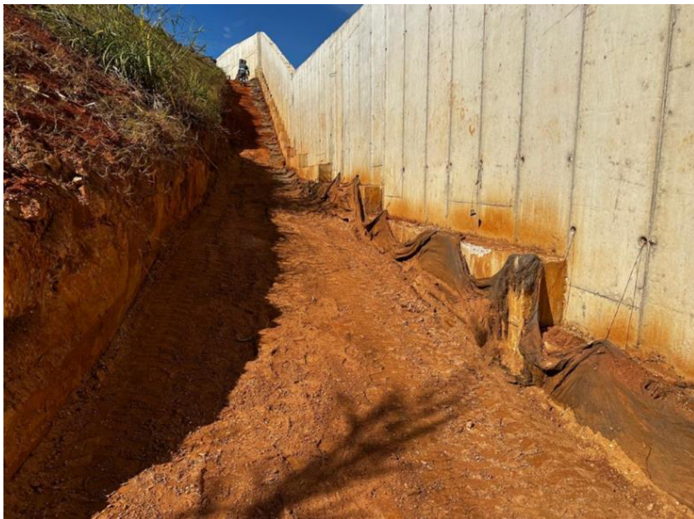
Figura 56 – Limpeza para encontro de dreno de fundo com dreno lateral ao canal rápido.
