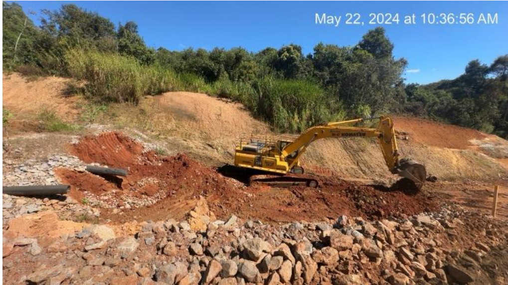
Figura 17 – Escavação de degraus – módulo 12.
