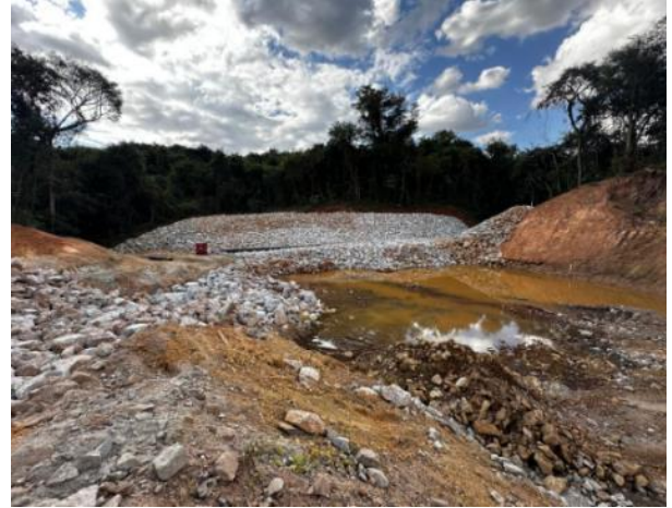
Figura 42 – Enrocamento finalizado (aplicado em erosão) – bacia de dissipação.
