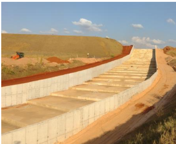
Figura 68 – Reaterro nas laterais do canal sobre dreno lateral
