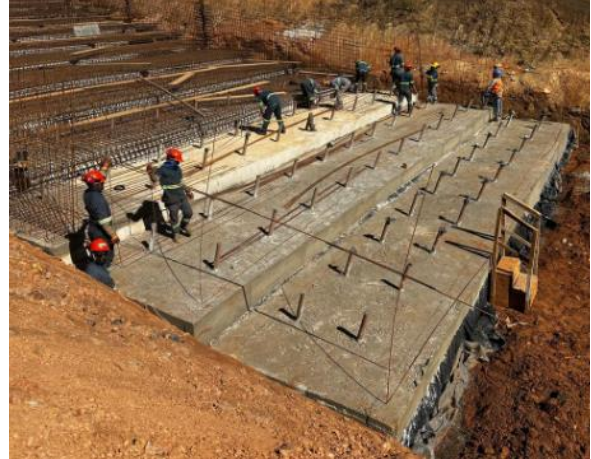
Figura 29 – Preparo para execução de concreto e magro e concreto magro aplicado – módulo 08
