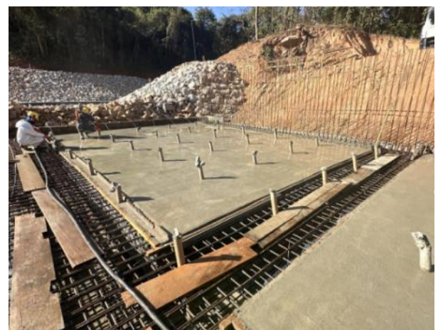
Figura 34 – Concretagem de piso parte I – módulo 07
