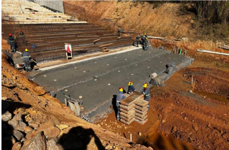
Figura 23 – Aplicação de brita e posicionamento dos barbacãs em piso – módulo 11
