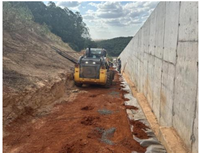
Figura 61 – Abertura das laterais para execução do dreno.
