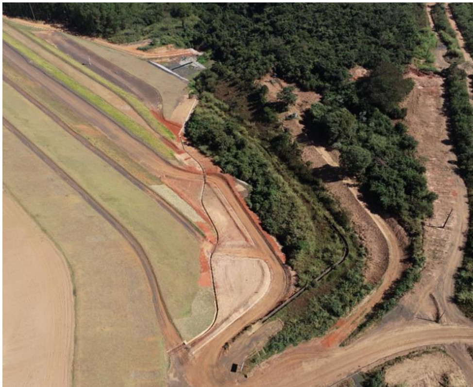
Figura 115 – Vista geral da finalização da implantação do canal de drenagem – ombreira direita.
