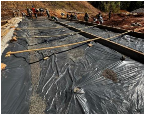
Figura 24 – Preparo de piso para execução do magro e aplicação de concreto magro – módulo 10
