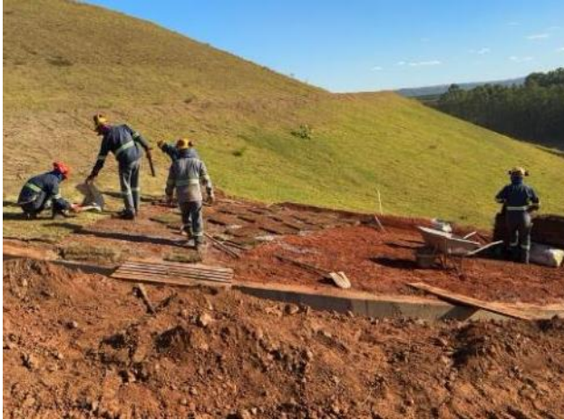
Figura 102 – Plantio de grama em placas nos taludes – bermas 920 e 930
