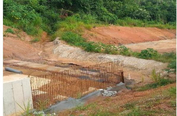
Figura 120 – Leira de proteção e abertura lateral para escoamento do fluxo.
