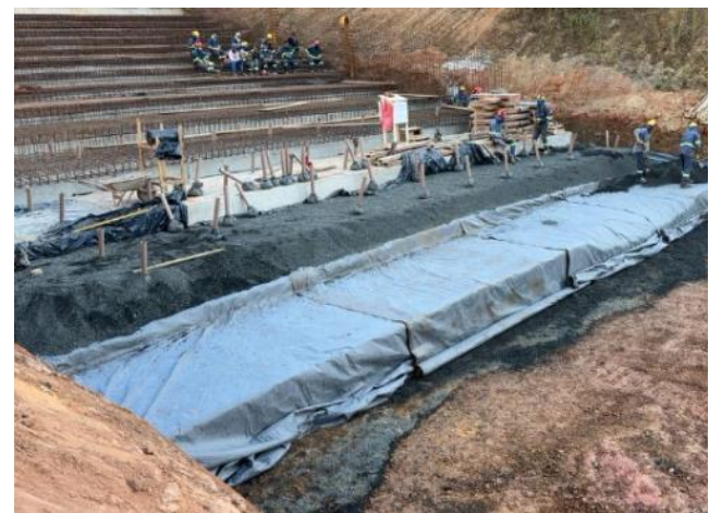
Figura 28 – Execução de drenagem com brita para andamento das atividades e aplicação de geotêxtil em piso – módulo 10
