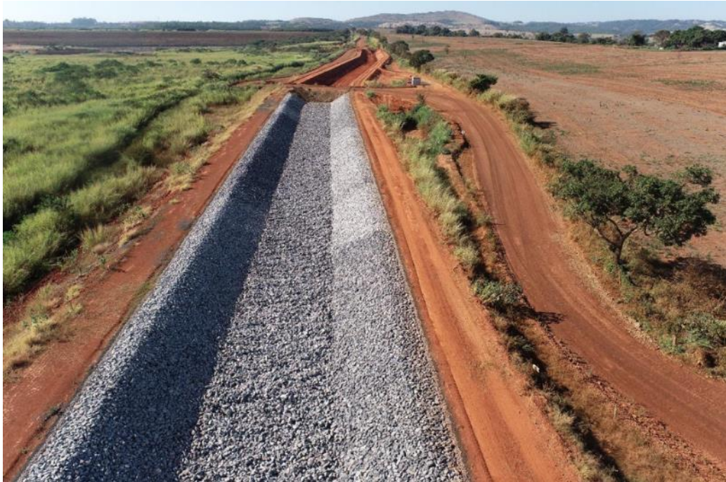
Figura 77 – Avanço da transição (areia, brita 0 e brita 3) e enrocamento no canal periférico.
