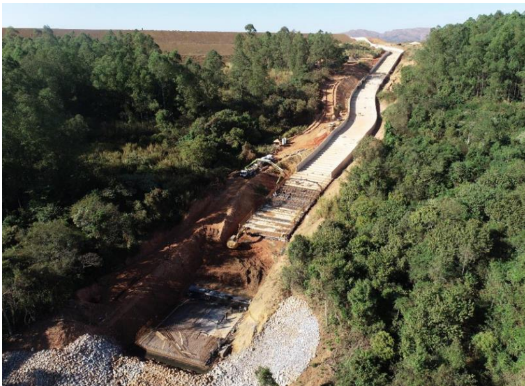
Figura 39 – Avanço geral canal rápido e bacia de dissipação
