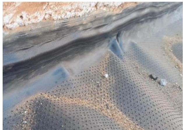
Figura 95 – Detalhe de solda por extrusão.
