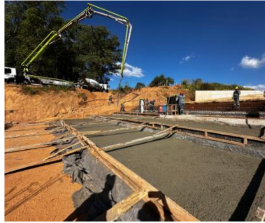
Figura 14 – Aplicação de brita em piso e execução de concreto magro
