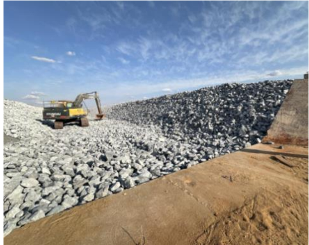
Figura 74 – Lançamento e conformação de enrocamento em piso e parede – canal periférico – estacas 160 a 170.
