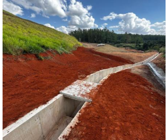
Figura 108 – Reaterro das laterais com direcionamento para fluxo de águas superficiais – ombreira direita.
