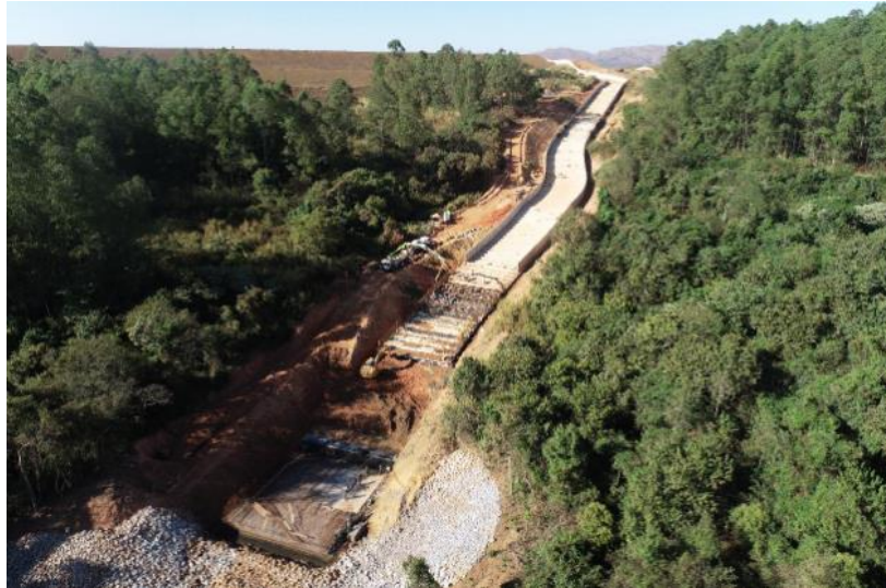
Figura 8 – Vista geral do avanço do canal rápido.
