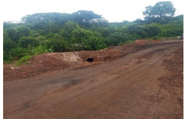
Figura 121 – Construção de passagens molhadas direcionando fluxo para talvegue antigo extravasor na ombreira esquerda e sump existente da ombreira direita.
