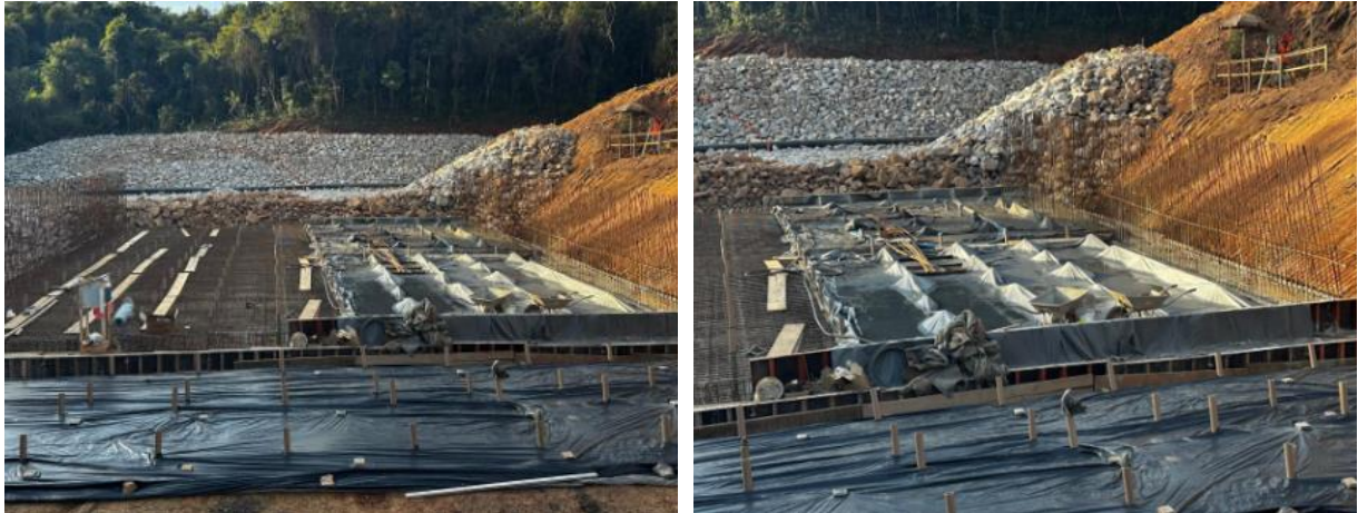
Figura 35 – Cura úmida do concreto – módulo 07
