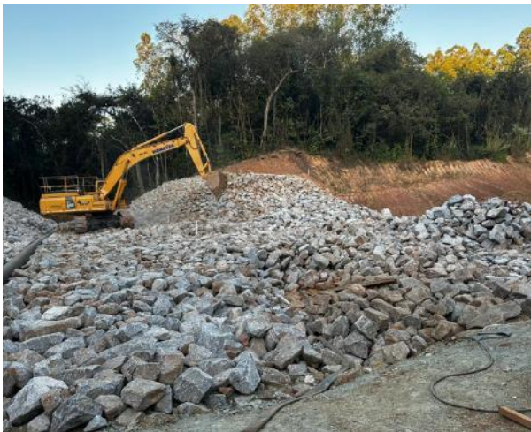
Figura 49 – Aplicação de enrocamento na bacia de dissipação.
