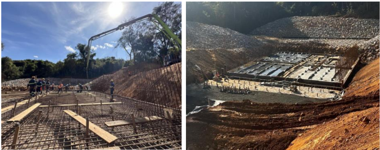
Figura 36 – Aplicação de concreto em piso parte II – módulo 07
