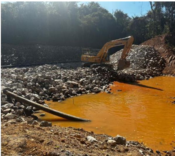
Figura 47 – Aplicação de enrocamento na bacia de dissipação e drenagem de surgências de água
