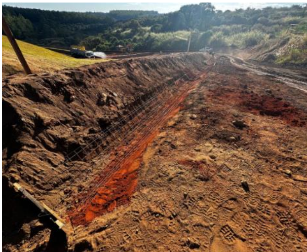
Figura 112 – Execução de canaleta de drenagem do acesso – armação e concretagem
