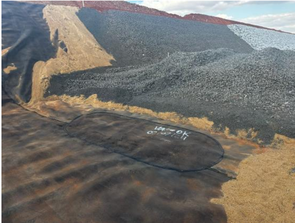
Figura 96 – Detalhe de “manchão” executado entre painéis
