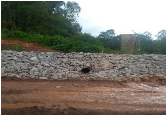
Figura 121 – Construção de passagens molhadas direcionando fluxo para talvegue antigo extravasor na ombreira esquerda e sump existente da ombreira direita.
