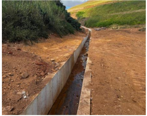
Figura 105 – Reaterro das laterais – canal de drenagem ombreira esquerda e direita.
