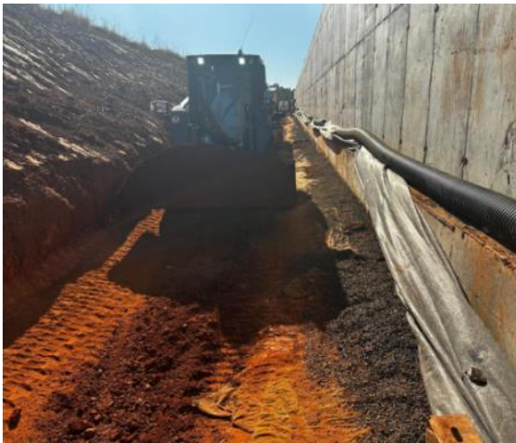
Figura 61 – Abertura das laterais para execução do dreno.
