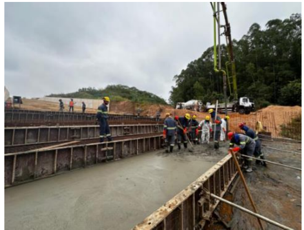
Figura 18 – Aplicação de concreto em piso – módulo 19
