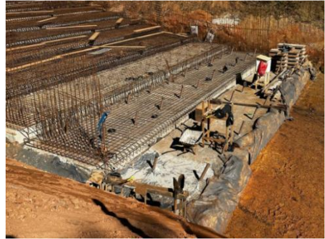
Figura 26 – Aplicação de concreto magro e montagem de armação em piso – módulo 09
