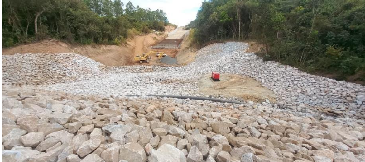
Figura 50 – Vista geral da execução da bacia de dissipação – com desvio do fluxo de água do córrego Capivara
