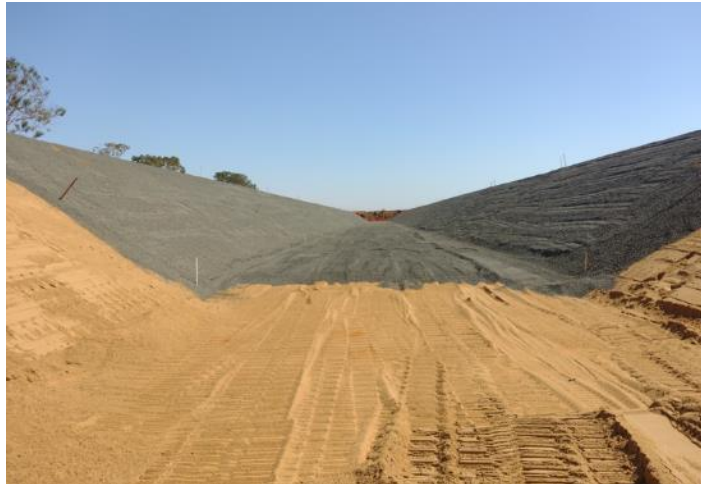
Figura 83 – Aplicação de transições (areia e brita 0) nas paredes e piso canal – estaca 33
