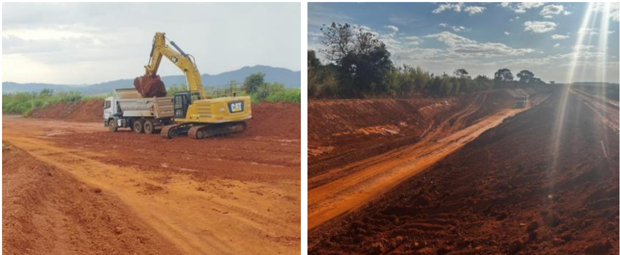
Figura 85 – Escavação, carga e transporte de material para execução de aterro – estaca 22 a 43
