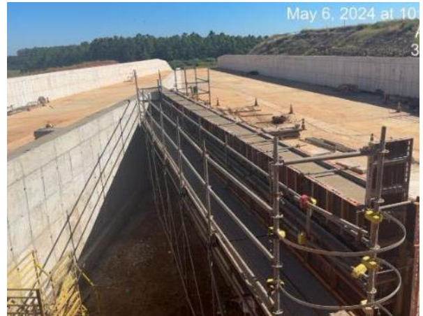
Figura 5 – Concretagem de paredes – Transições 1 e 2
