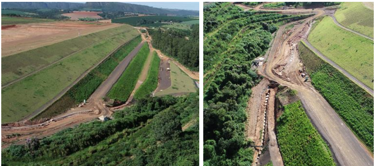
Figura 98 – Vista geral da readequação do maciço principal da B5 e vista geral da ombreira direita.
