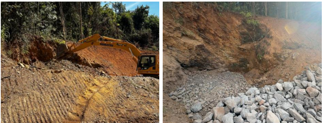
Figura 41 – Aplicação de enrocamento em erosão – bacia de dissipação.
