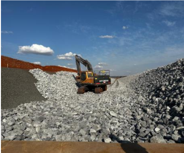
Figura 74 – Lançamento e conformação de enrocamento em piso e parede – canal periférico – estacas 160 a 170.
