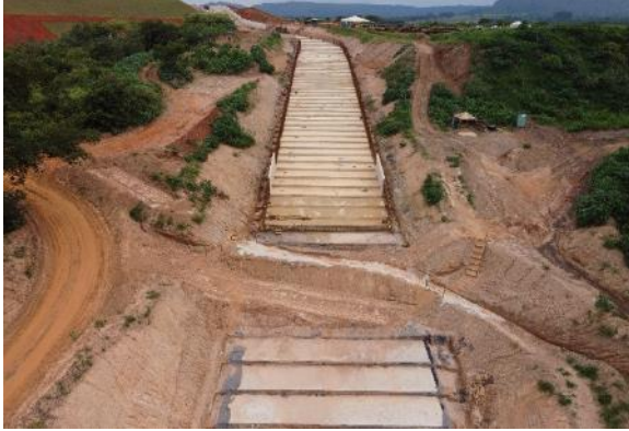
Figura 120 – Leira de proteção e abertura lateral para escoamento do fluxo.
