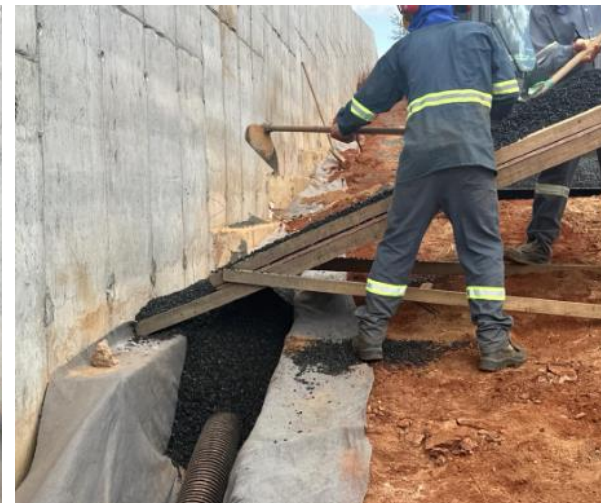
Figura 62 – Execução de formas para execução do dreno e aplicação de brita 0
