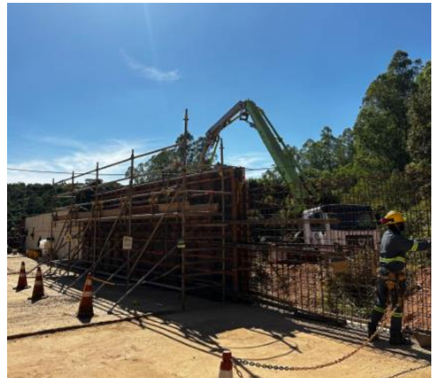
Figura 15 – Montagem de forma em parede e concretagem de paredes – módulo 24
