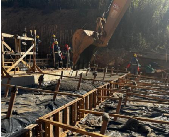
Figura 26 – Aplicação de concreto magro e montagem de armação em piso – módulo 09
