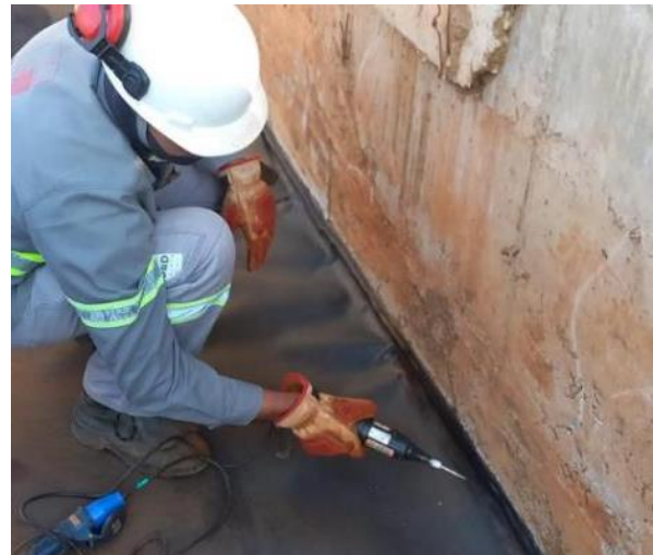
Figura 94 – Execução de solda de ligação painel – englock e execução de ensaio não destrutivo em solda
