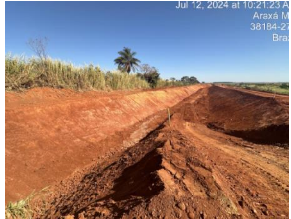
Figura 88 – Espalhamento de material para aterro e vista geral – estaca 22
