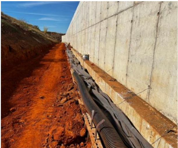
Figura 58 – Execução de dreno lateral – aplicação de geotêxtil, brita 0, tubo tipo “kananet” e reaterro lateral
