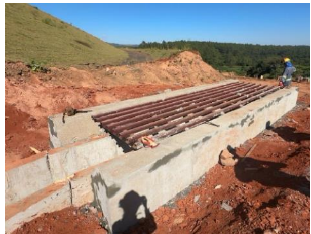
Figura 100 – Execução de forma e concretagem das travessias tipo “mata-burro”
