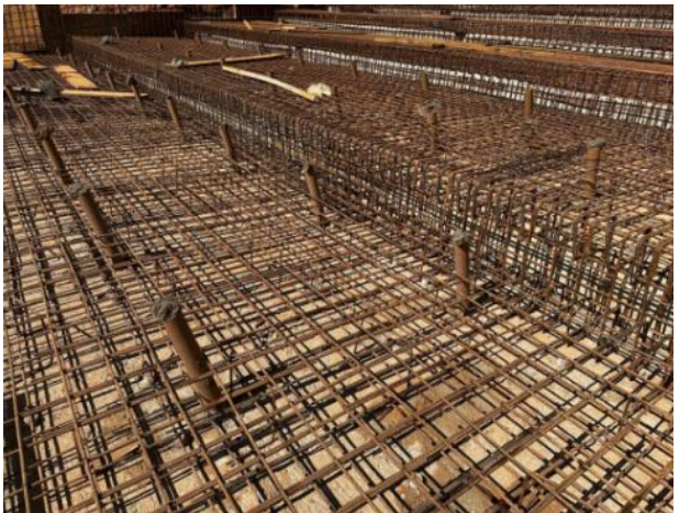
Figura 30 – Execução de armação e teste de drenagem nos barbacãs – módulo 12
