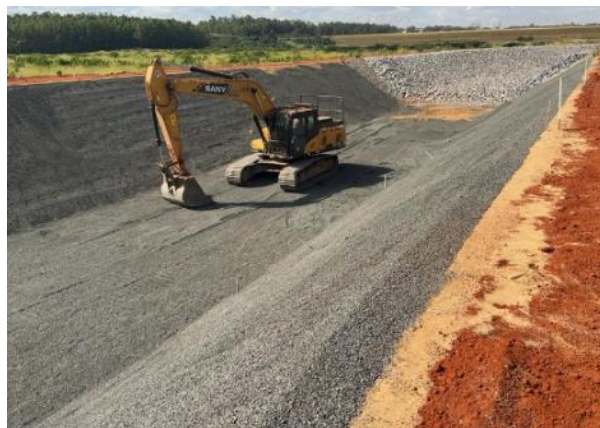
Figura 71 – Aplicação de transição – brita 3 – nas paredes e piso do canal periférico – estaca 68.
