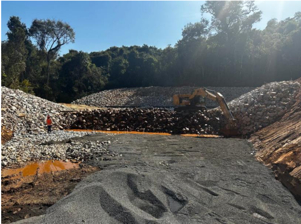
Figura 53 – Vista geral – Conformação final do enrocamento na bacia de dissipação.
