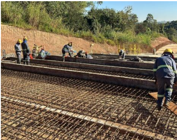
Figura 13 – Execução de armação e formas em piso e paredes – módulo 22
