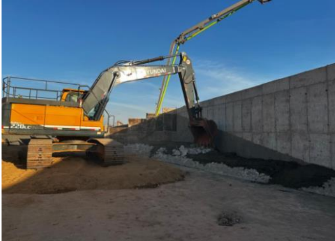
Figura 11 – Aplicação de pedra argamassada na execução da ala de transição
