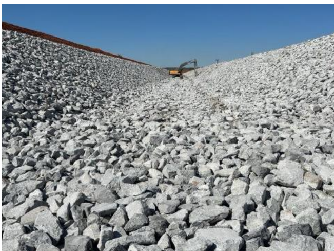
Figura 73 – Lançamento e conformação de enrocamento em piso e paredes do canal periférico – estacas 160 a 170.
