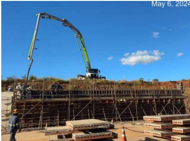
Figura 5 – Concretagem de paredes – Transições 1 e 2
