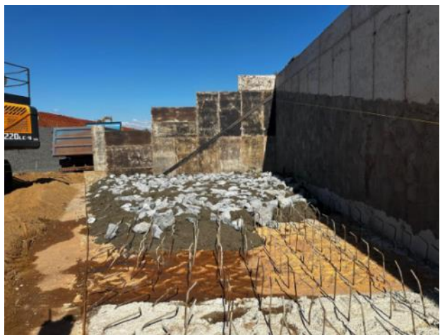
Figura 10 – Aplicação de pedra argamassada na execução da ala de transição
