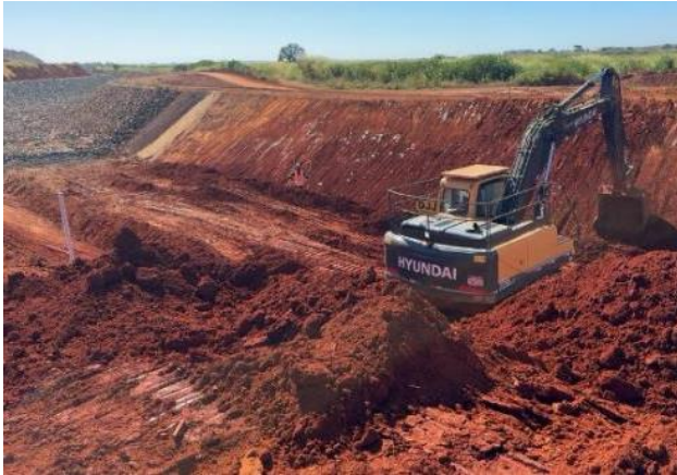
Figura 79 – Escavação e conformação de paredes do canal periférico – estaca 59
