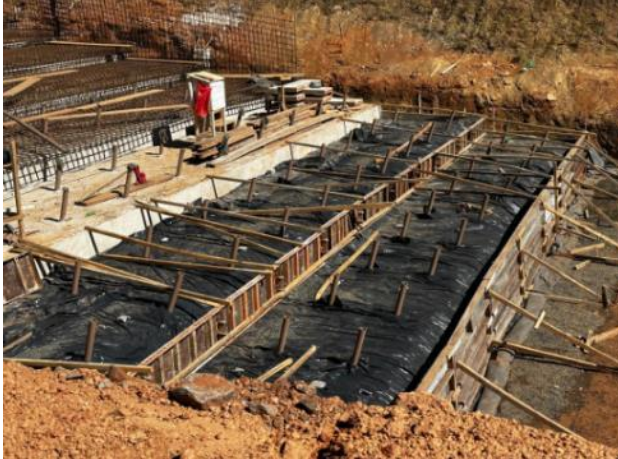
Figura 29 – Preparo para execução de concreto e magro e concreto magro aplicado – módulo 08
