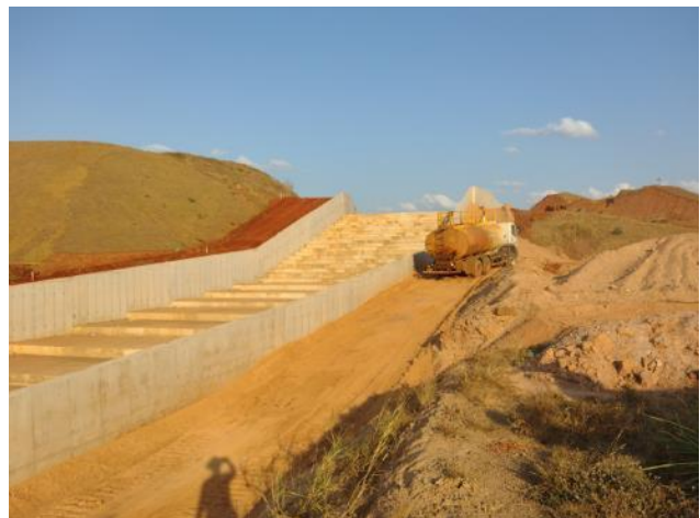
Figura 68 – Reaterro nas laterais do canal sobre dreno lateral
