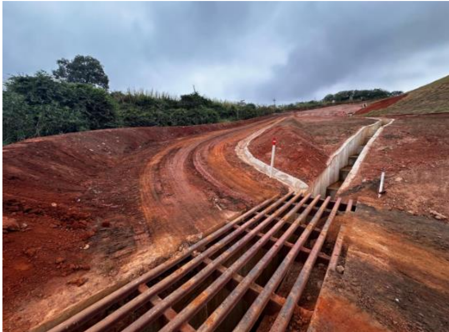
Figura 114 – Ombreira direita – regularização de acesso, canal e canaleta de drenagem e travessia
