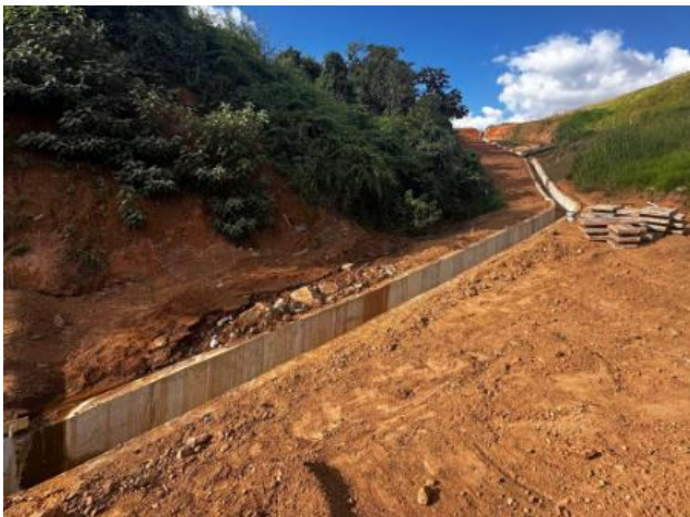
Figura 107 – Reaterro das laterais – ombreira direita.
