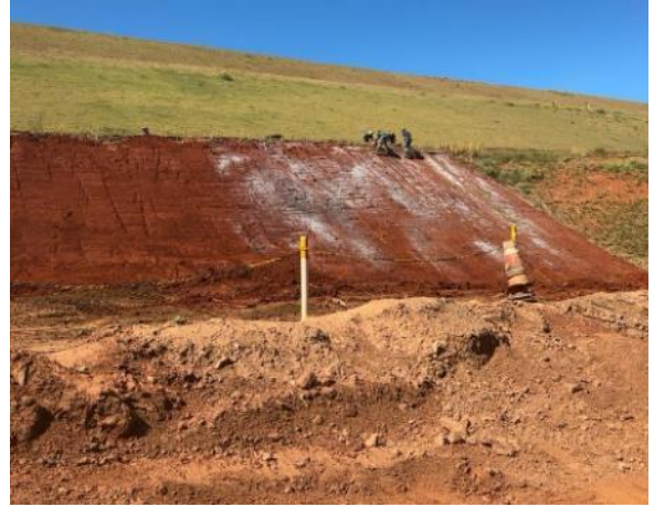
Figura 102 – Plantio de grama em placas nos taludes – bermas 920 e 930
