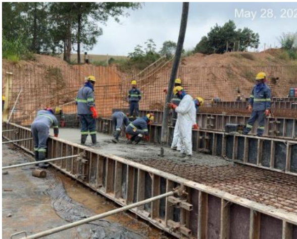
Figura 18 – Aplicação de concreto em piso – módulo 19
