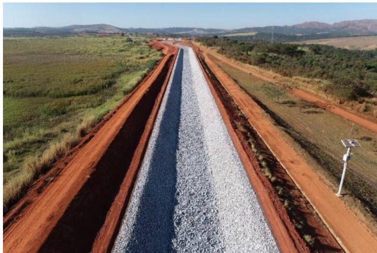
Figura 76 – Avanço da transição (areia, brita 0 e brita 3) e enrocamento no canal periférico.
