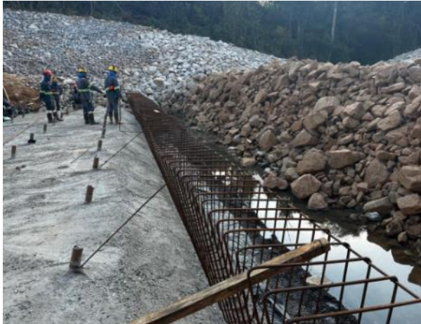
Figura 32 – Montagem de armação após finalização do concreto magro – módulo 07
