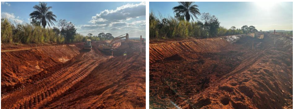
Figura 87 – Compactação de aterro a 95% PN e espalhamento de material para aterro - estaca 22 a 43.
