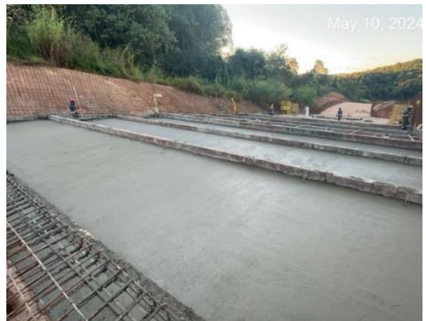
Figura 6 – Armação e piso concretado – módulo 26
