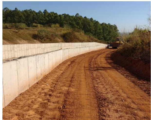
Figura 67 – Reaterro nas laterais do canal sobre dreno lateral
