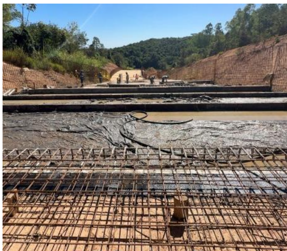
Figura 16 – Controle tecnológico – cura úmida de concreto aplicado em piso
