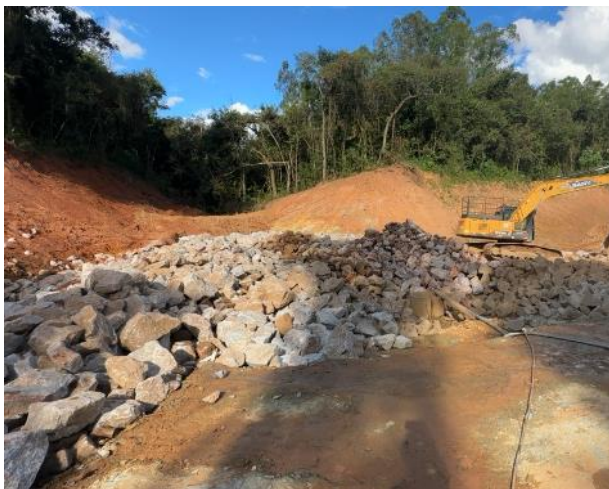
Figura 51 – Aplicação de enrocamento e monitoramento de qualidade da água no desvio provisório do fluxo
