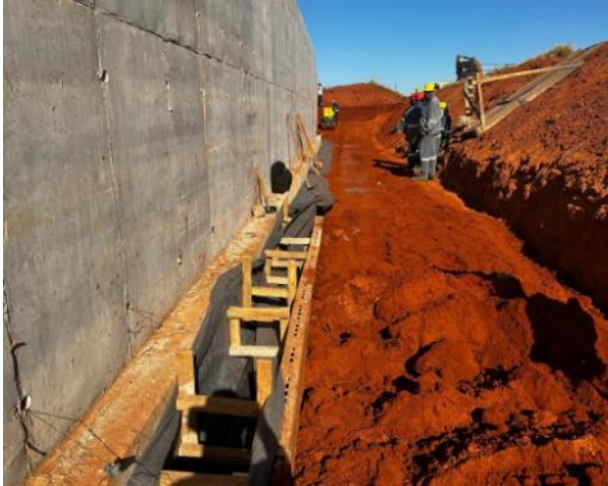
Figura 60 – Execução de formas para execução do dreno e dreno finalizado com reaterro lateral
