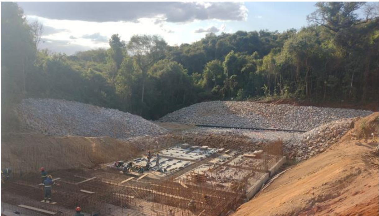
Figura 54 – Vista geral – Finalização da bacia de dissipação.
