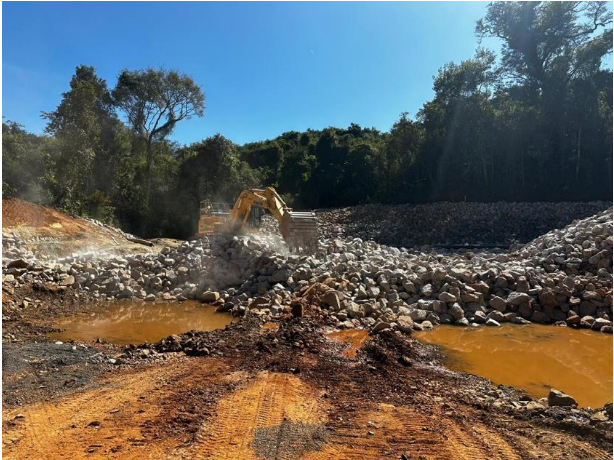
Figura 48 – Aplicação de enrocamento na bacia de dissipação.
