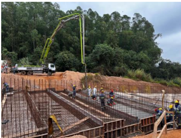
Figura 19 – Aplicação de concreto em piso e piso finalizado – módulo 18
