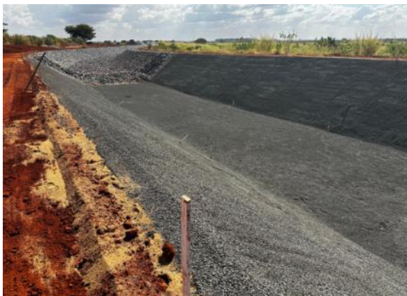
Figura 71 – Aplicação de transição – brita 3 – nas paredes e piso do canal periférico – estaca 68.
