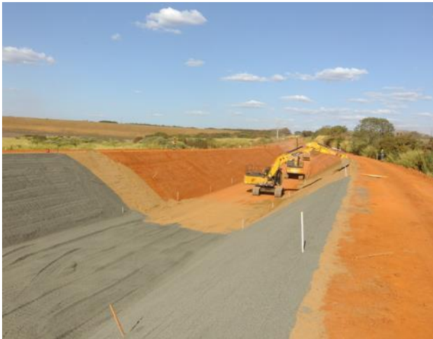
Figura 84 – Aplicação de transições (areia e brita 0) nas paredes e piso canal – estaca 40
