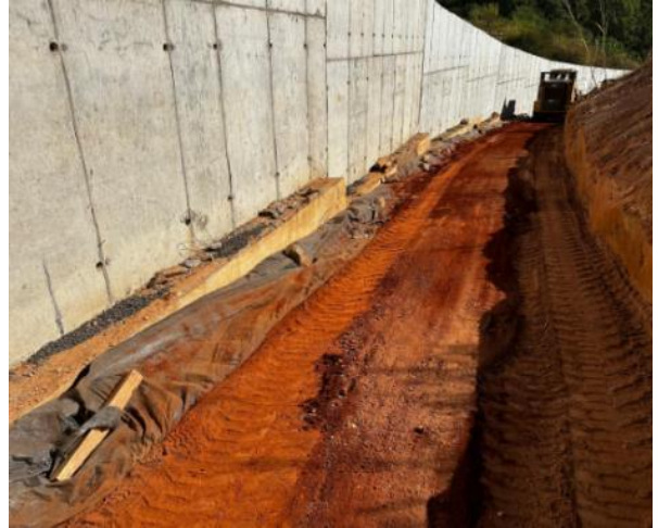
Figura 60 – Execução de formas para execução do dreno e dreno finalizado com reaterro lateral
