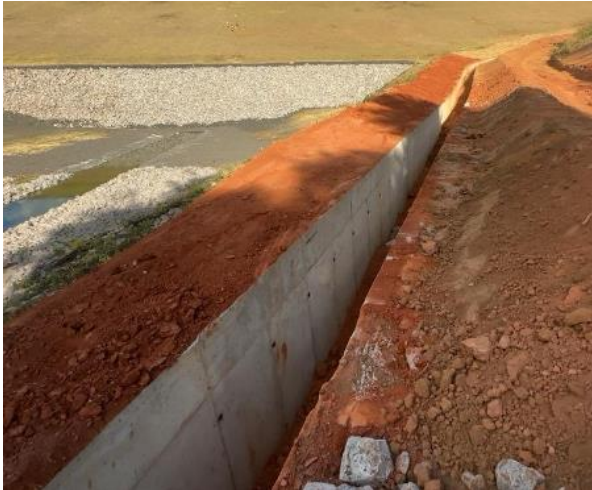
Figura 105 – Reaterro das laterais – canal de drenagem ombreira esquerda e direita.
