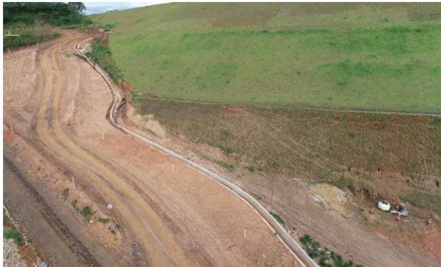
Figura 106 – Vista aérea canal de drenagem – ombreira direita.
