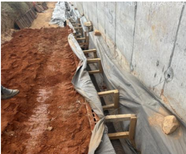
Figura 62 – Execução de formas para execução do dreno e aplicação de brita 0
