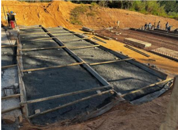
Figura 14 – Aplicação de brita em piso e execução de concreto magro
