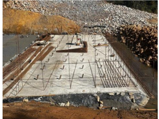
Figura 32 – Montagem de armação após finalização do concreto magro – módulo 07
