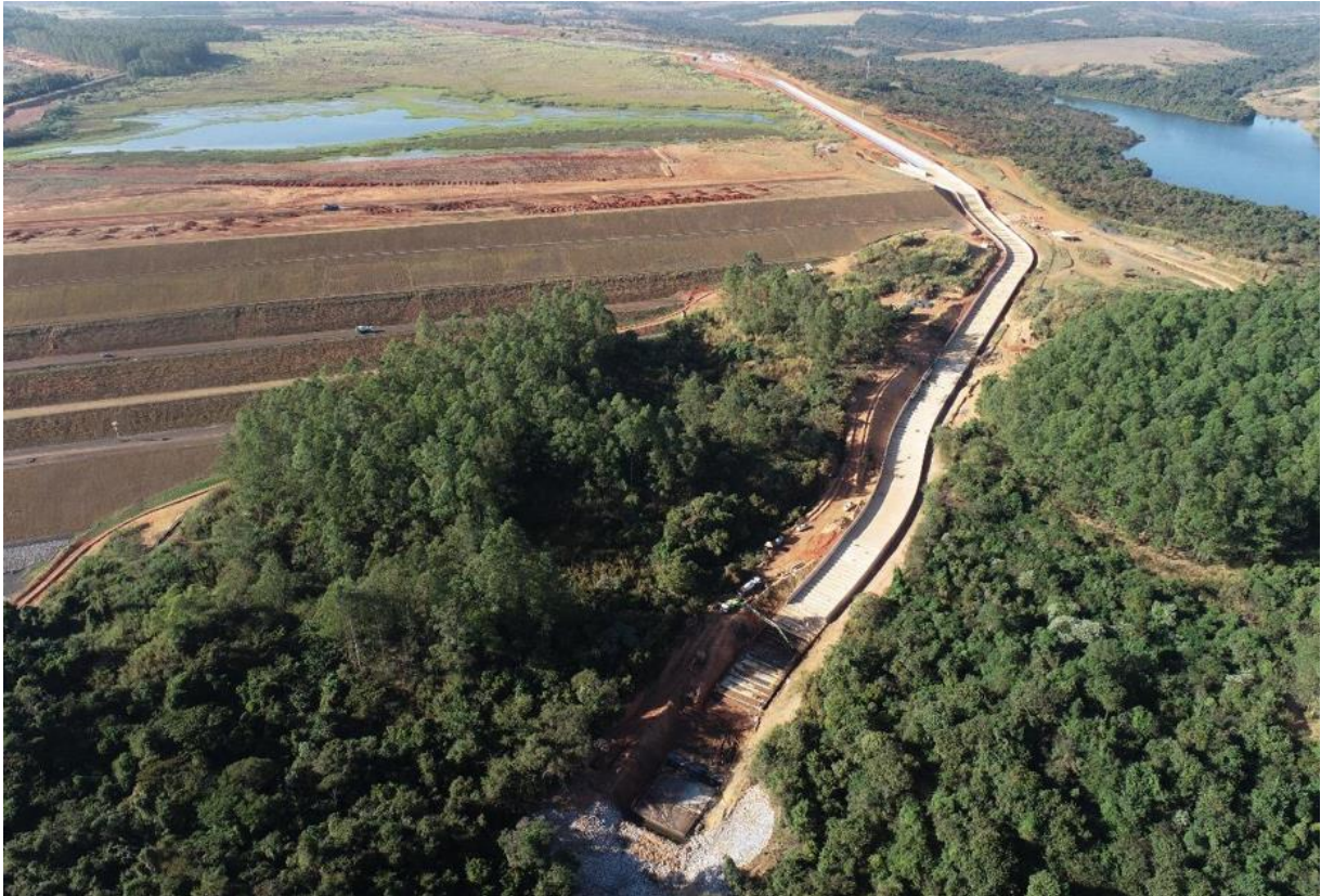
Figura 40 – Avanço geral canal rápido – contemplando trechos inicial e final/bacia de dissipação
