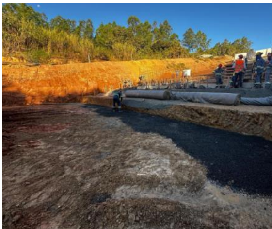
Figura 28 – Execução de drenagem com brita para andamento das atividades e aplicação de geotêxtil em piso – módulo 10
