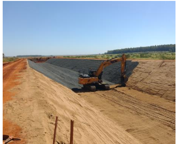
Figura 84 – Aplicação de transições (areia e brita 0) nas paredes e piso canal – estaca 40
