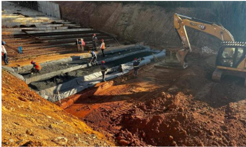
Figura 21 – Escavação, aplicação de geotêxtil e brita em piso – módulo 12
