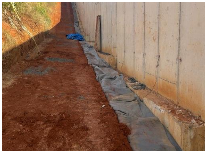
Figura 59 – Execução de formas para execução do dreno e dreno finalizado com reaterro lateral
