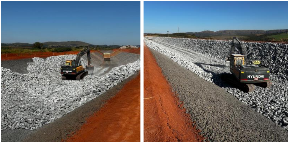
Figura 69 – Aplicação de enrocamento em piso – canal periférico – estacas 60 a 80.
