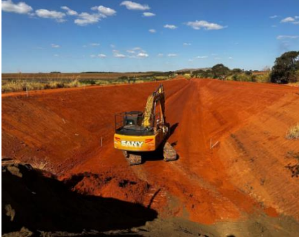
Figura 82 – Conformação de piso e paredes do canal periférico – estaca 43
