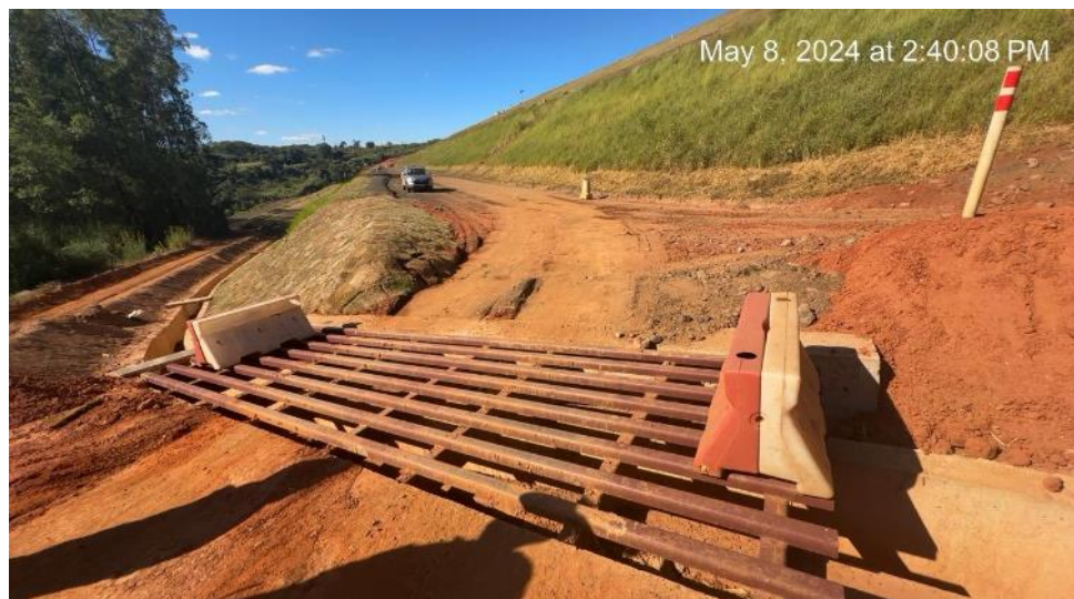
Figura 101 – Travessia tipo “mata-burro” instalada – ombreira esquerda berma 930.
