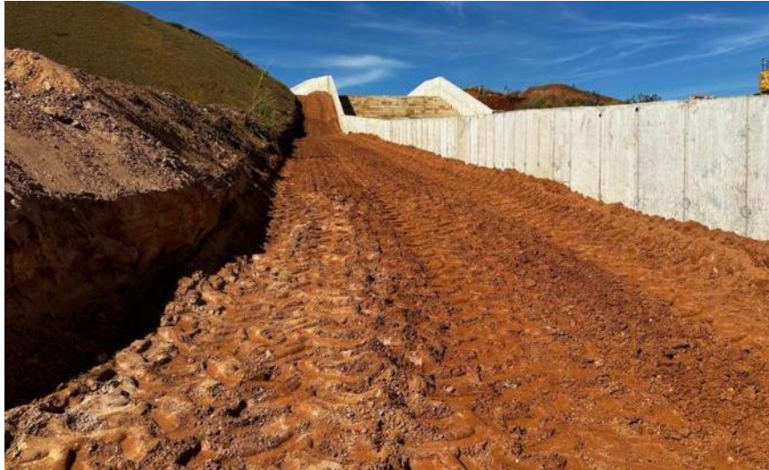
Figura 66 – Reaterro nas laterais do canal sobre dreno lateral.
