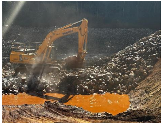
Figura 46 – Aplicação de enrocamento na bacia de dissipação.
