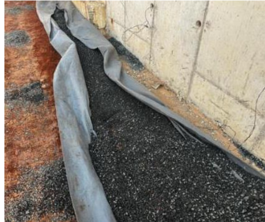
Figura 57 – Execução de dreno lateral – aplicação de geotêxtil e brita 0
