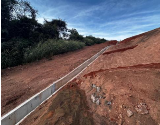
Figura 108 – Reaterro das laterais com direcionamento para fluxo de águas superficiais – ombreira direita.
