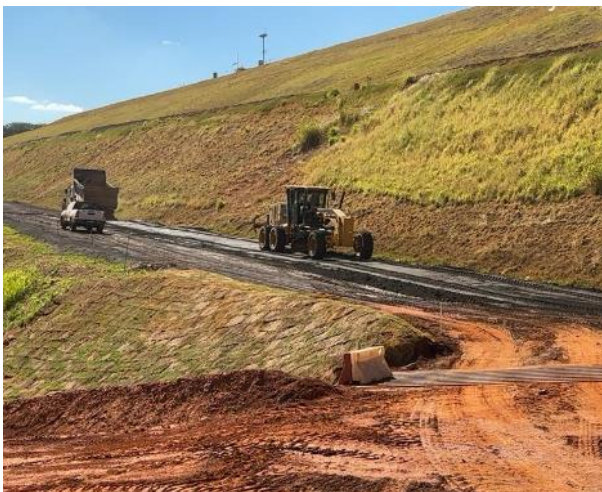
Figura 110 – Regularização de berma para direcionamento das águas superficiais.
