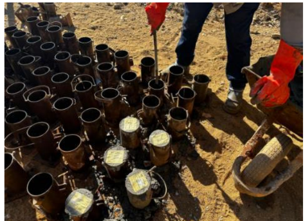
Figura 126 – Controle de qualidade realizado pela fiscalização – Ensaio de “slump test” realizado em concreto e moldagem de corpos de prova para ensaios mecânicos.
