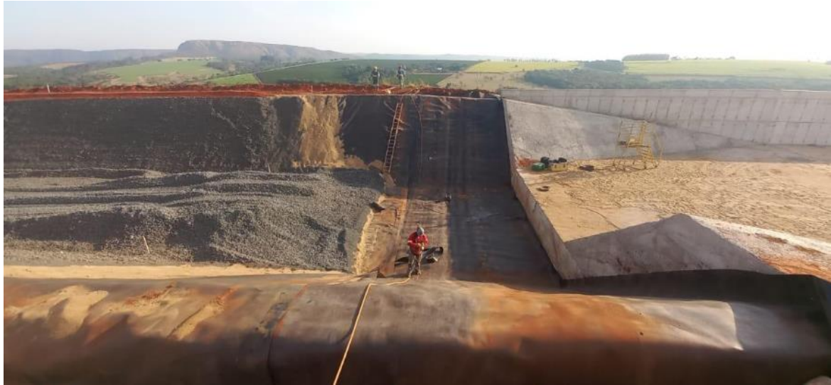
Figura 93 – Aplicação de geomembrana em paredes – vista geral
