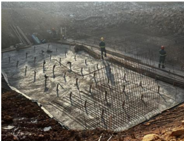
Figura 33 – Montagem de armação em piso – módulo 07
