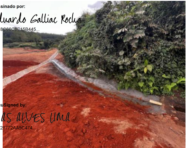
Figura 109 – Execução de pedra argamassada para direcionamento do fluxo de águas do MV.
