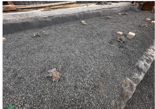
Figura 22 – Execução dos drenos tipo barbancãs e aplicação em piso
