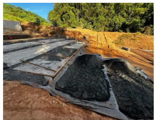
Figura 7 – Execução de concreto magro módulo 12 – início e avanço
