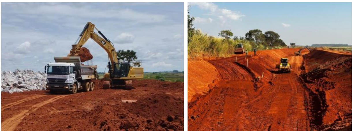
Figura 86 – Escavação, carga e transporte de material e compactação de aterro a 95% PN - estaca 22 a 43
