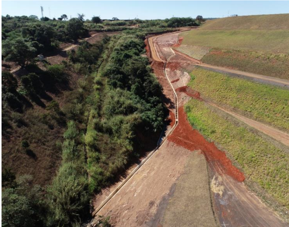
Figura 116 – Vista geral da finalização da implantação do canal de drenagem – ombreira direita
