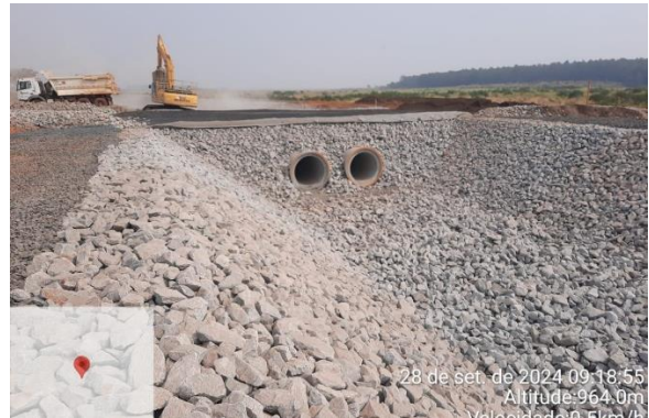
Figura 29 -Execução travessia Canal Periférico
