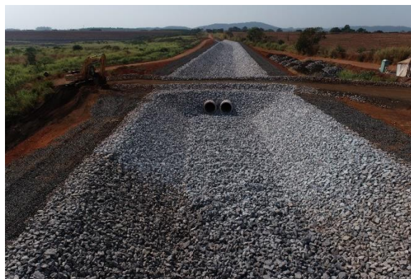
Figura 30 -Travessia Canal Periférico concluída
