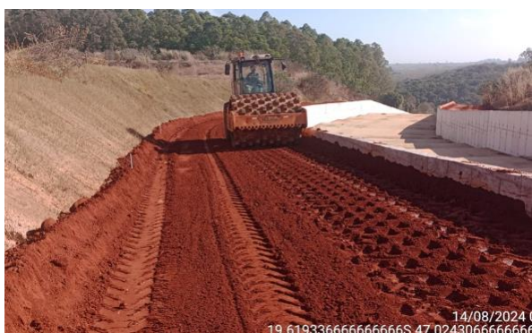
Figura 16 - Reaterro lateral do canal de concreto, incluso escavação, carga e transporte, com compactação manual/mecanizada - Canal Rápido.
