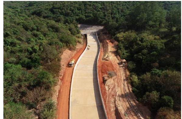
Figura 14 – Bacia de Dissipação concluída
