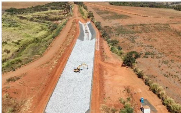
Figura 22 - Aplicação das transições do canal periférico (Areia, Brita 0, Brita 3 e Rachão) - Canal Periférico
