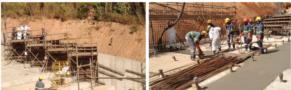
Figura 4 – Concretagem Canal Rápido
