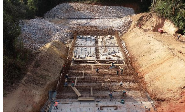
Figura 5 – Concretagem Canal Rápido
