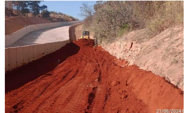
Figura 16 - Reaterro lateral do canal de concreto, incluso escavação, carga e transporte, com compactação manual/mecanizada - Canal Rápido.
