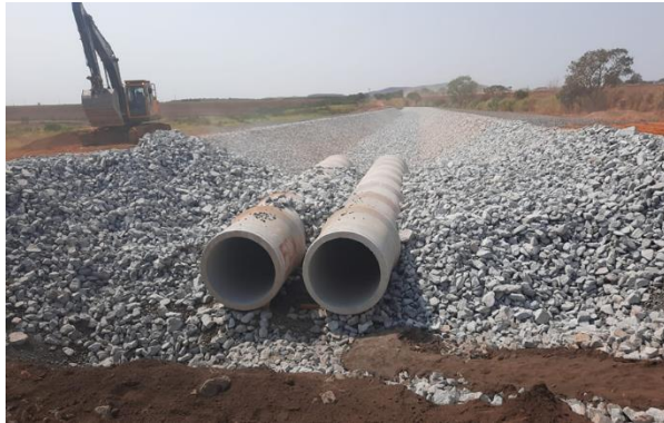
Figura 29 -Execução travessia Canal Periférico
