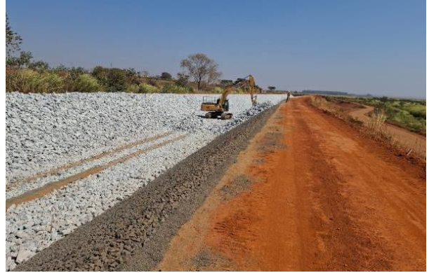
Figura 23 - Aplicação das transições do canal periférico (Areia, Brita 0, Brita 3 e Rachão) - Canal Periférico
