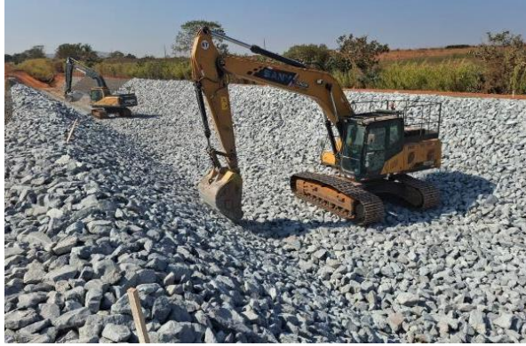
Figura 23 - Aplicação das transições do canal periférico (Areia, Brita 0, Brita 3 e Rachão) - Canal Periférico
