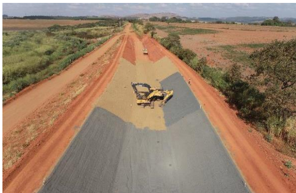
Figura 19 - Aplicação das transições do canal periférico (Areia, Brita 0, Brita 3 e Rachão) - Canal Periférico
