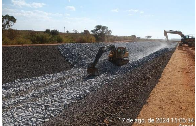
Figura 21 - Aplicação das transições do canal periférico (Areia, Brita 0, Brita 3 e Rachão) - Canal Periférico
