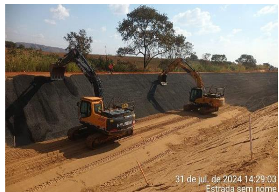
Figura 19 - Aplicação das transições do canal periférico (Areia, Brita 0, Brita 3 e Rachão) - Canal Periférico
