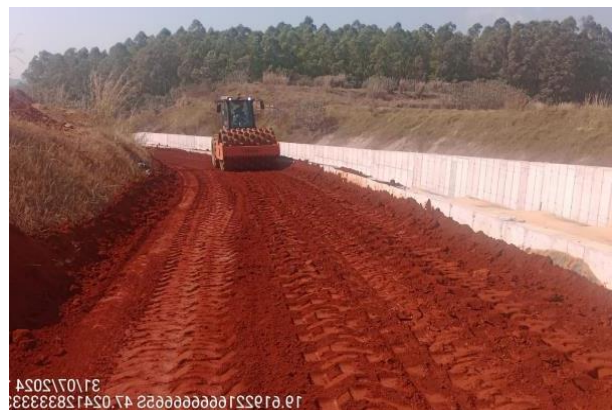
Figura 15 - Reaterro lateral do canal de concreto, incluso escavação, carga e transporte, com compactação manual/mecanizada - Canal Rápido.
