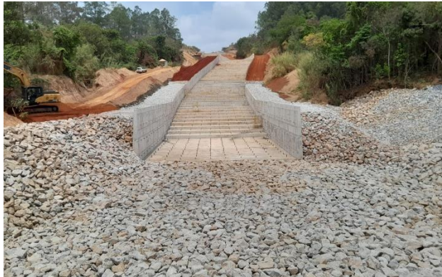
Figura 14 – Bacia de Dissipação concluída
