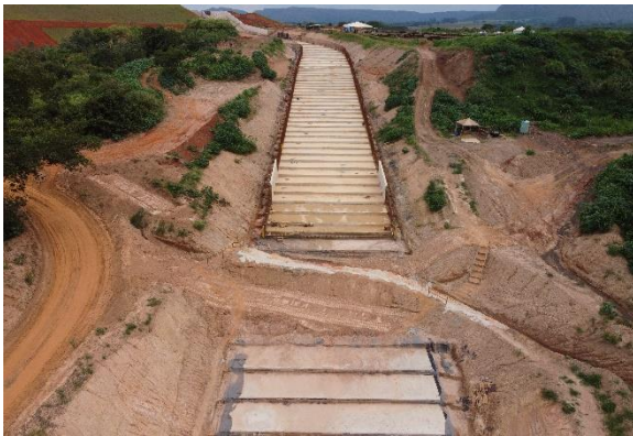
Figura 35 – Leira de proteção e abertura lateral para escoamento do fluxo.
