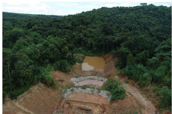
Figura 37 – Escavação, concretagem da laje de piso do canal rápido e proteção com enrocamento no deságue do canal provisório.
