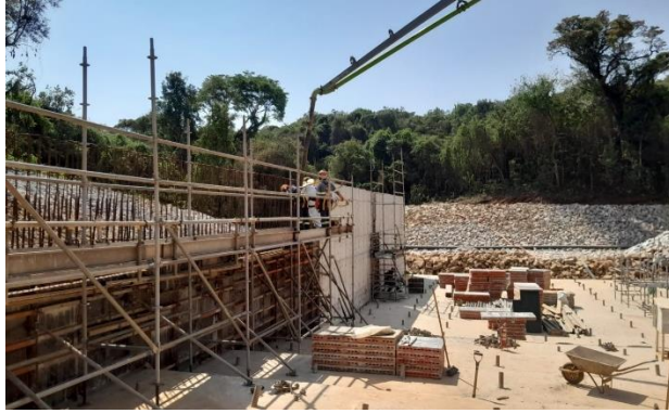
Figura 8 – Concretagem Canal Rápido
