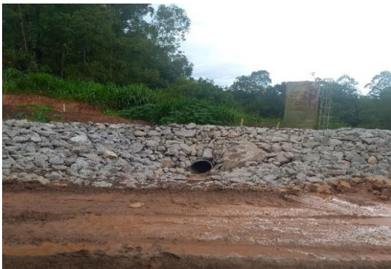
Figura 36 – Construção de passagens molhadas direcionando fluxo para talvegue antigo extravasor na ombreira esquerda e sump existente da ombreira direita.
