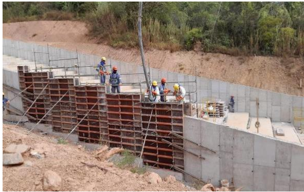
Figura 5 – Concretagem Canal Rápido
