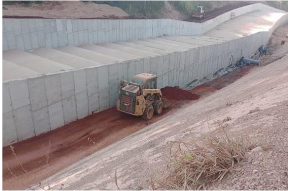
Figura 17 - Reaterro lateral do canal de concreto, incluso escavação, carga e transporte, com compactação manual/mecanizada - Canal Rápido.
