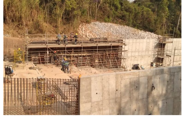
Figura 8 – Concretagem Canal Rápido
