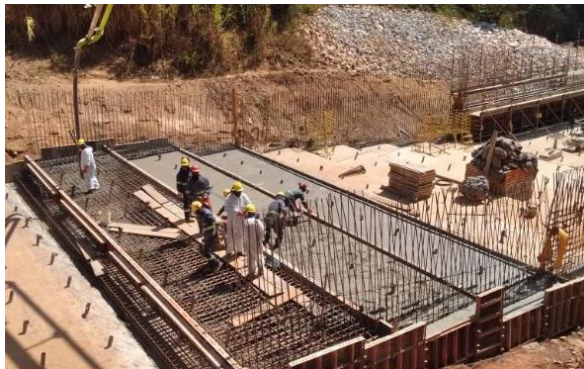
Figura 6 – Concretagem Canal Rápido
