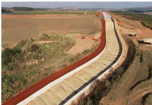
Figura 15 - Reaterro lateral do canal de concreto, incluso escavação, carga e transporte, com compactação manual/mecanizada - Canal Rápido.
