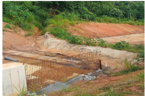
Figura 35 – Leira de proteção e abertura lateral para escoamento do fluxo.
