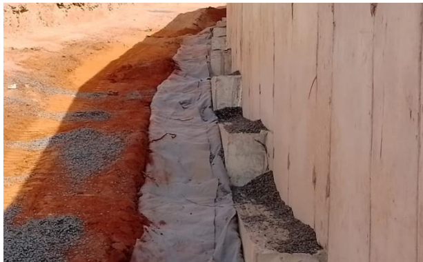
Figura 18- Reaterro lateral do canal de concreto, incluso escavação, carga e transporte, com compactação manual/mecanizada - Canal Rápido.
