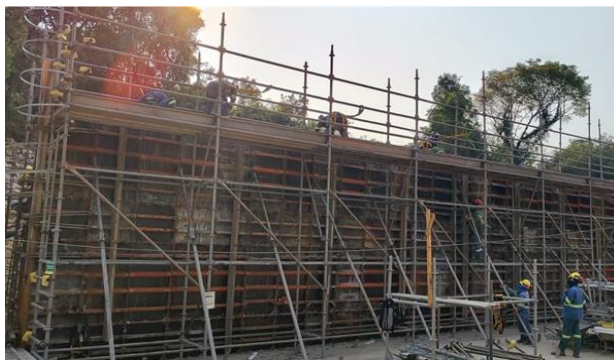
Figura 7 – Formas e armação no Canal Rápido
