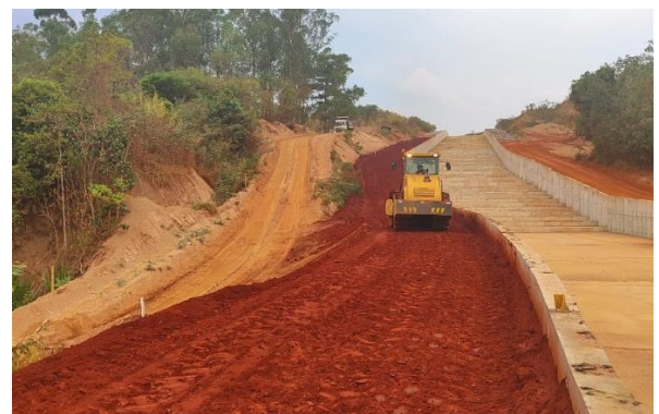
Figura 18- Reaterro lateral do canal de concreto, incluso escavação, carga e transporte, com compactação manual/mecanizada - Canal Rápido.
