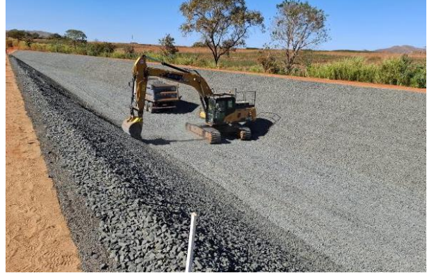
Figura 20 - Aplicação das transições do canal periférico (Areia, Brita 0, Brita 3 e Rachão) - Canal Periférico
