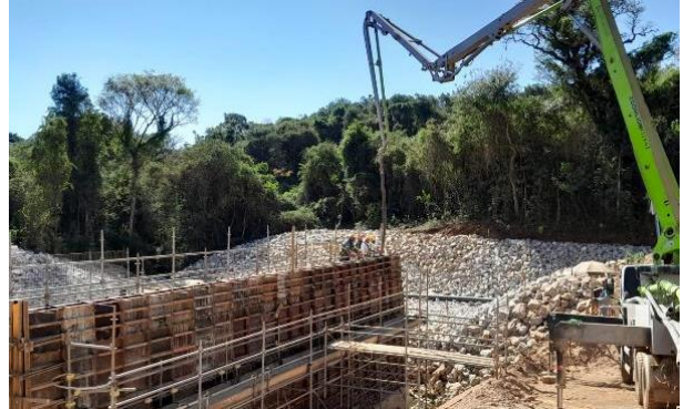
Figura 6 – Concretagem Canal Rápido
