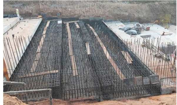
Figura 7 – Formas e armação no Canal Rápido
