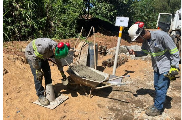
Figura 40 – Controle de qualidade realizado pela fiscalização – Ensaio de “slump test” realizado em concreto.
