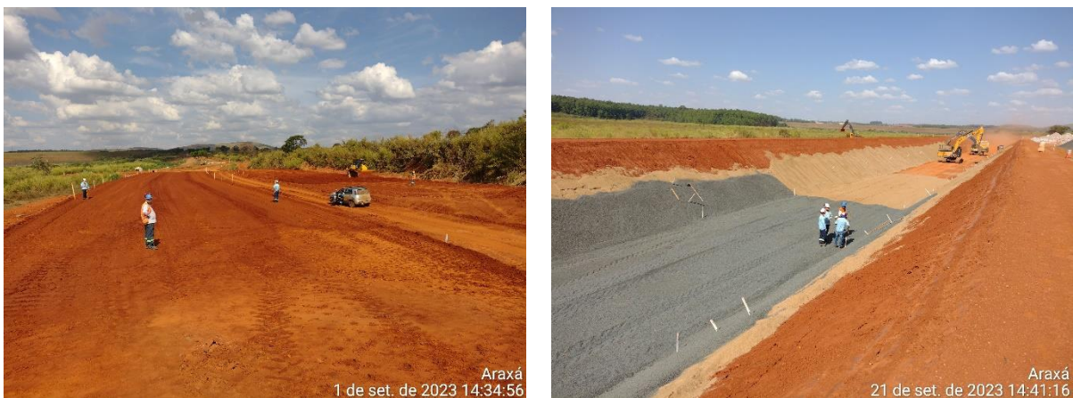
Figura 34 – Equipe de fiscalização topográfica.
