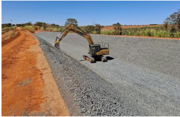
Figura 20 - Aplicação das transições do canal periférico (Areia, Brita 0, Brita 3 e Rachão) - Canal Periférico
