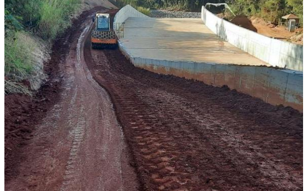
Figura 17 - Reaterro lateral do canal de concreto, incluso escavação, carga e transporte, com compactação manual/mecanizada - Canal Rápido.
