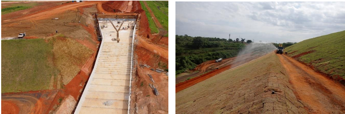
Figura 38 – Plantio de grama próximo ao modulo 65 e em taludes expostos.
