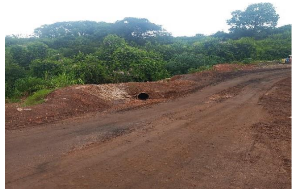
Figura 36 – Construção de passagens molhadas direcionando fluxo para talvegue antigo extravasor na ombreira esquerda e sump existente da ombreira direita.
