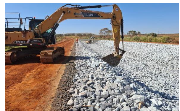
Figura 22 - Aplicação das transições do canal periférico (Areia, Brita 0, Brita 3 e Rachão) - Canal Periférico
