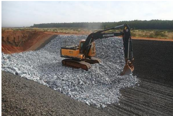
Figura 21 - Aplicação das transições do canal periférico (Areia, Brita 0, Brita 3 e Rachão) - Canal Periférico
