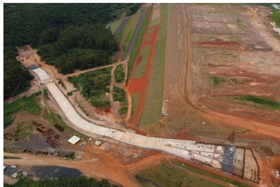
Figura 37 – Escavação, concretagem da laje de piso do canal rápido e proteção com enrocamento no deságue do canal provisório.
