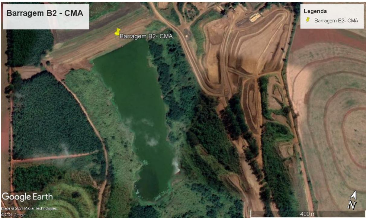
Figura 3.1 – Vista geral aérea da Barragem B2 localizada a montante da Barragem B1B4
