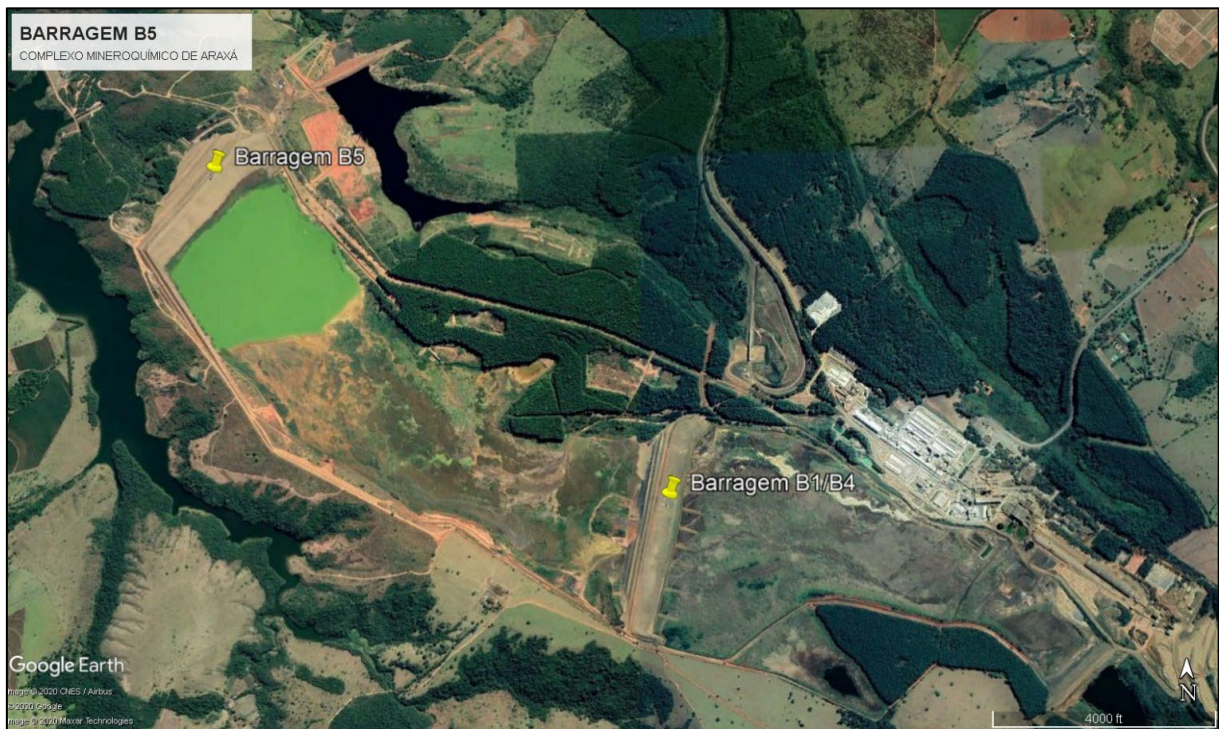
Figura 3.1 - Vista geral aérea da Barragem B5
