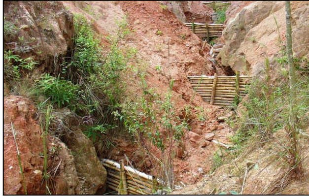
Figura 21-5 - Exemplo de paliçadas rústicas no processo inicial de retenção dos sedimentos (EMBRAPA, 2015)
