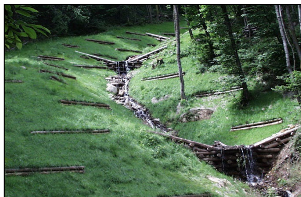
Figura 21-7 - Aplicação integrada de paliçadas ao projeto paisagístico de recomposição ambiental (VERTICAL GREEN, 2022)
