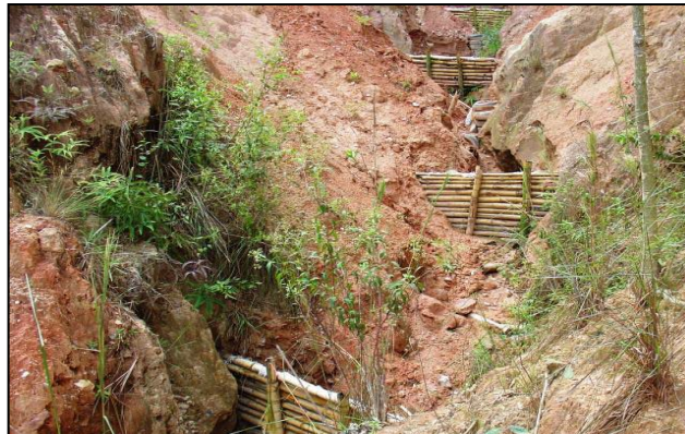
Figura 21-6 - Exemplo de paliçadas rústicas no processo inicial de retenção dos sedimentos (EMBRAPA, 2015)
